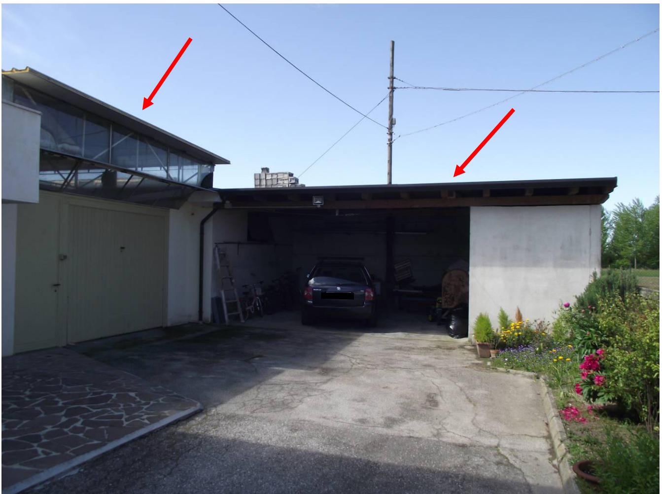
Foto 37 – deposito e autorimessa (frecche rosse) abusive
