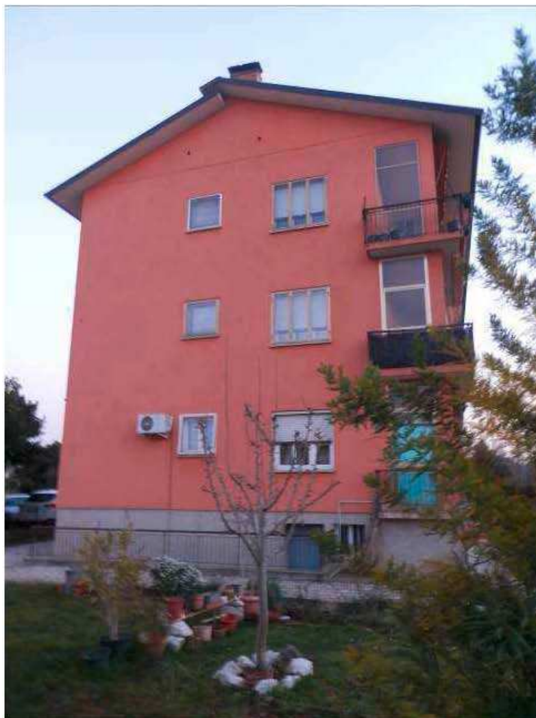
Foto 3: Fabbricato condominiale lato Sud.
