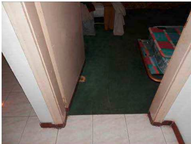
Foto 17-18: Camere e locale caldaia.
