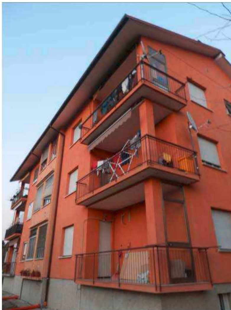
Foto 4: Fabbricato condominiale lato Sud-Ovest.
