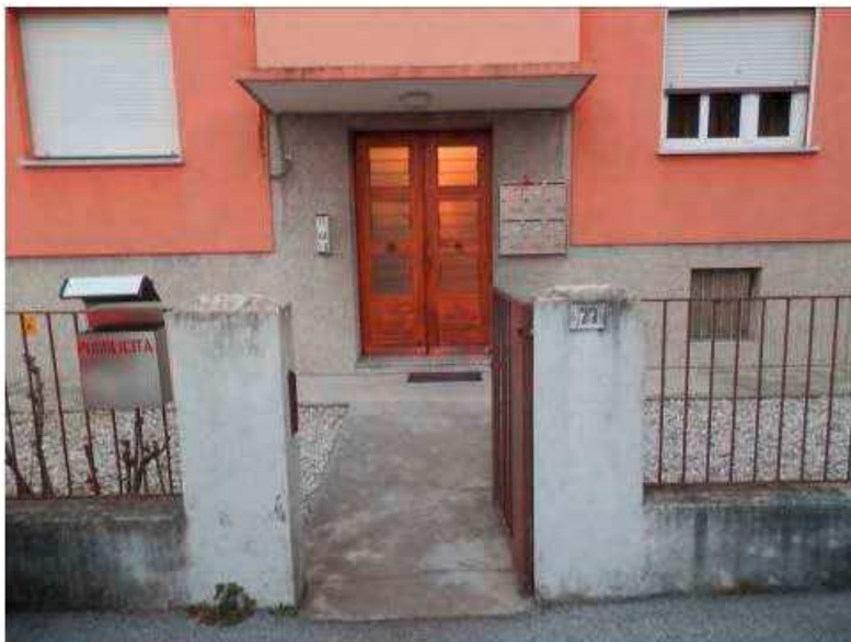
Foto 3-6: Ingresso condominio e accesso carrajo.
