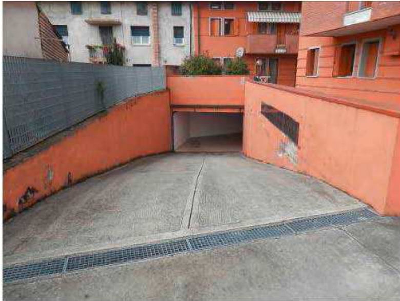
Foto 19-20: Ingresso e unità garage.
