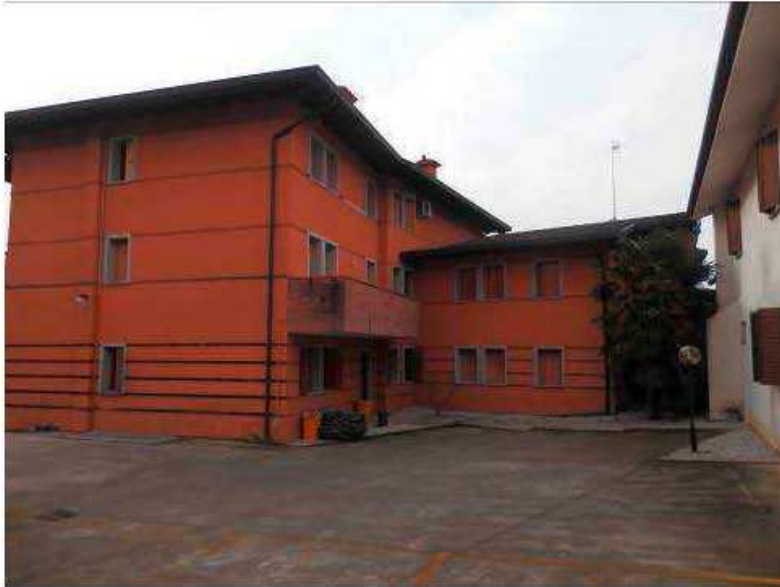
Foto 3-4: Complesso residenziale lato Nord-Est.
