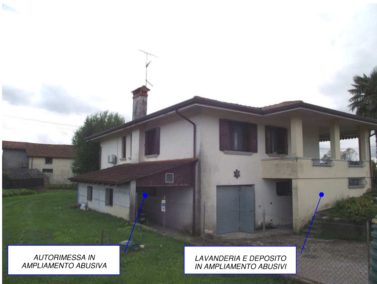
Foto 4 - prospetto laterale, zona garage
