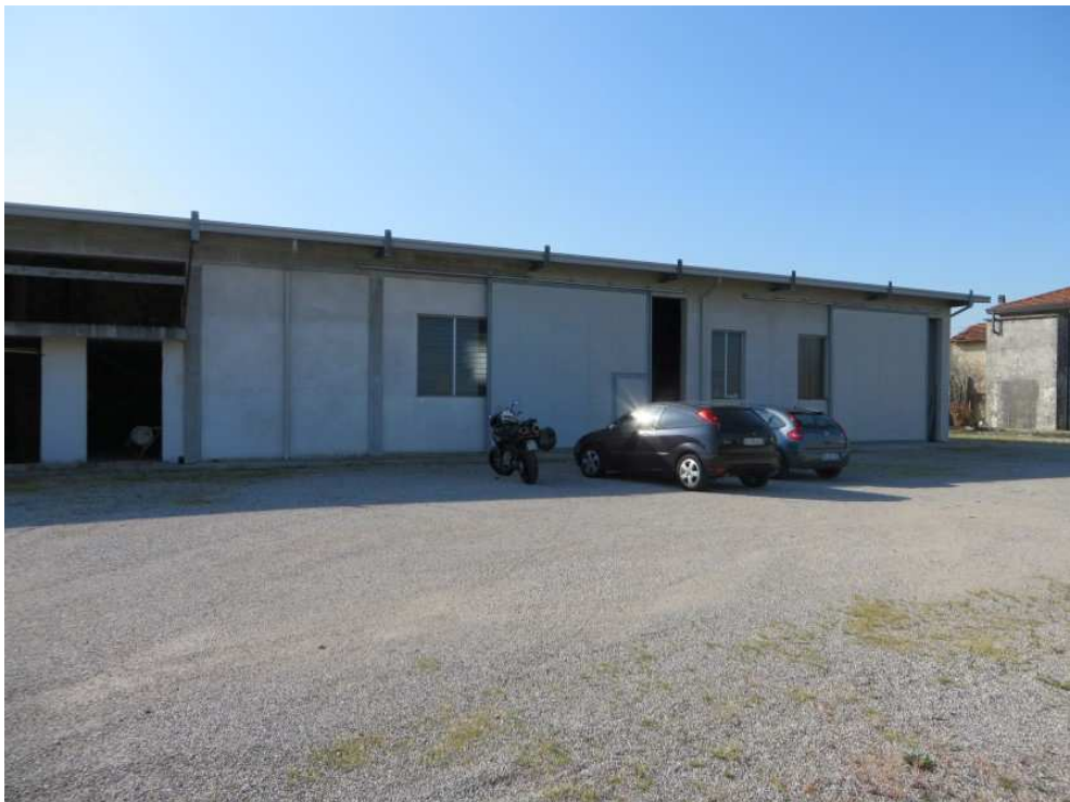
FOTO 2: PANORAMICA FRONTALE DEL FABBRICATO
