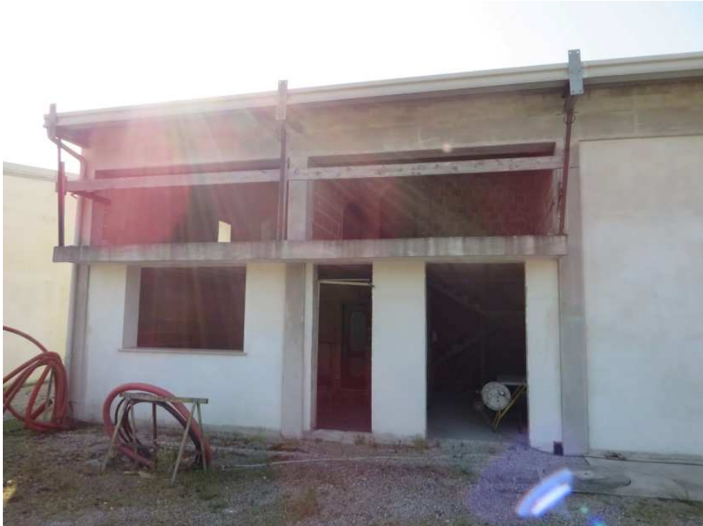
FOTO 7: PARTICOLARE PORZIONE SU 2 LIVELLI DI PIANO
