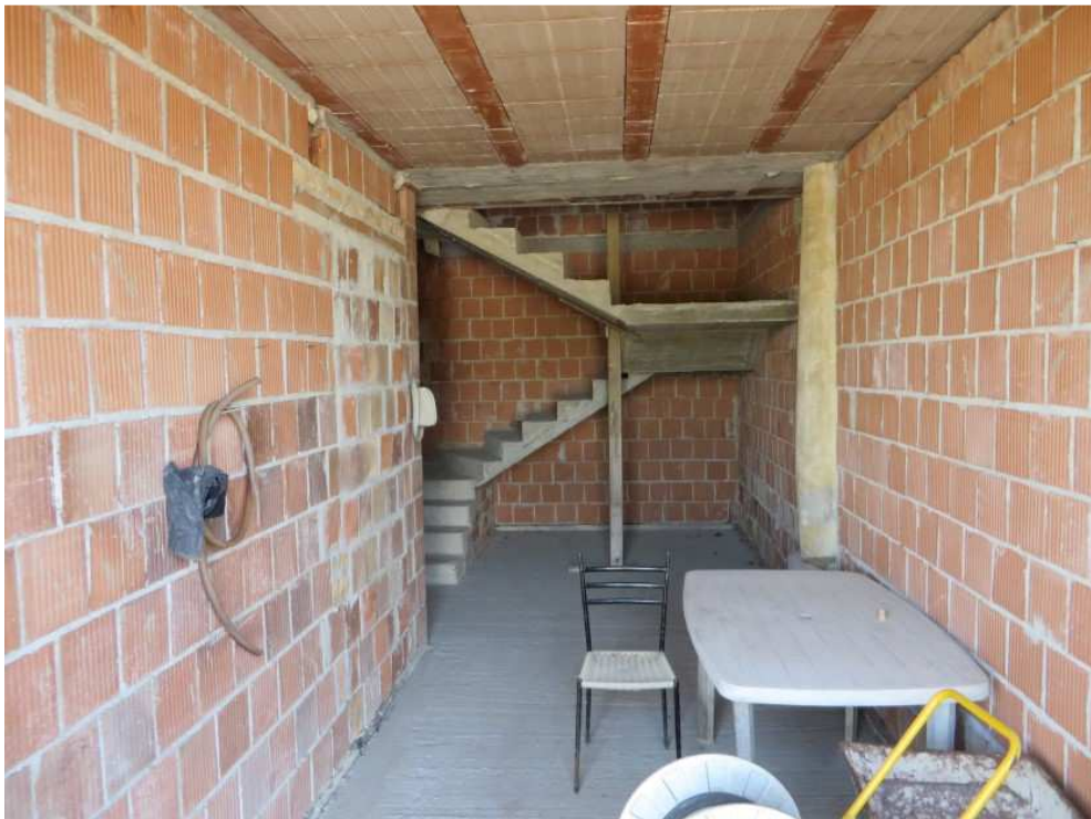
FOTO 14: ACCESSO DAL PIANO TERRA AI VANI DEL PIANO PRIMO
