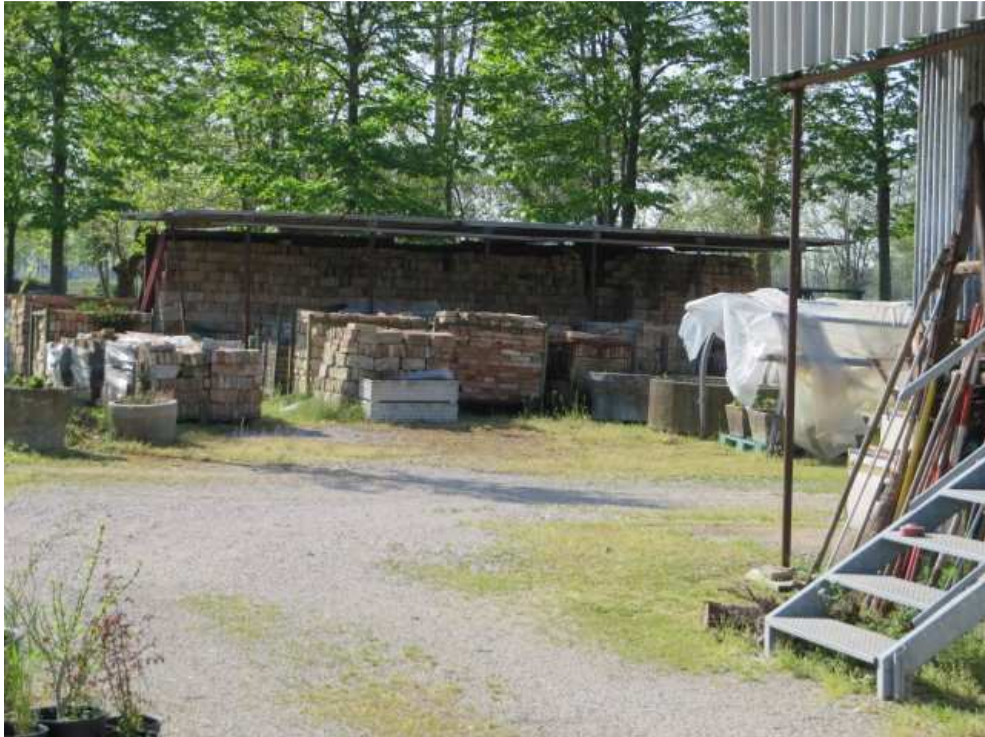
FOTO 51: TETTOIA NON CENSITA
