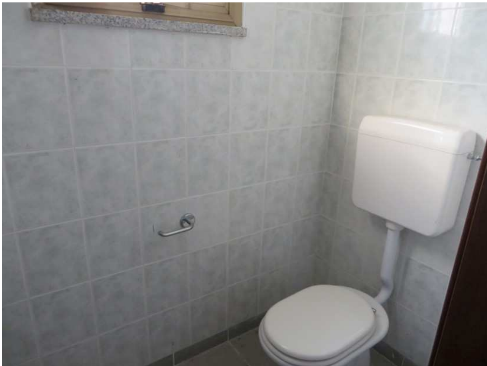
FOTO 10: BAGNO DELLA ZONA UFFICI (Piano Terra)
