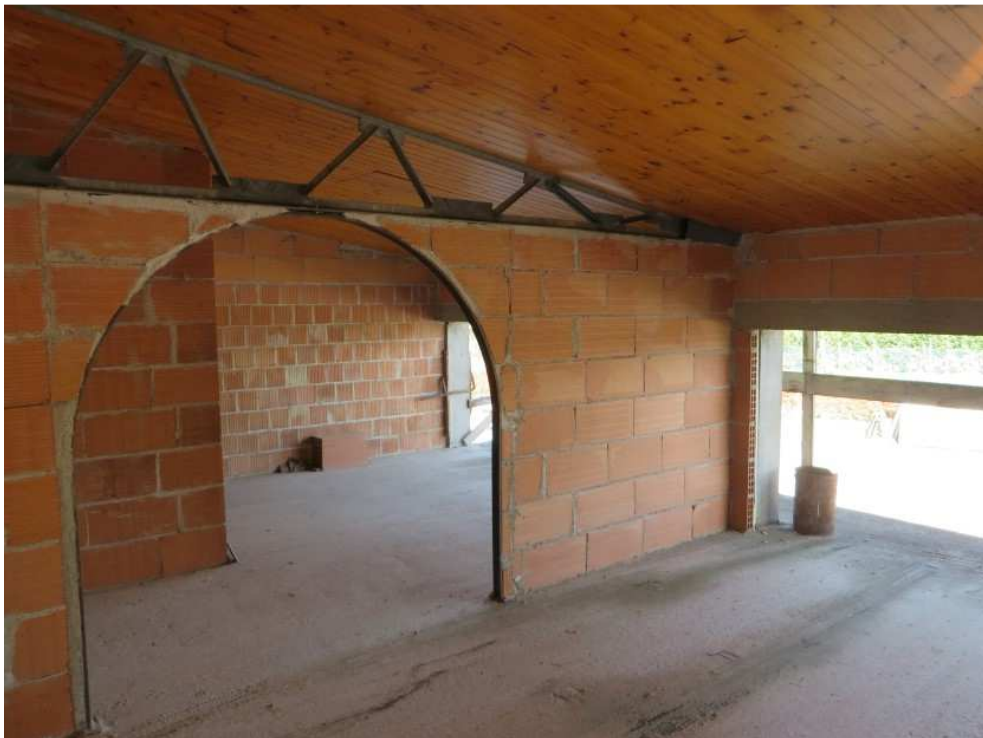
FOTO 16: PORTICATO FRONTE STRADA (Piano Primo)
