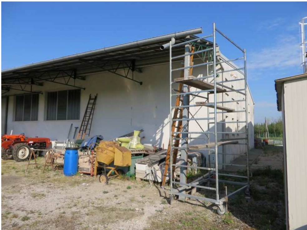
FOTO 4: PANORAMICA LATERALE E POSTERIORE DEL FABBRICATO
