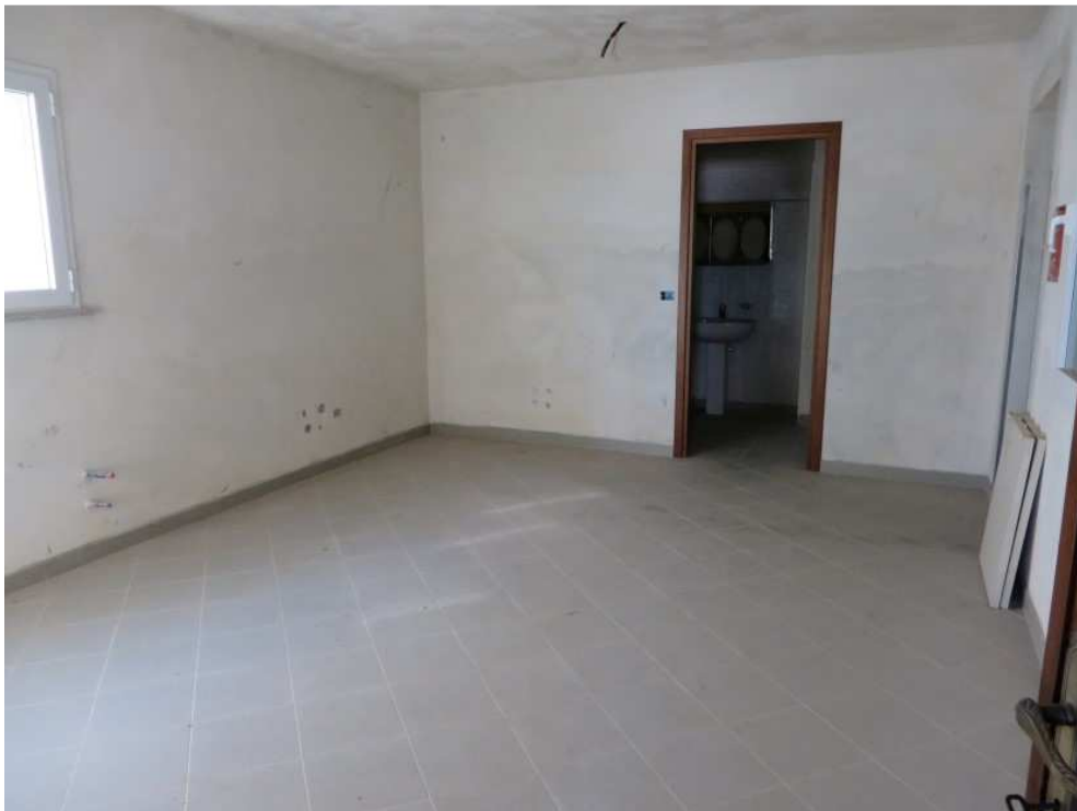
FOTO 8: ZONA UFFICI (Piano Terra)
