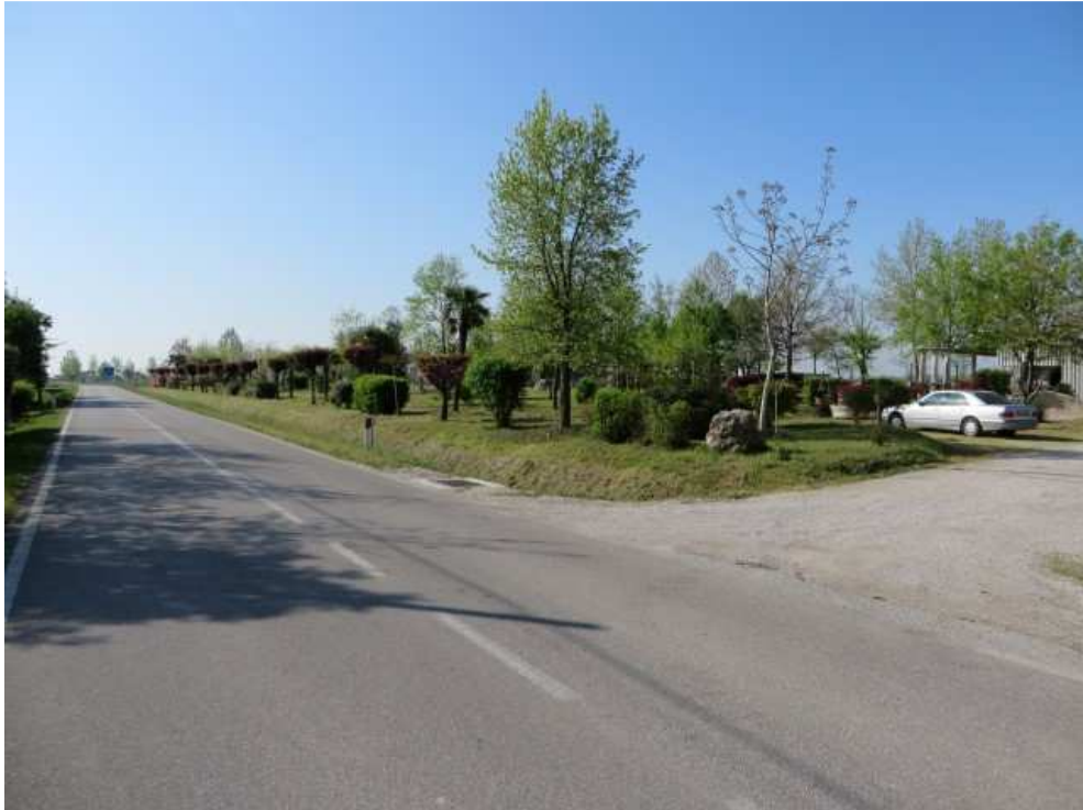
FOTO 33: PANORAMICA DALLA STRADA DEI MAPP. 366 E 367
