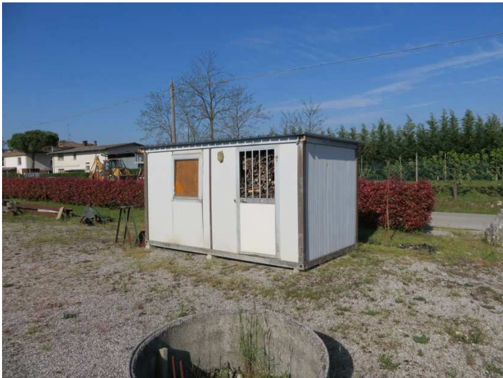
FOTO 22: BOX IN LAMIERA DA CANTIERE NON CENSITO
