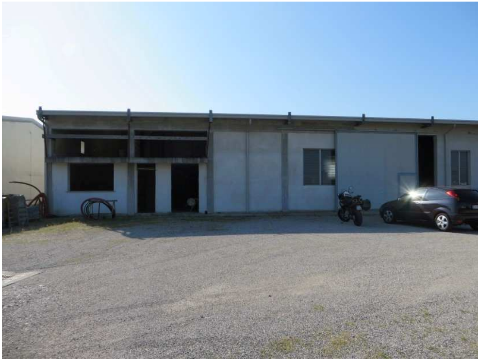
FOTO 1: PANORAMICA FRONTALE DEL FABBRICATO
