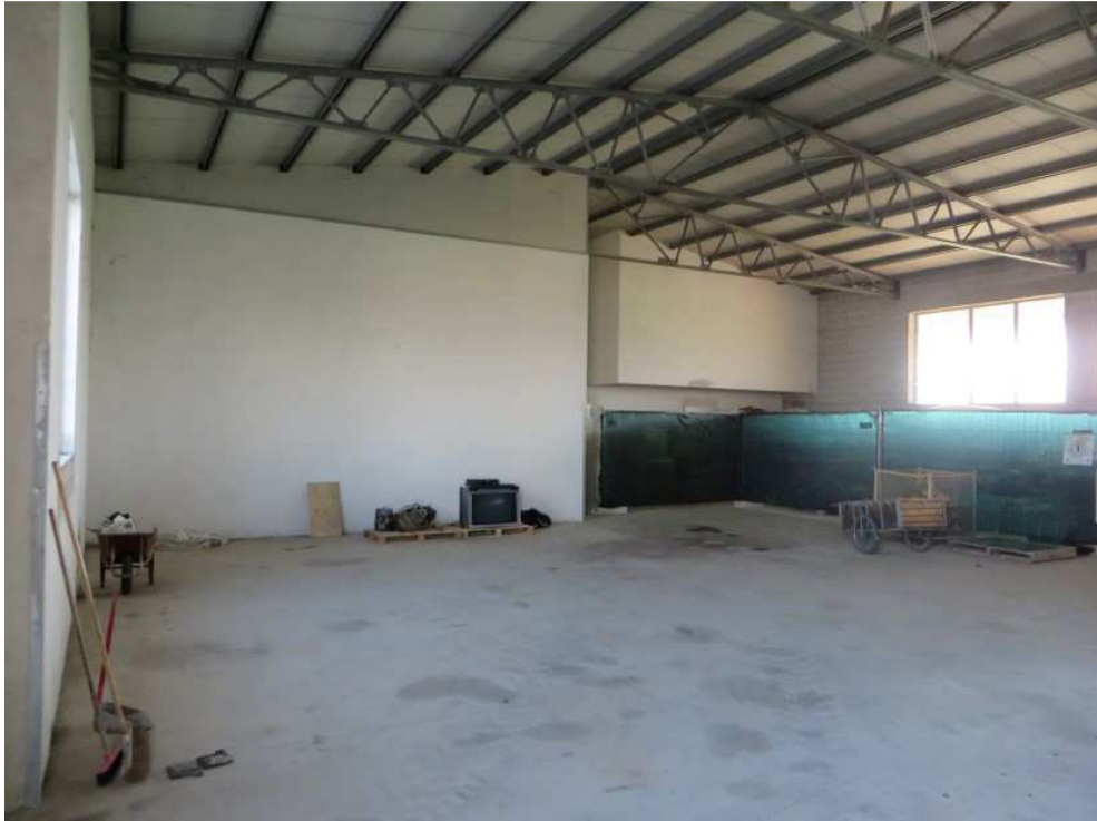
FOTO 5: INTERNO ZONA MAGAZZINO – DEPOSITO ATTREZZI
