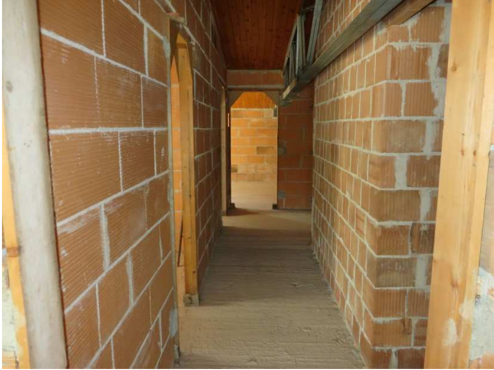
FOTO 17: DISIMPEGNO (Piano Primo)
