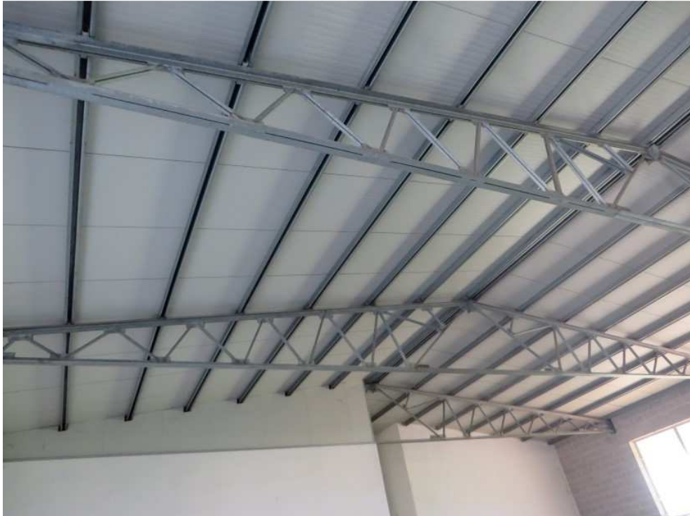
FOTO 13: PARTICOLARE COPERTURA INTERNA SU ZONA MAGAZZINO
