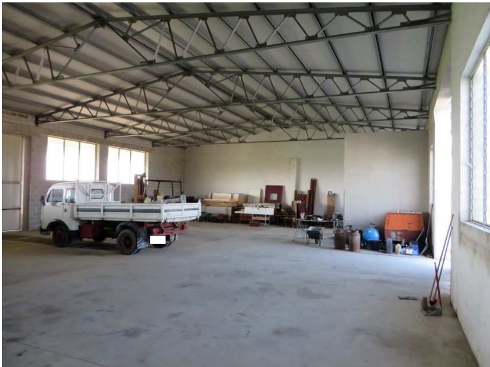
FOTO 6: INTERNO ZONA MAGAZZINO – DEPOSITO ATTREZZI
