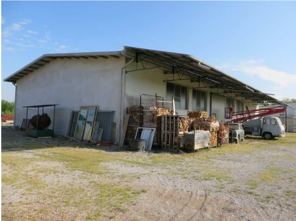
FOTO 3: PANORAMICA LATERALE E POSTERIORE DEL FABBRICATO
