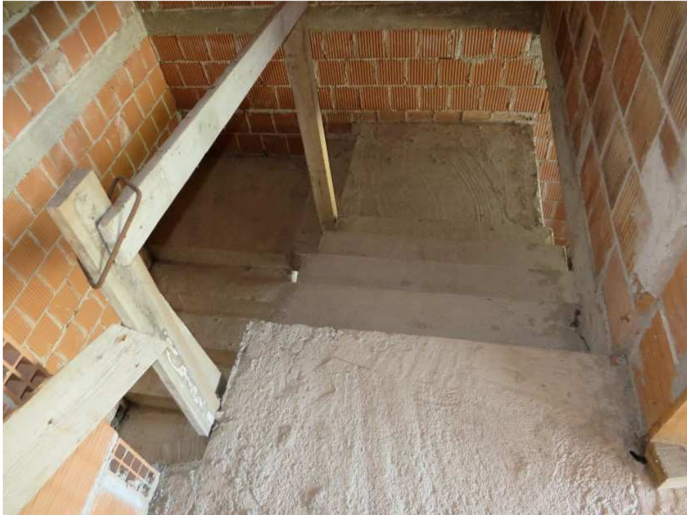
FOTO 15: VANO SCALE AL GREZZO TRA P.T. E 1°P.
