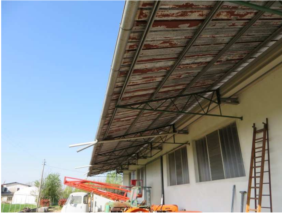
FOTO 21: TETTOIA ESTERNA POSTERIORE
