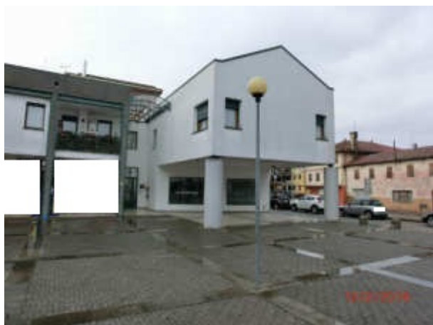
particolare prospetto Est del fabbricato -prospetto principale-
