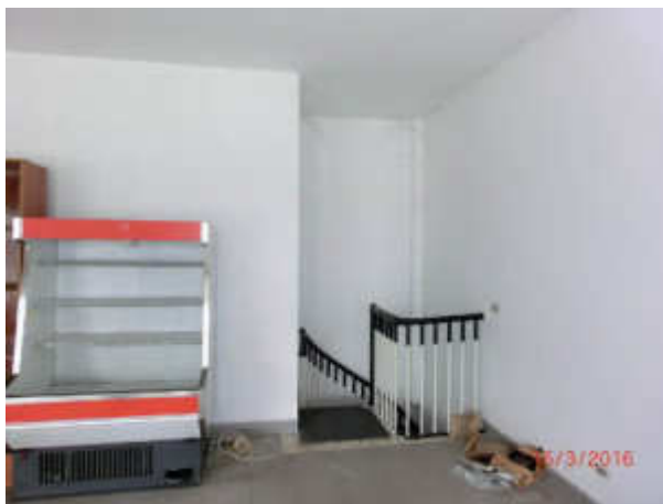
particolari vista interna del locale negozio
