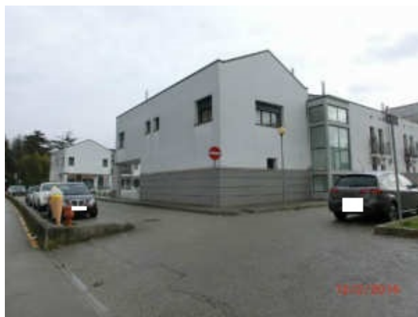
particolare prospetto Nord/Ovest del fabbricato -prospetti laterali-
