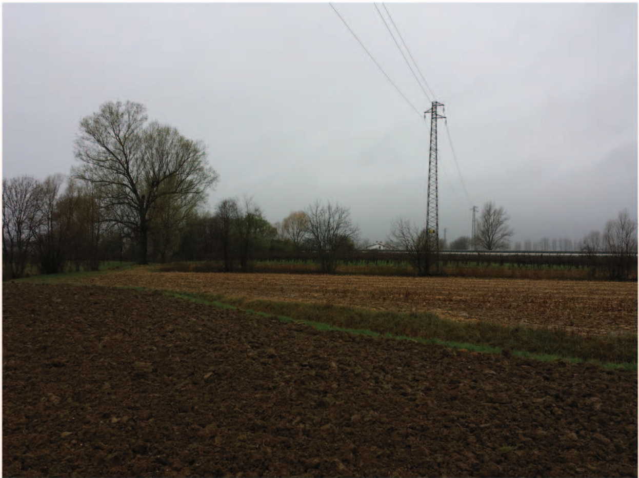
vista complessiva con elettrodotto
