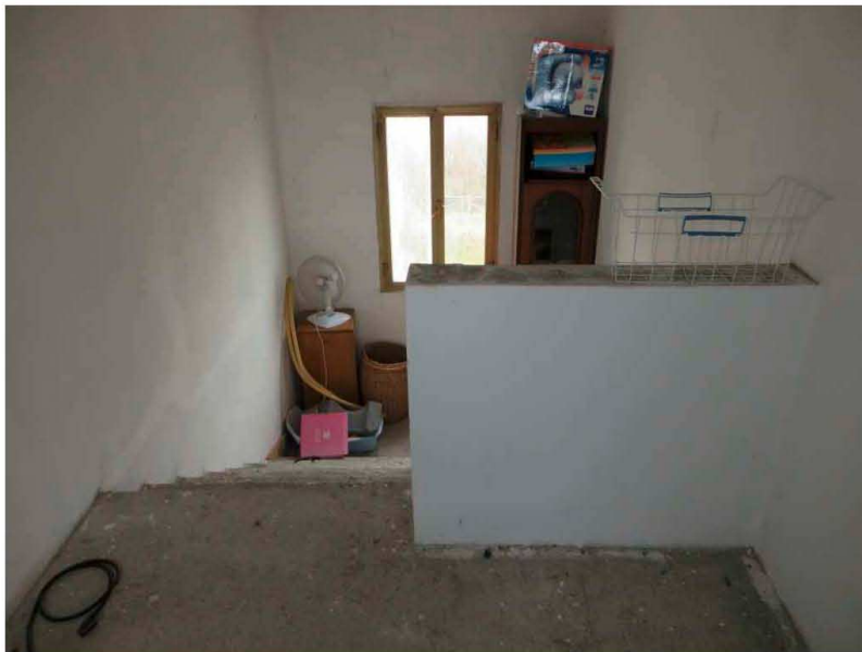
FOTO 14: VANO SCALE (Secondo Piano)
