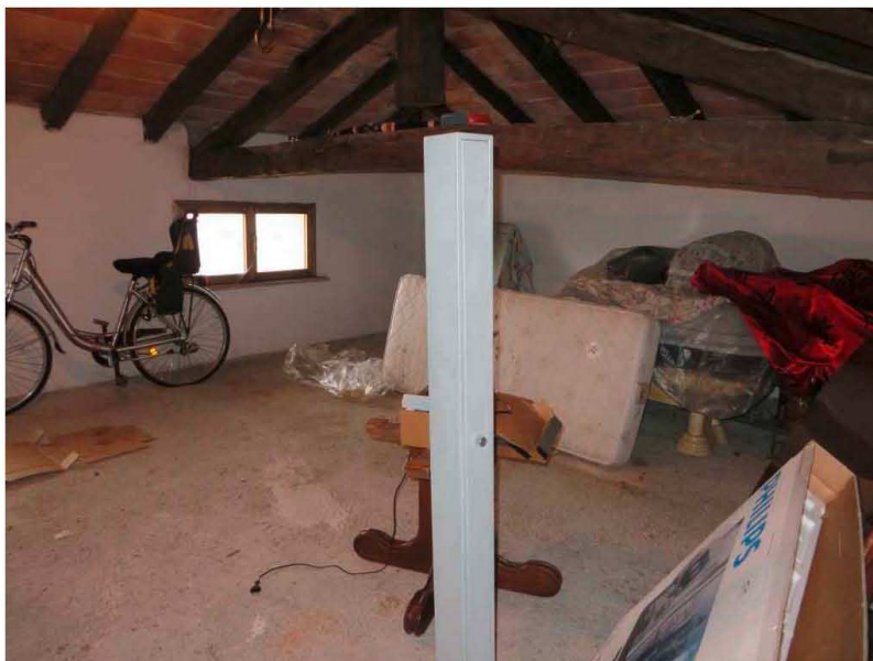
FOTO 16: SOFFITTA (Secondo Piano)
