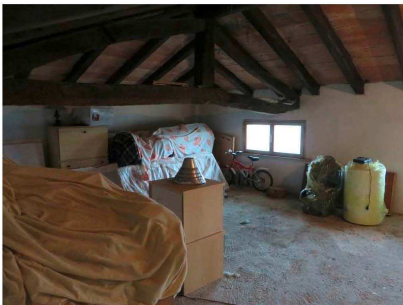
FOTO 15: SOFFITTA (Secondo Piano)
