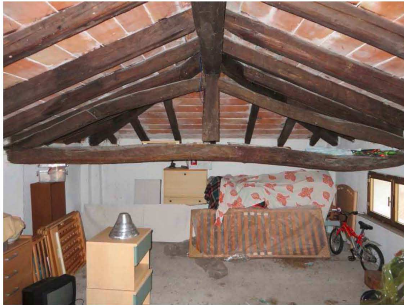
FOTO 17: SOFFITTA (Secondo Piano)
