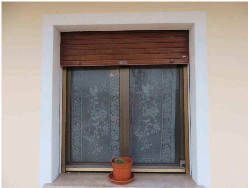
FOTO 20: SERRAMENTO (Piano Terra)
