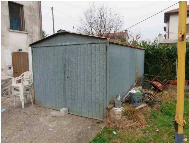
FOTO 22: BOX IN LAMIERA ABUSIVO
