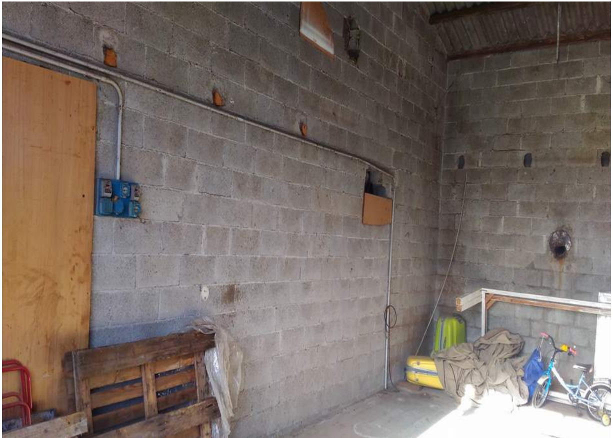
Foto n° 39 - 05/01/2017 - Comune di Concordia Sagittaria, foglio 13, part. 634 - Interno del vano di superficie inferiore del fabbricato ex-falegnameria. Visibile l'impianto elettrico.
