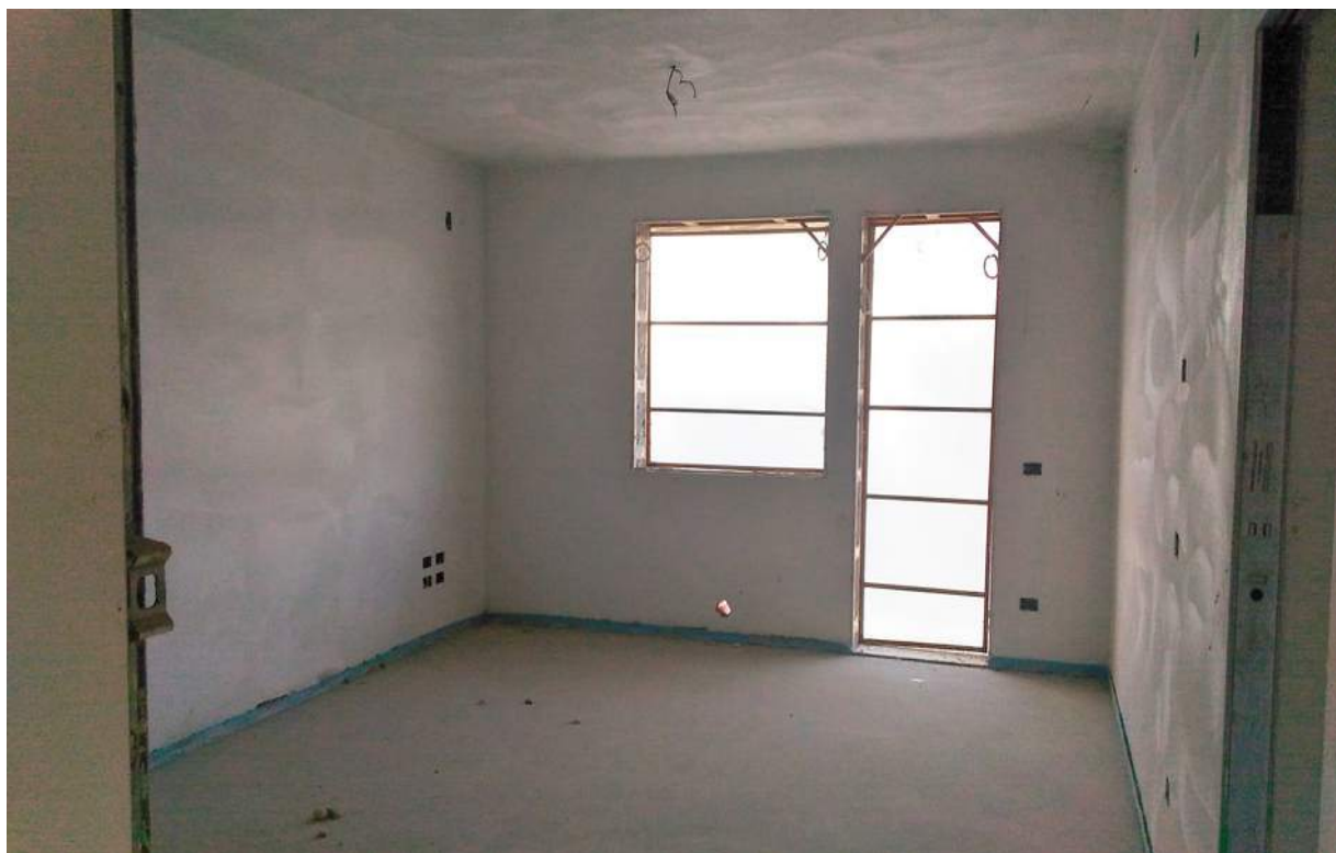
Foto n° 17 - 05/01/2017 - Comune di Concordia Sagittaria, foglio 13, part. 465, sub.6 – Stanza nei disegni di progetto identificata come cucina/soggiorno. Sullo sfondo visibile la porta che da accesso alla terrazza esterna ad uso esclusivo.
