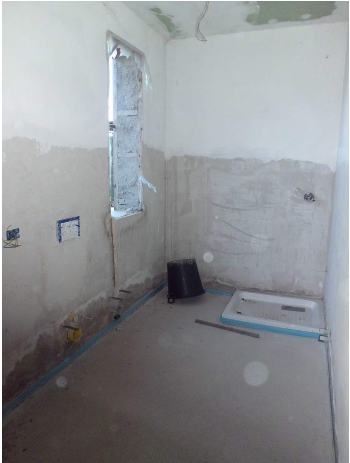
Foto n° 16 - 05/01/2017 - Comune di Concordia Sagittaria, foglio 13, part. 465, sub.5 - Bagno.
