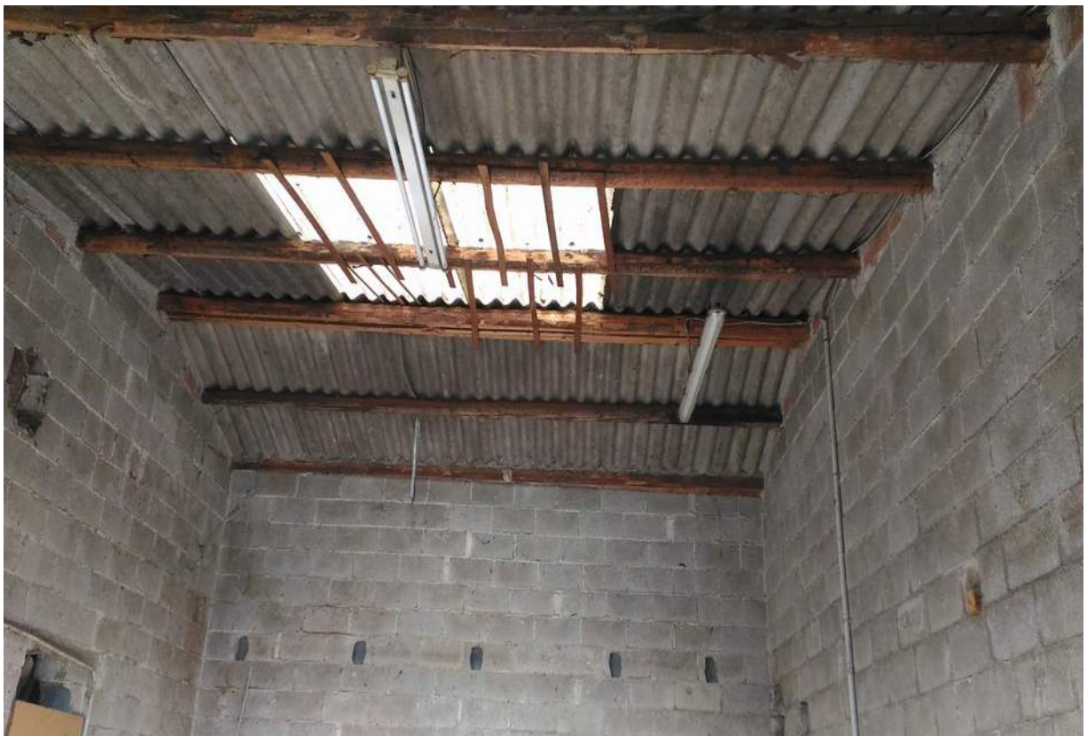
Foto n° 40 - 05/01/2017 - Comune di Concordia Sagittaria, foglio 13, part. 634 - Particolare del tetto di copertura del fabbricato ex-falegnameria.
