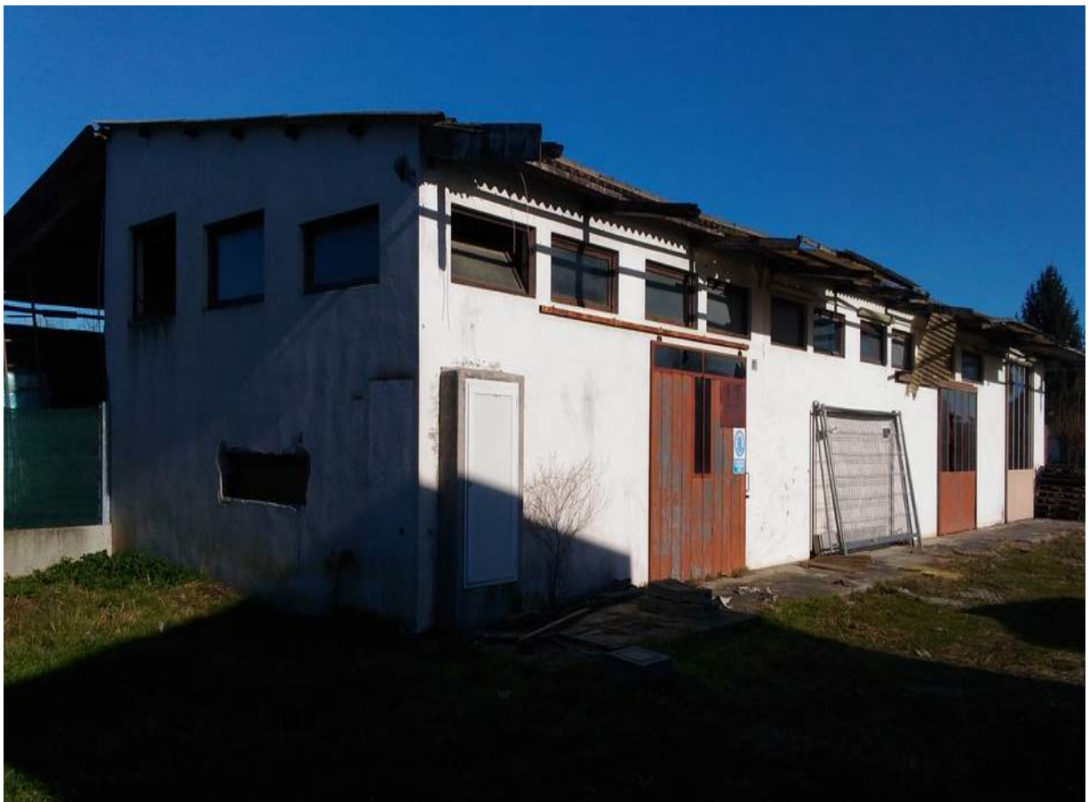
Foto n° 34 - 05/01/2017 - Comune di Concordia Sagittaria, foglio 13, part. 634 – Visione esterna del fabbricato ex falegnameria.
