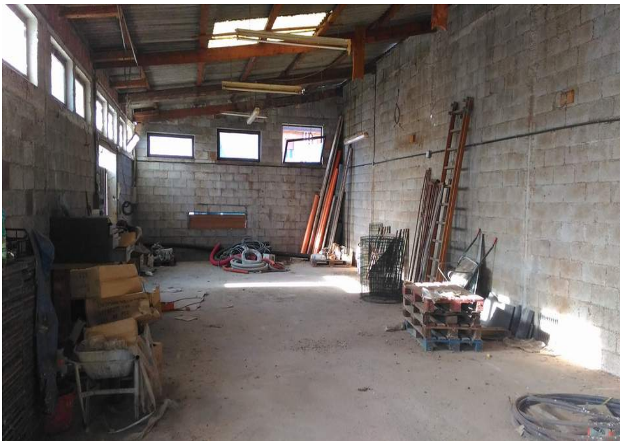
Foto n° 37 - 05/01/2017 - Comune di Concordia Sagittaria, foglio 13, part. 634 - Interno del fabbricato ex-falegnameria. Visibile il tetto in eternit.
