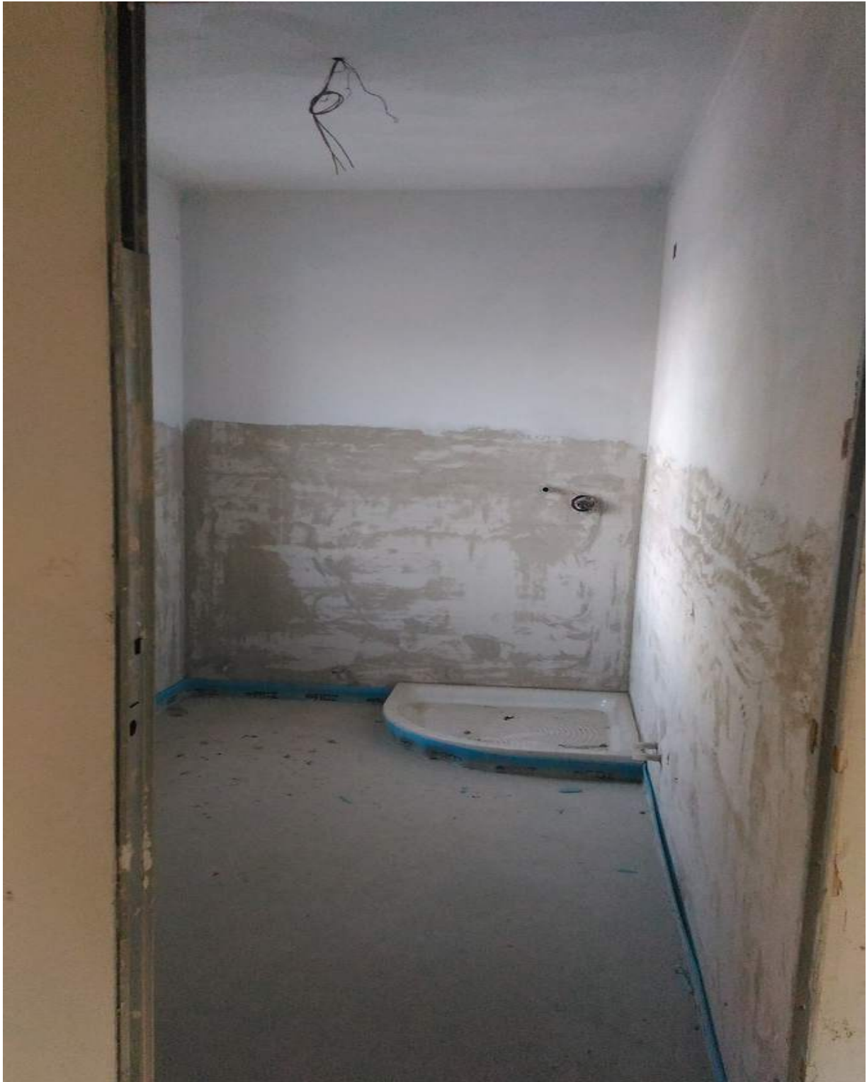
Foto n° 28 - 05/01/2017 - Comune di Concordia Sagittaria, foglio 13, part. 465, sub.7 - Bagno.
