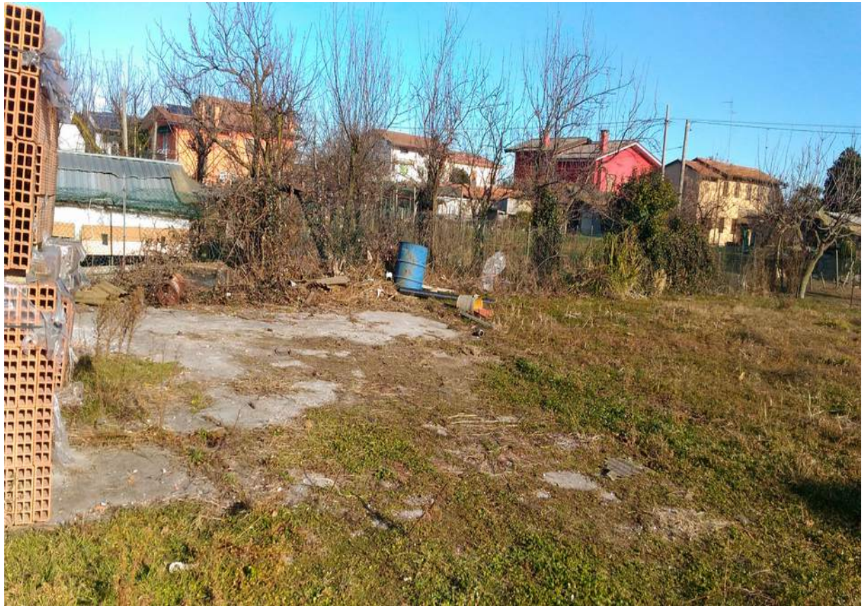
Foto n° 35 - 05/01/2017 - Comune di Concordia Sagittaria, foglio 13, part. 634 - Platea in cemento su cui era edificato l'immobile catastalmente identificato come magazzino e ora demolito.
