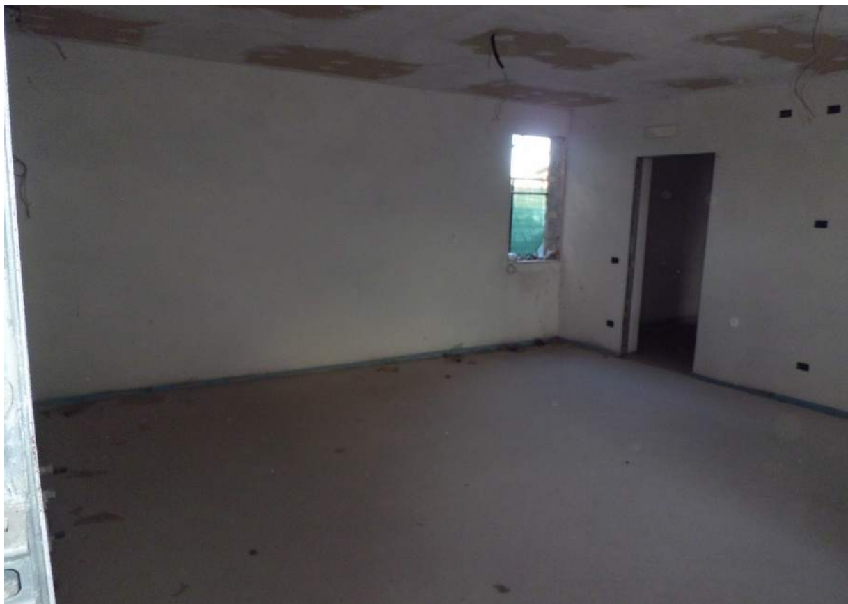
Foto n° 10 - 05/01/2017 - Comune di Concordia Sagittaria, foglio 13, part. 465, sub.5 - Stanza nei disegni di progetto identificata come cucina/soggiorno. Foto scattata dalla porta di entrata.
