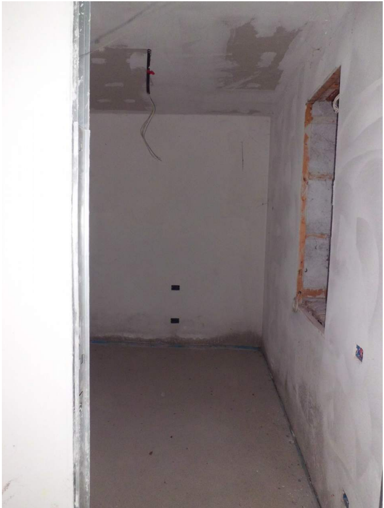
Foto n° 5 - 05/01/2017 - Comune di Concordia Sagittaria, foglio 13, part. 465, sub.4 -Stanza nei disegni di progetto identificata come ripostiglio.
