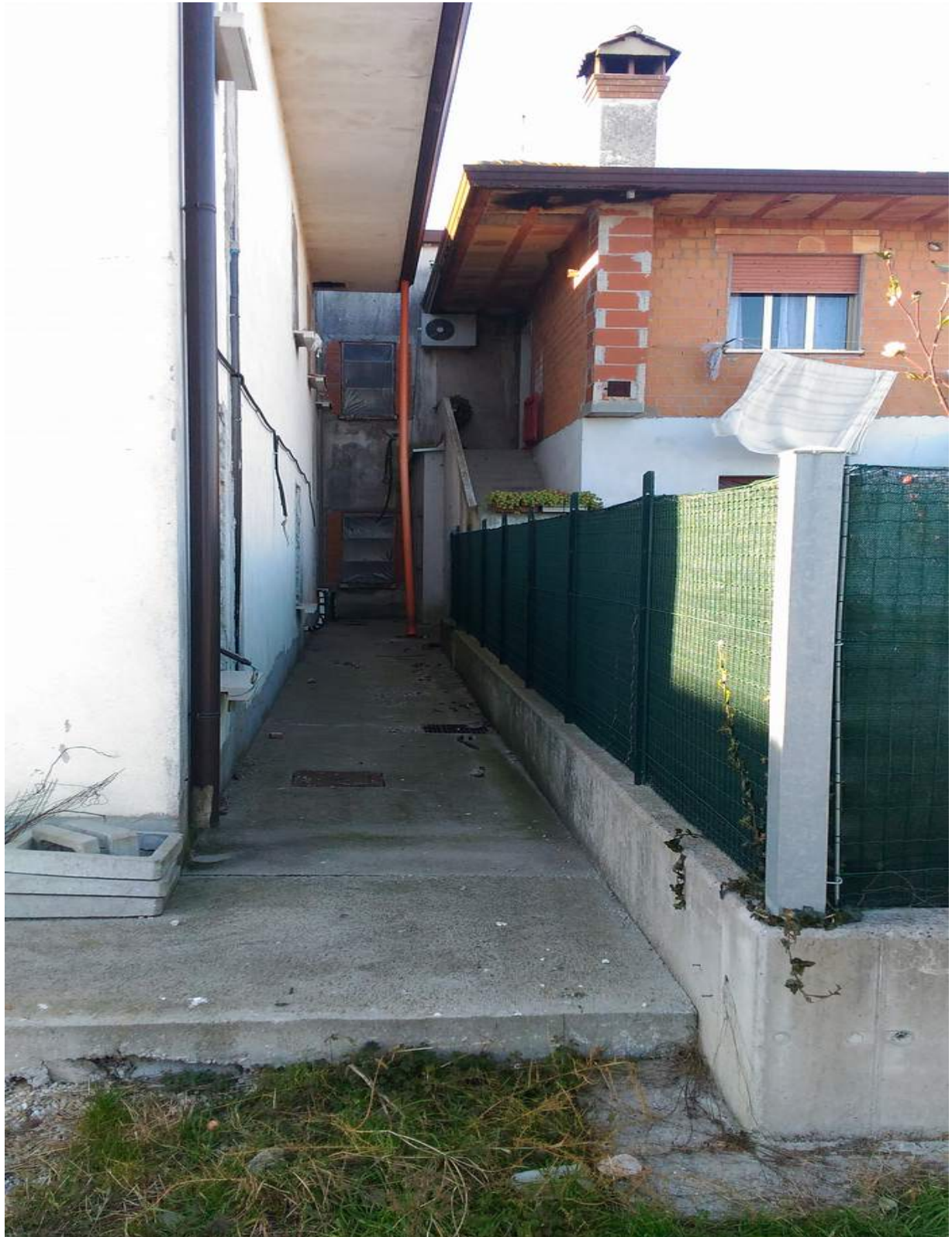
Foto n° 32 - 05/01/2017 - Comune di Concordia Sagittaria, foglio 13, part. 465, sub.8 – Particolare del cortile esterno, lato nord.Visibile il muretto di confine con la particella 464 di altrui proprietà.
