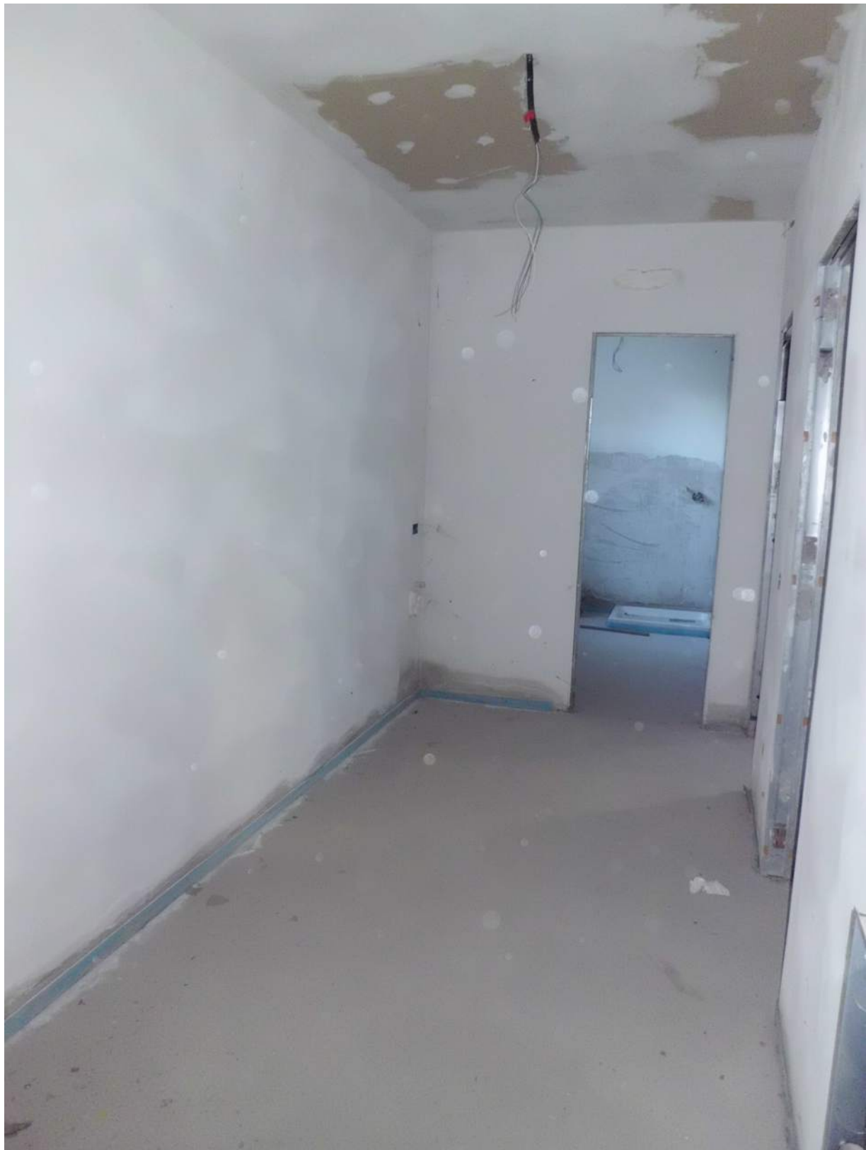
Foto n° 11 - 05/01/2017 - Comune di Concordia Sagittaria, foglio 13, part. 465, sub.5 - Disimpegno. Sullo sfondo la porta di accesso al bagno.
