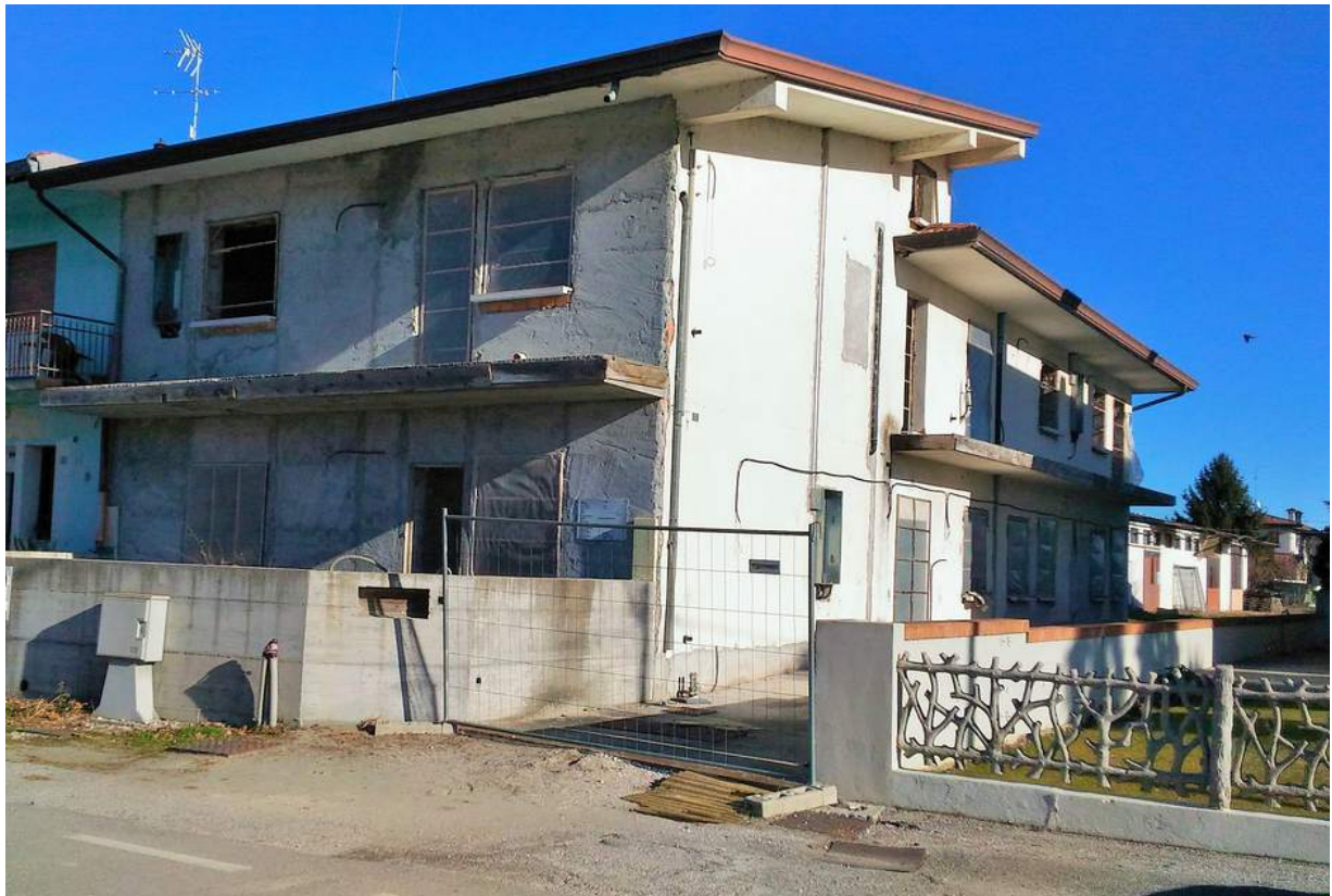
Foto n° 1 - 05/01/2017 - Comune di Concordia Sagittaria, foglio 13, part. 465 - Veduta generale del fabbricato. Foto scattata dalla strada pubblica Via Rinascimento. L'accesso al fabbricato avviene tramite il cortile visibile a destra dell'edificio.
