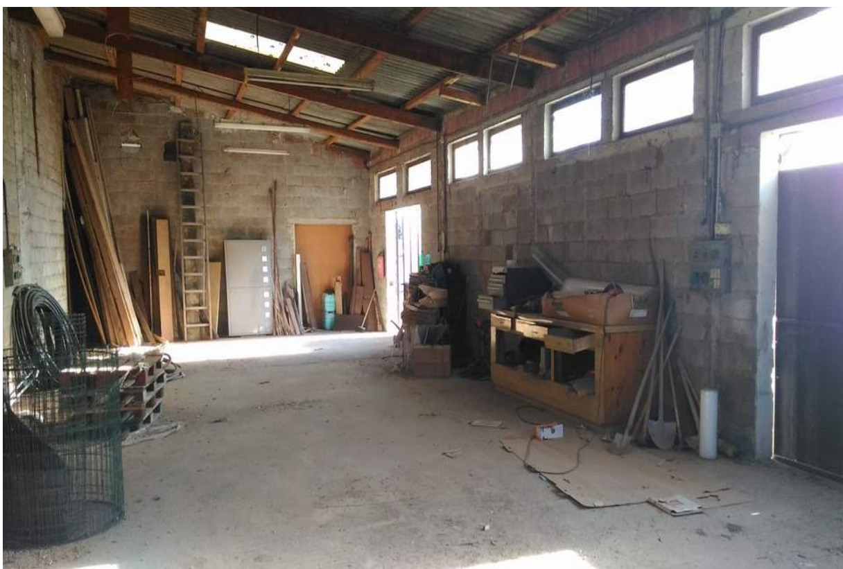
Foto n° 38 - 05/01/2017 - Comune di Concordia Sagittaria, foglio 13, part. 634 - Interno del fabbricato ex-falegnameria. Sullo sfondo visibile la porta, al momento del sopralluogo risultava non praticabile, che collega i due vani dell'edificio.
