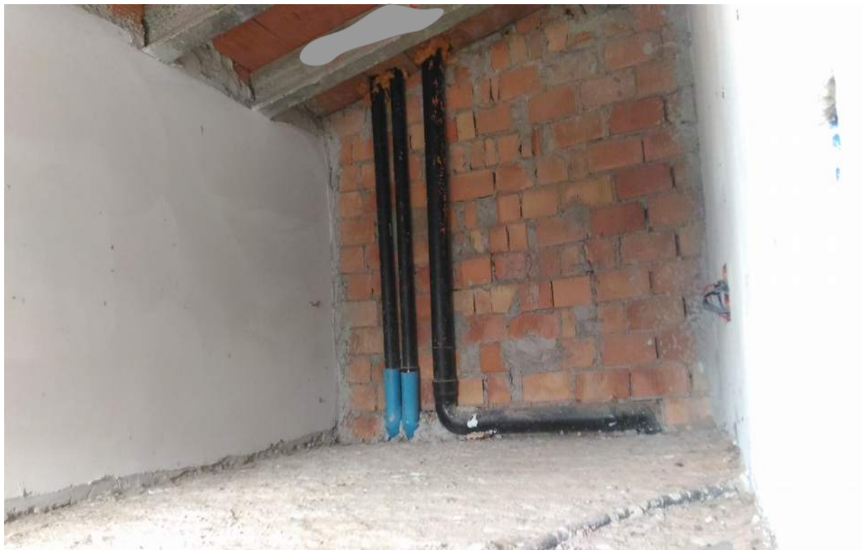
Foto n° 23 - 05/01/2017 - Comune di Concordia Sagittaria, foglio 13, part. 465, sub.7 - Soffitta.
