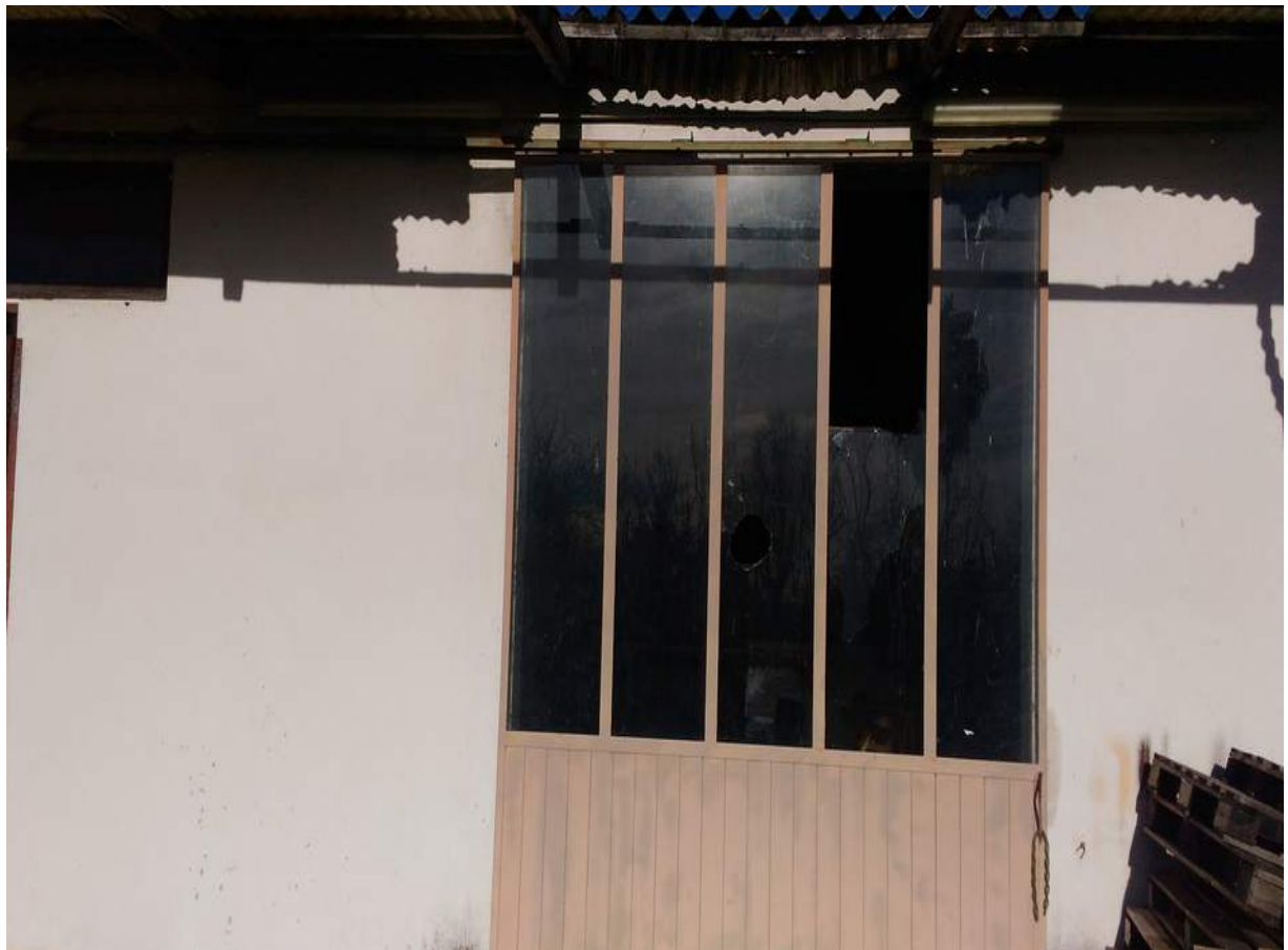
Foto n° 36 - 05/01/2017 - Comune di Concordia Sagittaria, foglio 13, part. 634 - Particolare del portone di accesso al locale ex-falegnameria. Visibili i vetri rotti.
