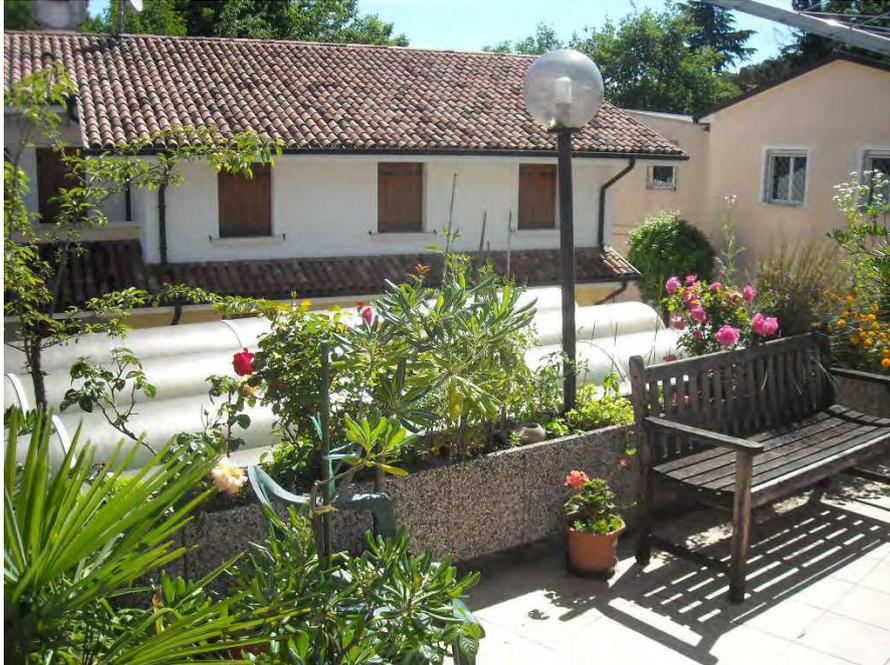
Foto 26 –particolare in cui si evidenzia la mancanza di parapetto perimetrale
