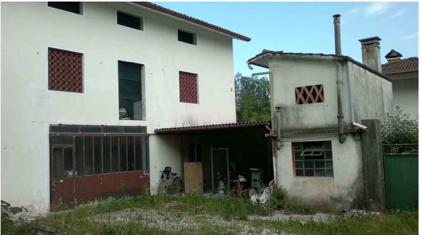
Foto 6: Prospetto Sud-Ovest del fabbricato accessorio ( Sub5 ) oggetto di esecuzione immobiliare.
