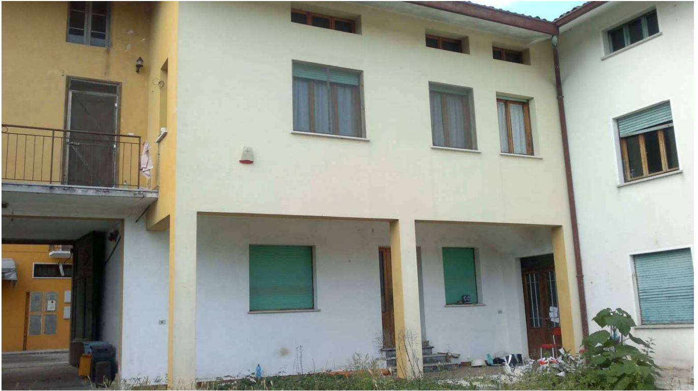
Foto 9: Prospetto Sud-Est del fabbricato d'abitazione (Sub.4) oggetto di esecuzione.
