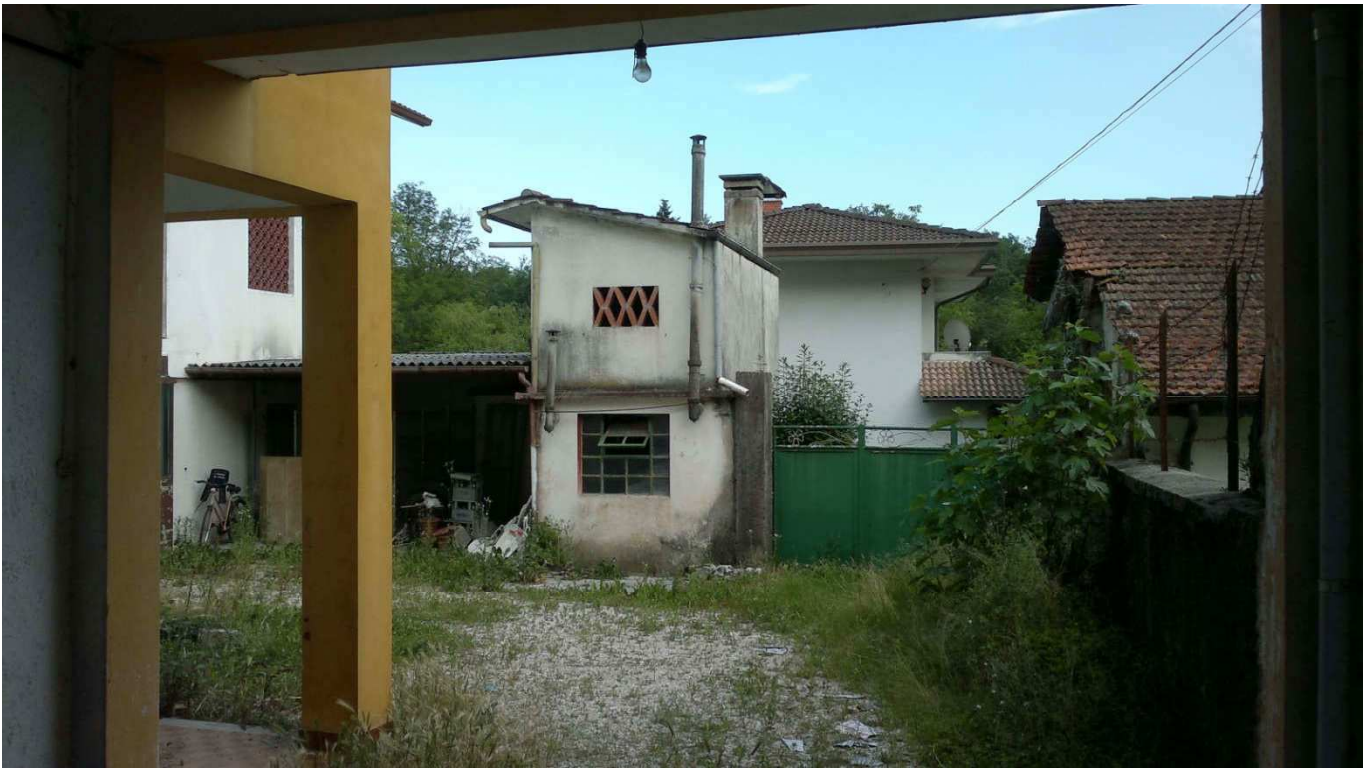
Foto 5: Scoperto pertinenziale ( Sub.3 ) e prospetto Nord-Ovest del fabbricato accessorio ( Sub.5 ) oggetto di esecuzione immobiliare.
