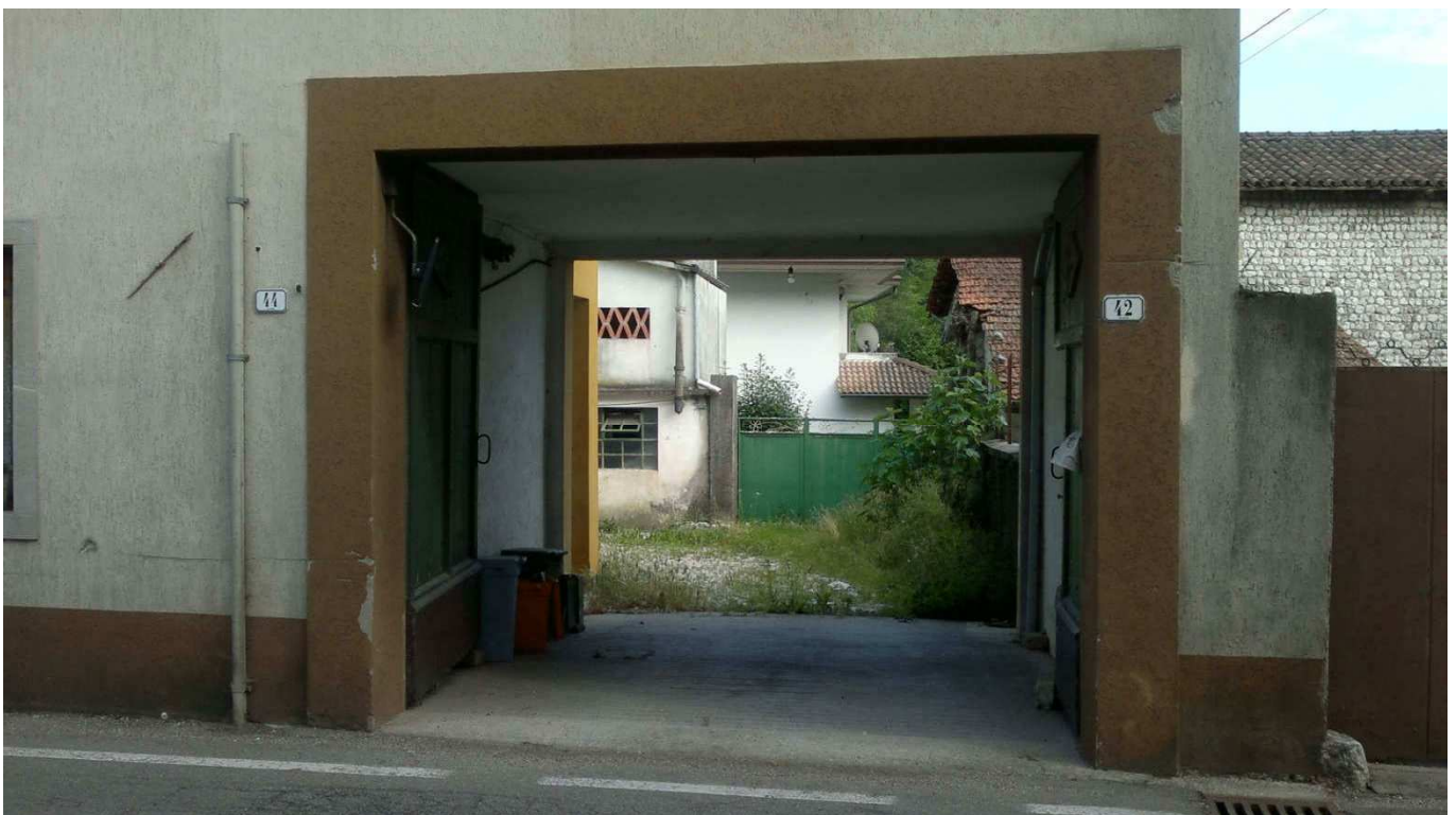
Foto 4: Androne d'ingresso posto lungo il prospetto Nord-Ovest del fabbricato (Sub.4) oggetto di esecuzione immobiliare.
