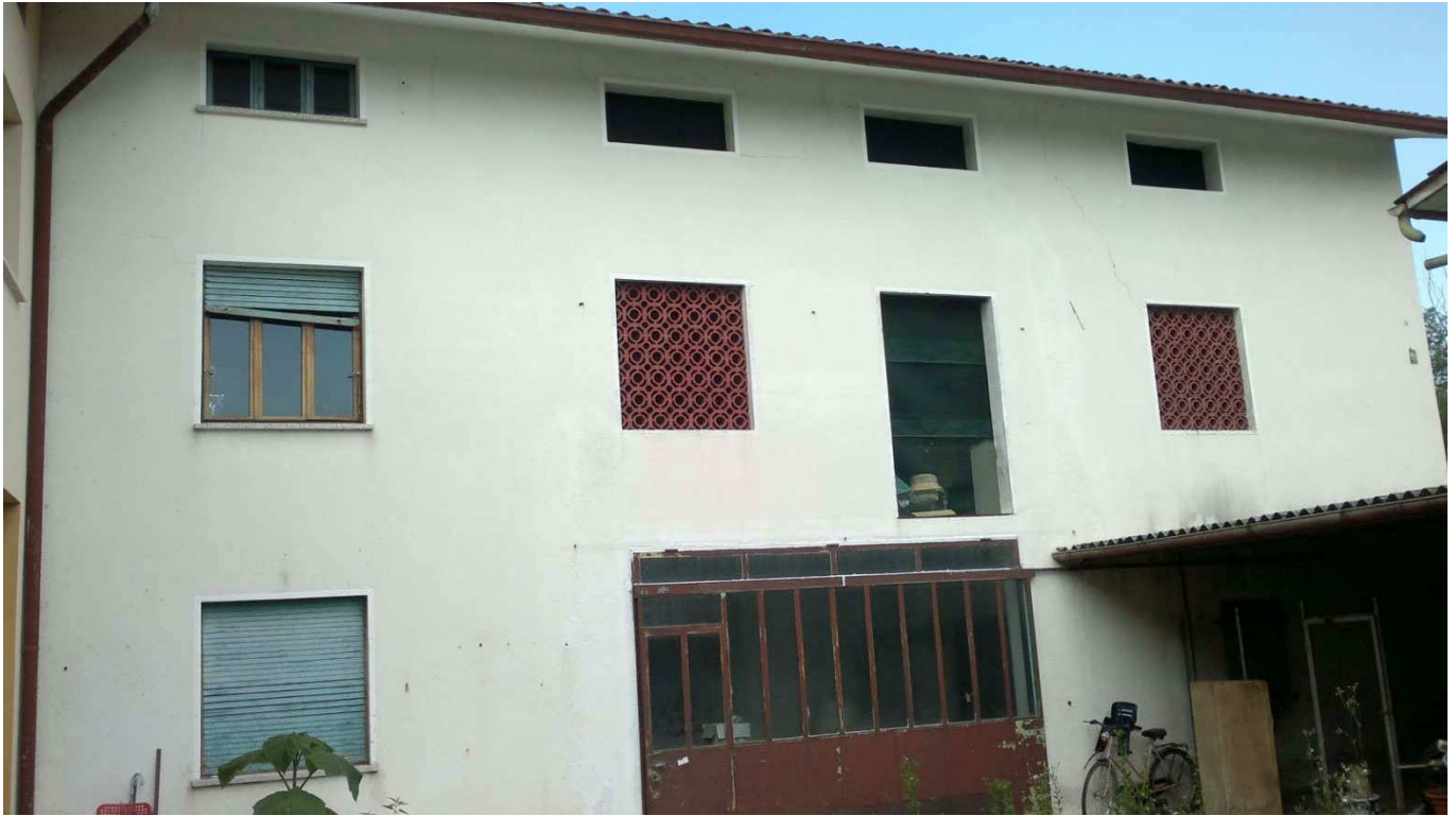
Foto 7: Prospetto Sud-Ovest del fabbricato d'abitazione ed accessorio (Sub.4-5) oggetto di esecuzione immobiliare.
