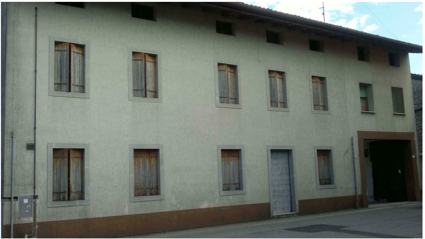
Foto 3: Prospetto Nord-Ovest del fabbricato (Sub.4) oggetto di esecuzione immobiliare.
