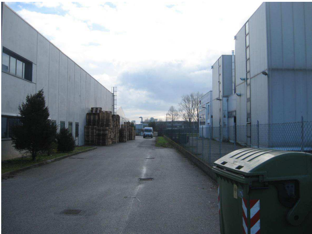
IL PIAZZALE A LATO SUD-OVEST
