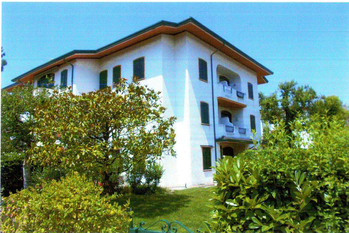
FOTO N.04 FOGLIO 38, MAPPALE 224, SUB.92 COMUNE DI CAORLE (VE) D. VERDE VIALE CHERSO N.177
