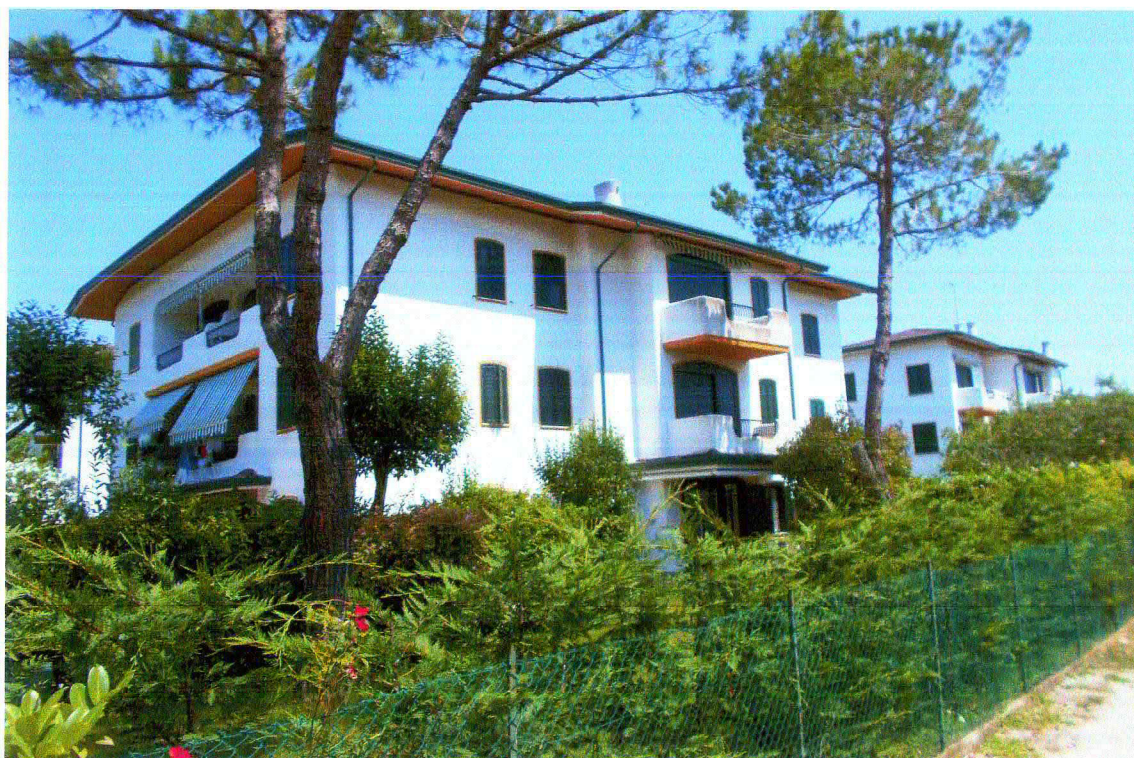
FOTO N.02 FOGLIO 38, MAPPALE 224, SUB.92 COMUNE DI CAORLE (VE) D. VERDE VIALE CHERSO N.177
