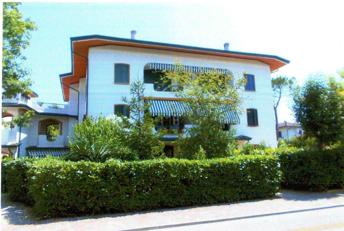
FOTO N.01 FOGLIO 38, MAPPALE 224, SUB.92 COMUNE DI CAORLE (VE) D. VERDE -VIALE CHERSO N.177
