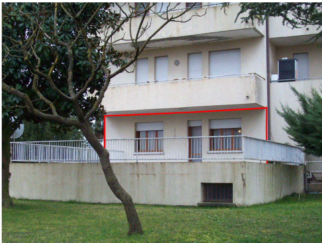
Foto 2: Prospetto Nord appartamento
