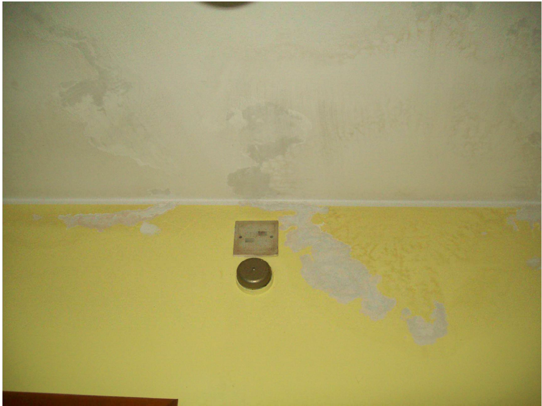
Foto 9: Soffitto più parete ingresso
