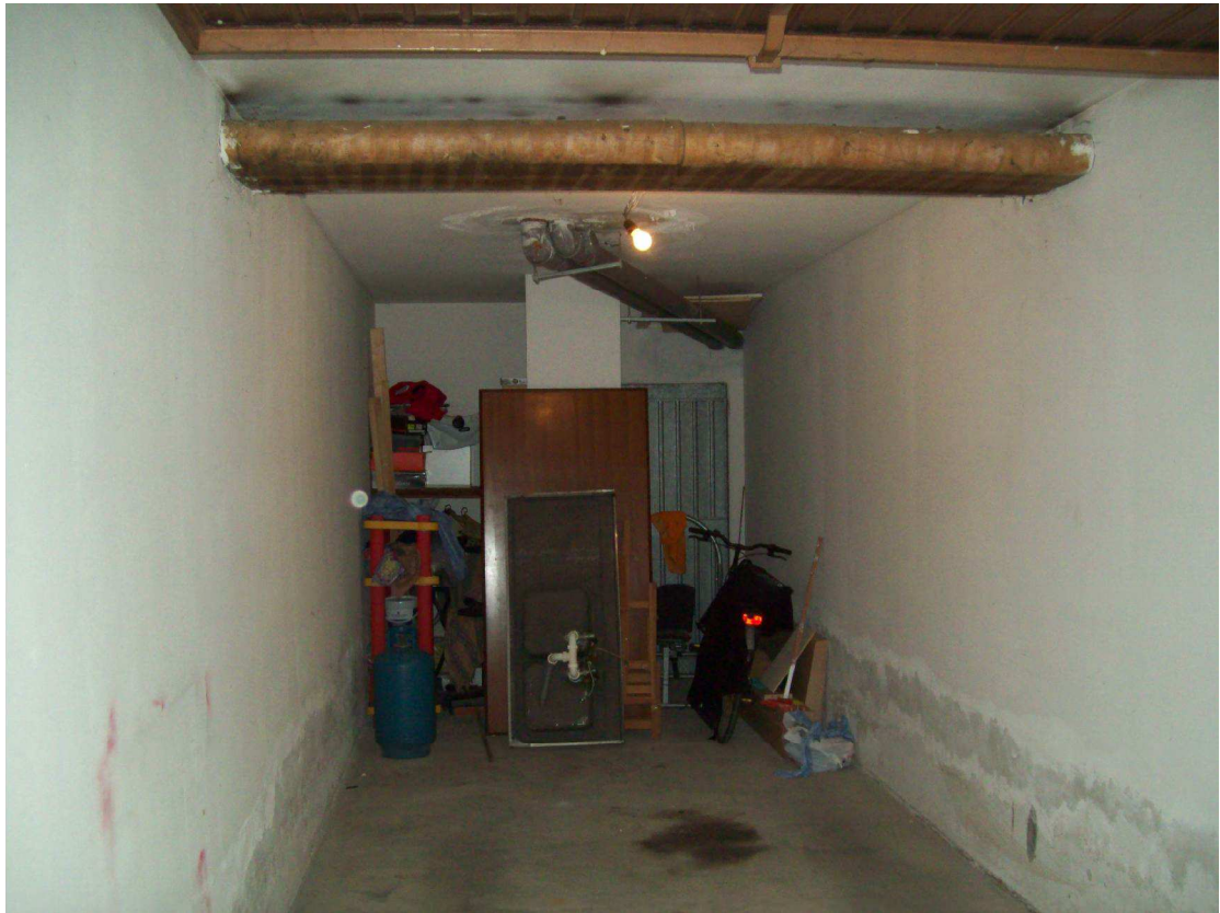
Foto 17: Interno garage sub 44
