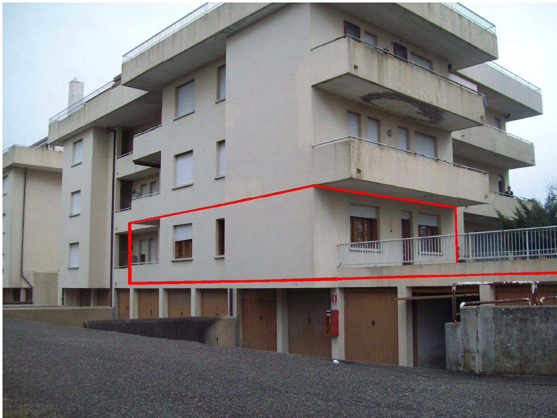
Foto 3: Vista angolo Nord-Est appartamento
