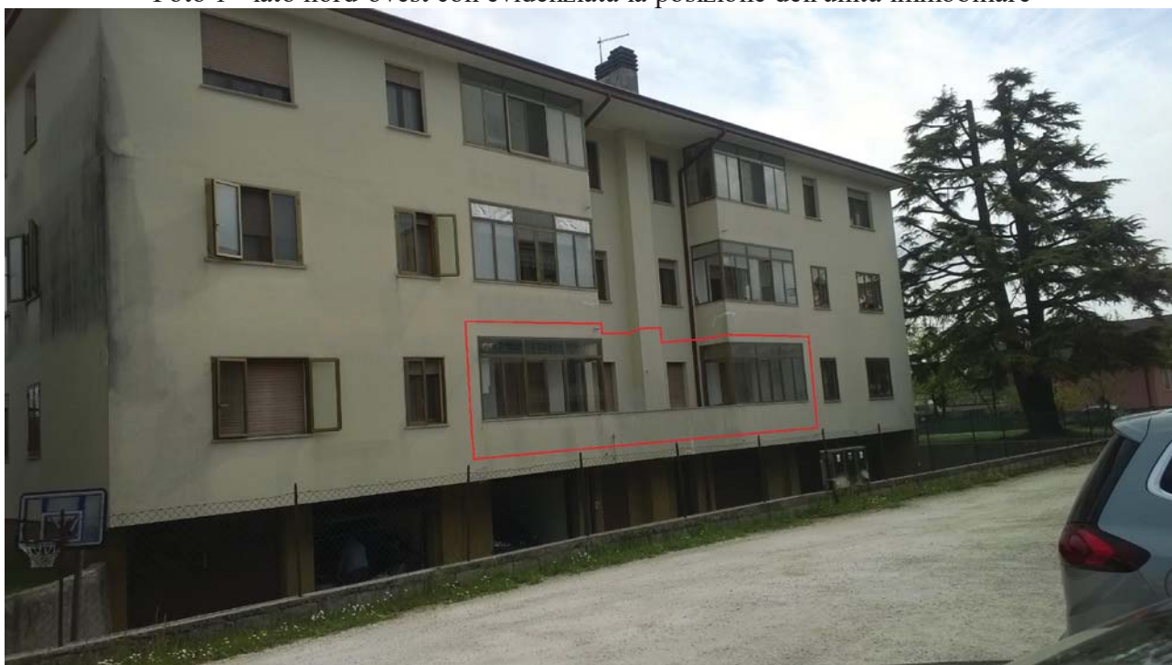
Foto 1 - lato nord-ovest con evidenziata la posizione dell'unità immobiliare
