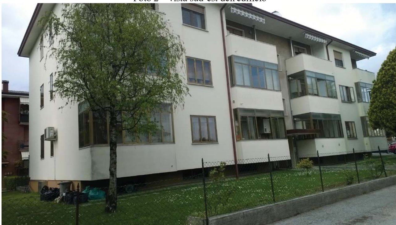
Foto 2 – vista sud-est dell'edificio
