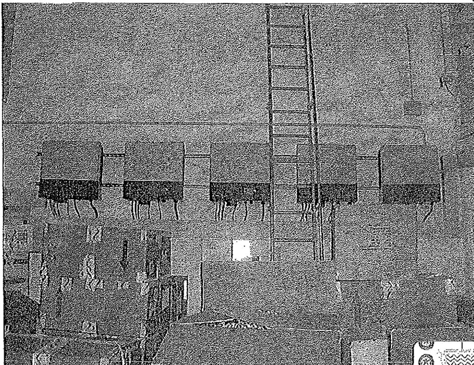
Foto n. 31: Inverter dell'impianto fotovoltaico (piano terra)
