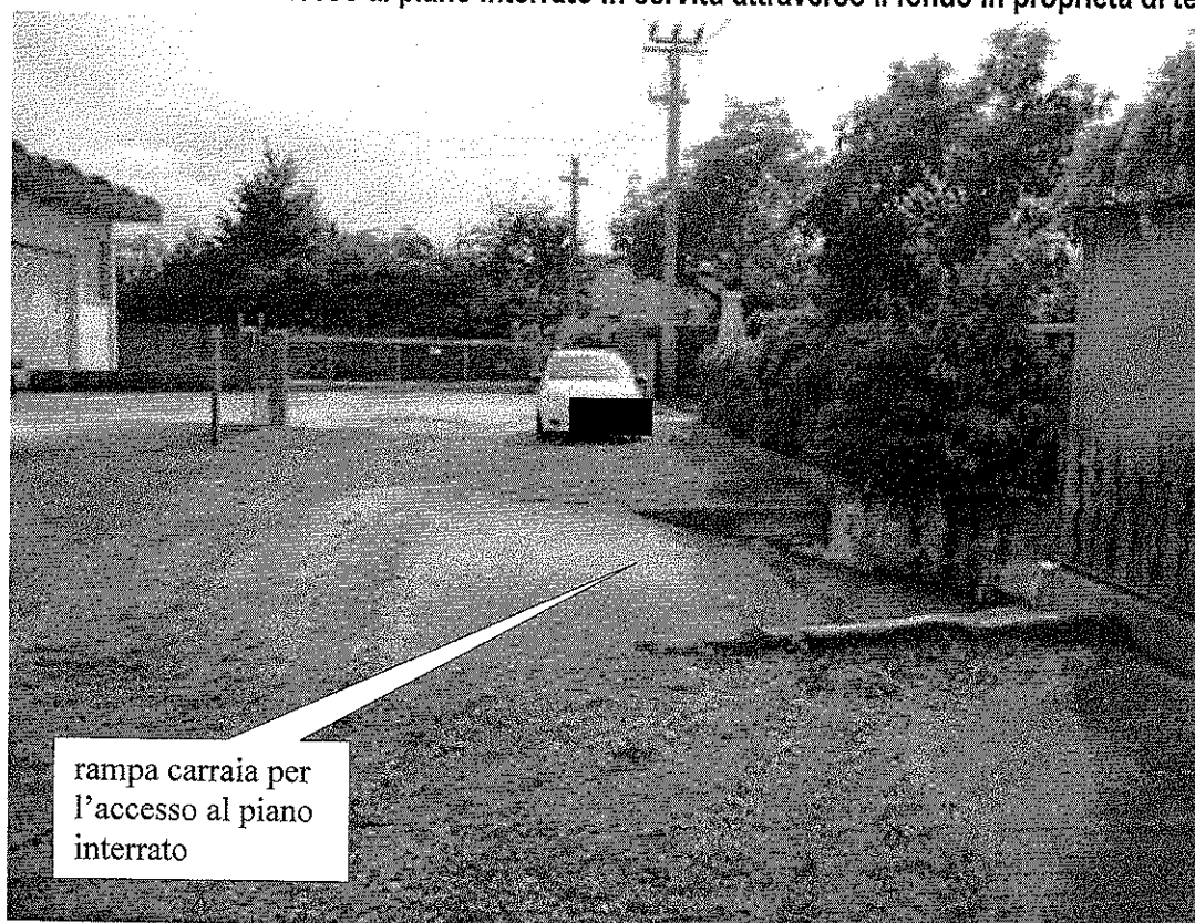
Foto 18 – vista dell'accesso al piano interrato in servitù attraverso il fondo in proprietà di terzi
