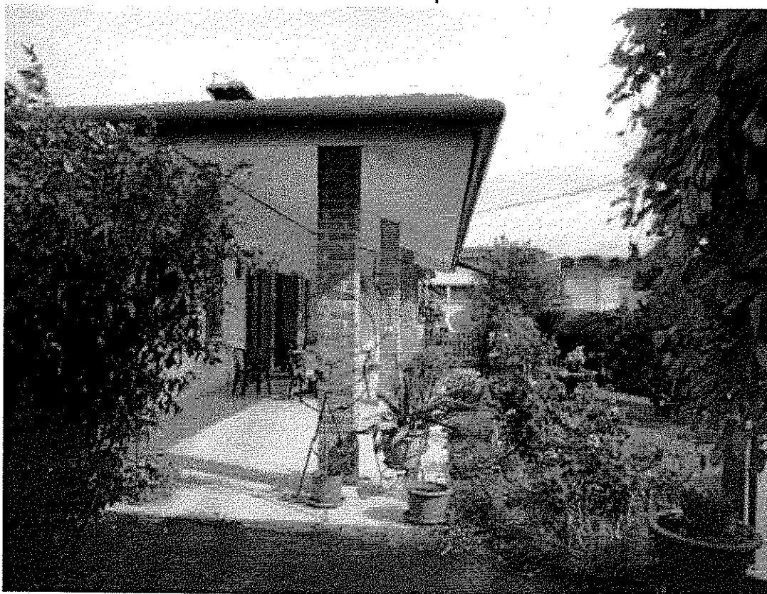
Foto 14 – vista da nord del portico lato ovest
