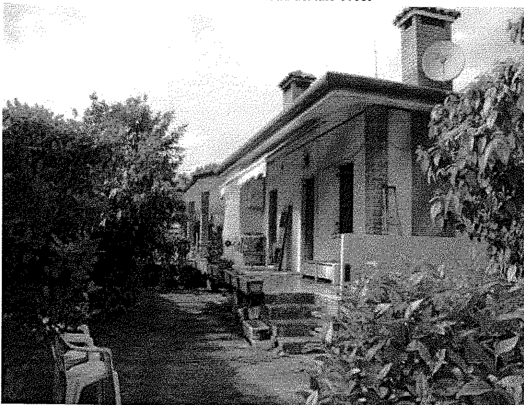
Foto 15 – vista da sud del lato ovest
