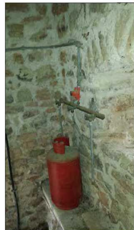
Corpo accessorio 03 - Vista interna foto 54
