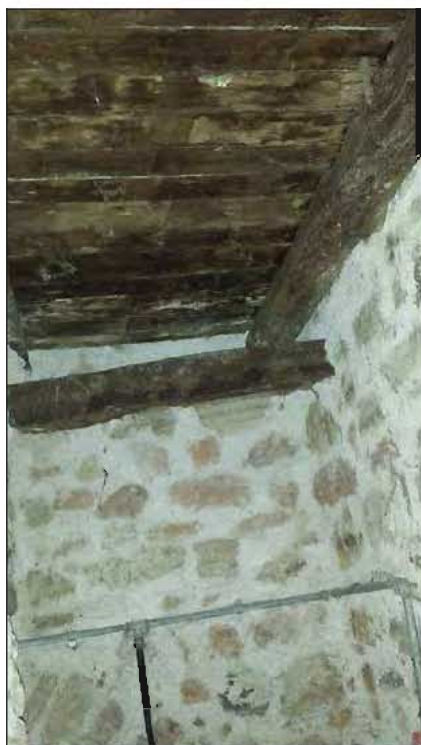
Corpo accessorio 03 - Vista interna foto 53
