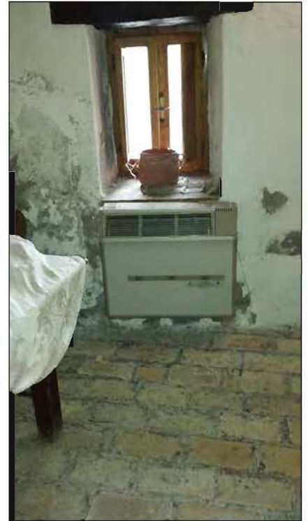
Soggiorno al piano primo
