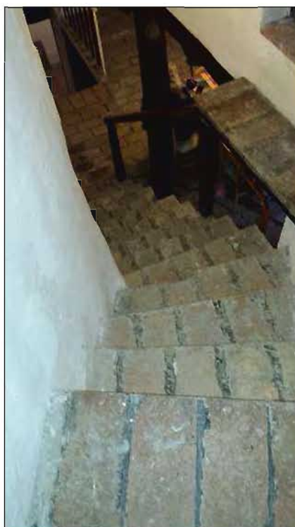
Scala tra piano primo e secondo
