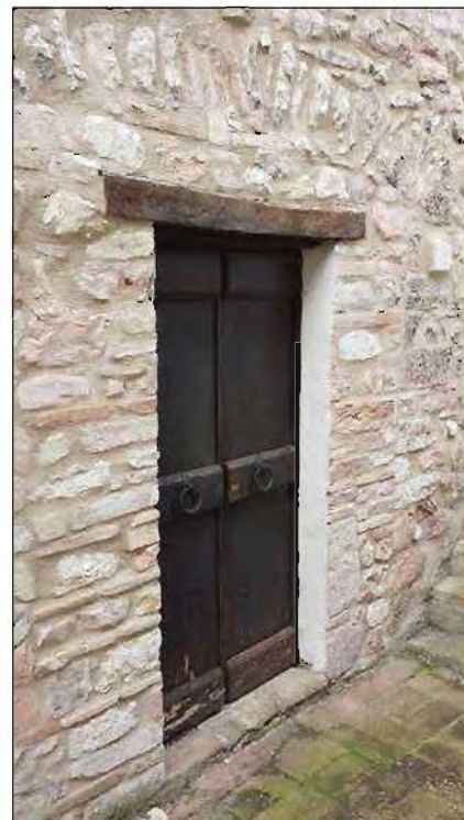
Ingresso al piano terra
