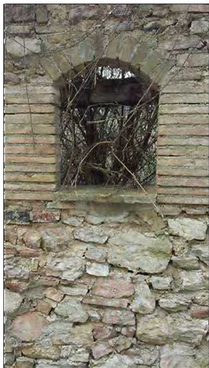
Accesso immobile p.lla 169
