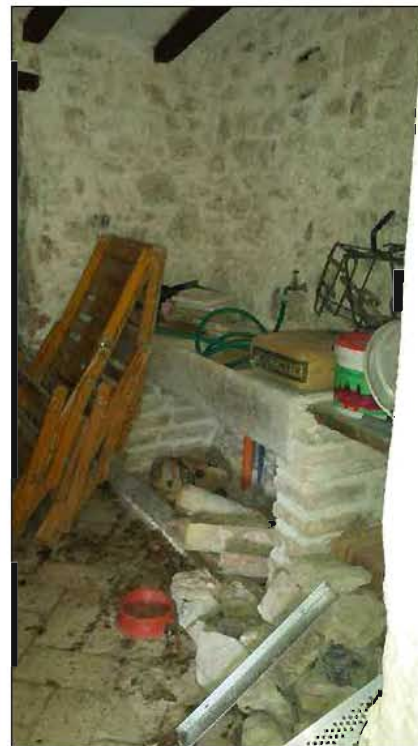
Corpo accessorio 01 - Vista interna foto 45
