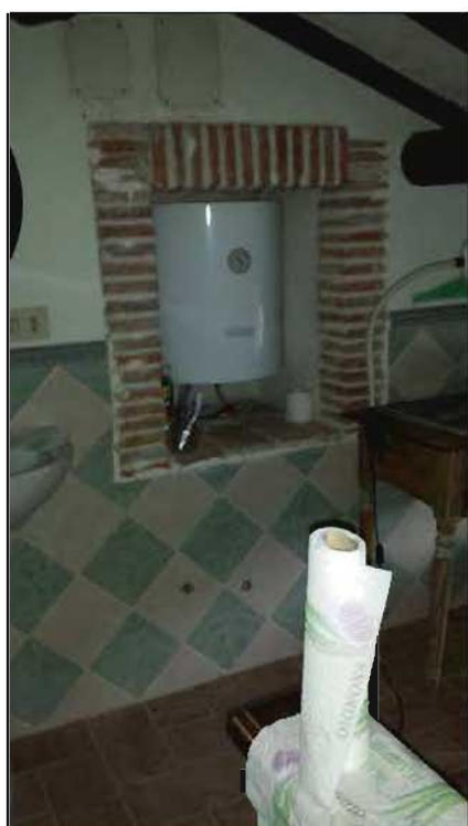
Soffitta/Bagno al piano secondo
