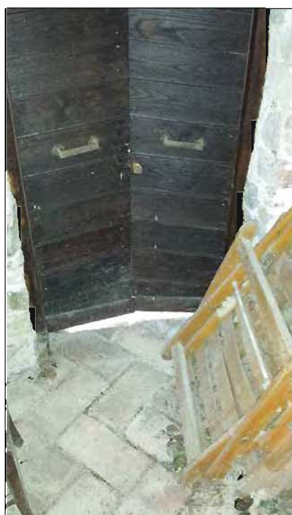
Corpo accessorio 01 - Vista interna foto 46
