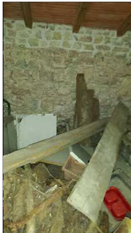
Corpo accessorio 02 - Vista interna foto 51
