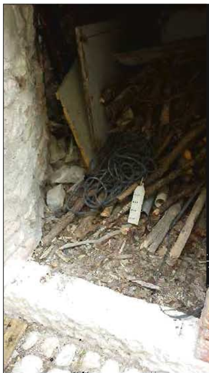
Corpo accessorio 02 - Vista interna foto 50
