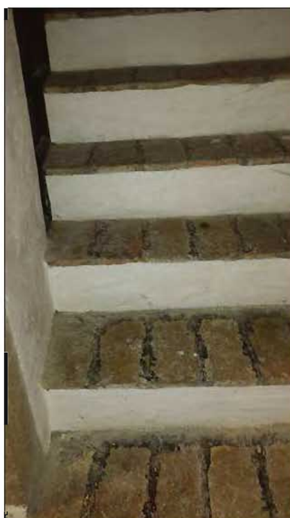
Scala tra piano terra e primo
