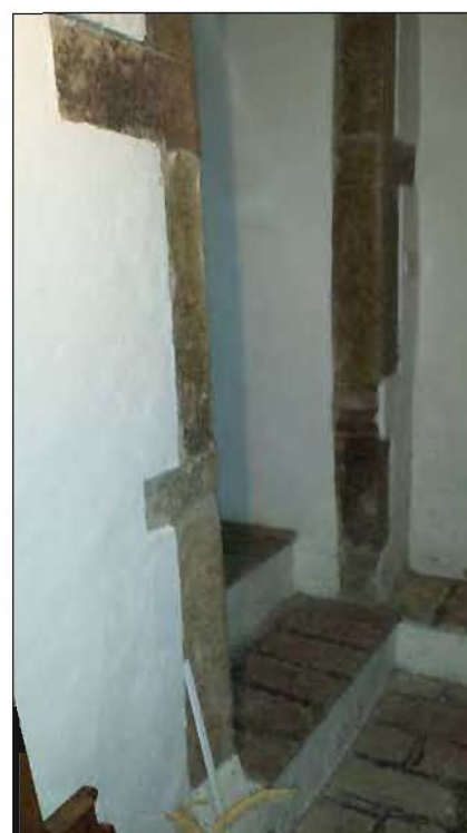
Ingresso al piano terra
