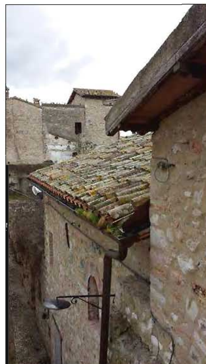
Facciata e copertura
