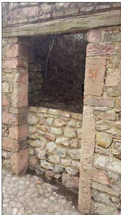
Accesso immobile p.lla 169
