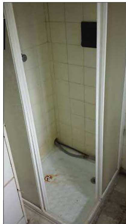
Bagno al piano primo
