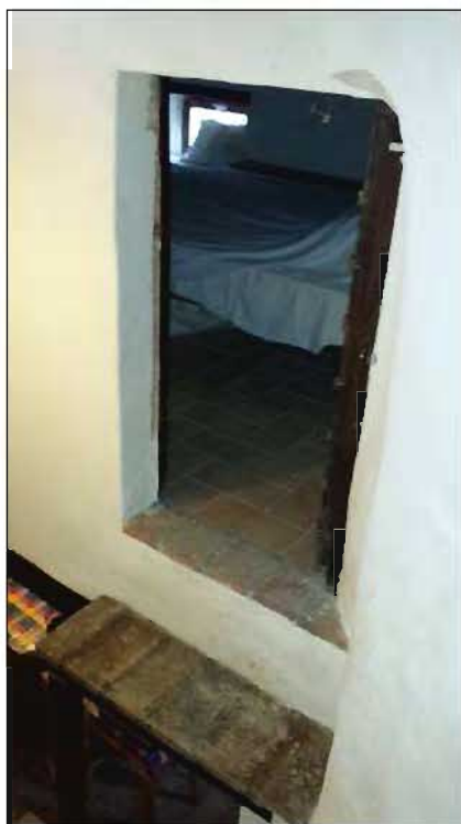
Porta di accesso alla soffitta/Letto foto 25
