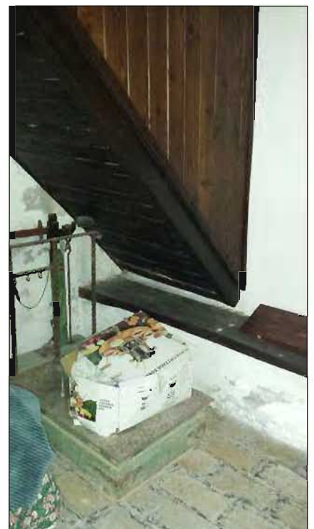
Soggiorno al piano primo
