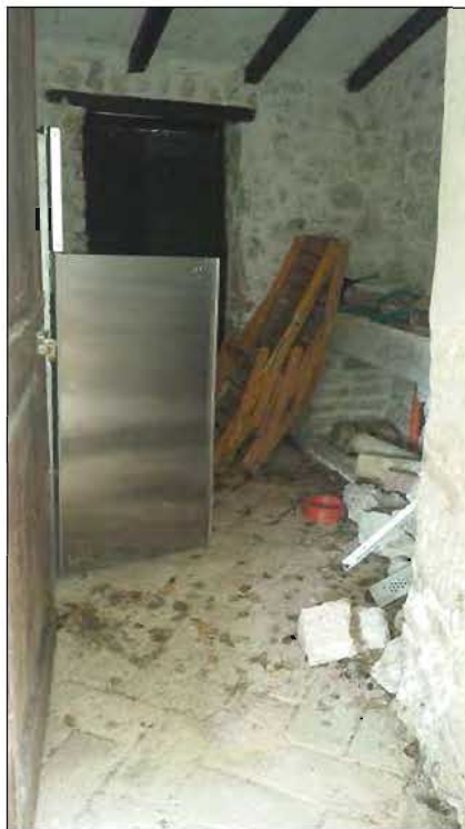
Corpo accessorio 01 - Vista interna foto 44
