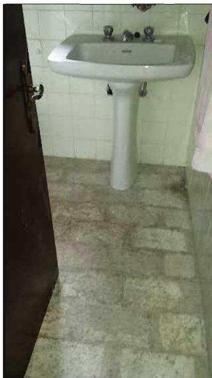
Bagno al piano primo
