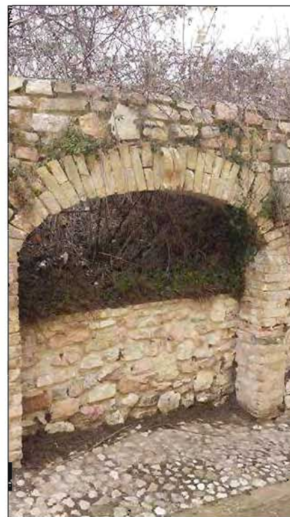
Accesso immobile p.lla 169
