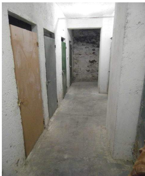
Foto n. 30: corridoio cantine al piano seminterrato
