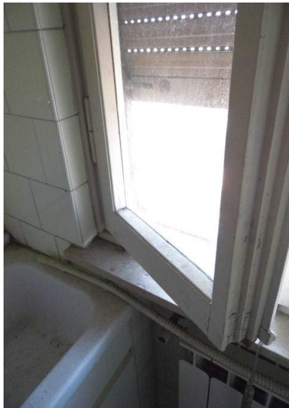
Foto 13: cucina particolare infisso
