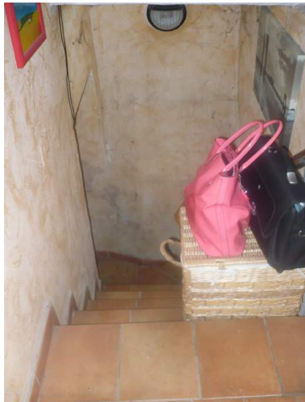
Foto n. 06: particolare – scale interne
