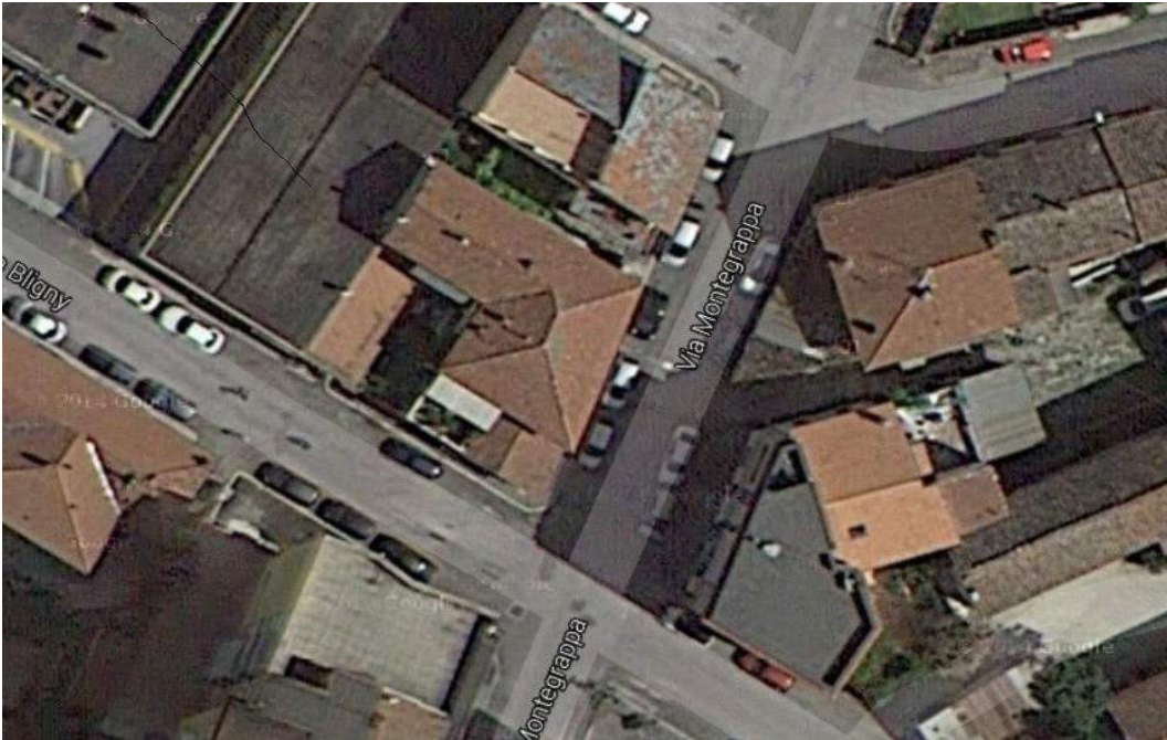
Foto n. 01: VISTA AEREA FABBRICATO – Via Bligny, n.18
