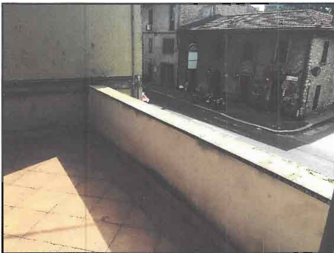
Figura 9: particolare del terrazzo di proprietà
