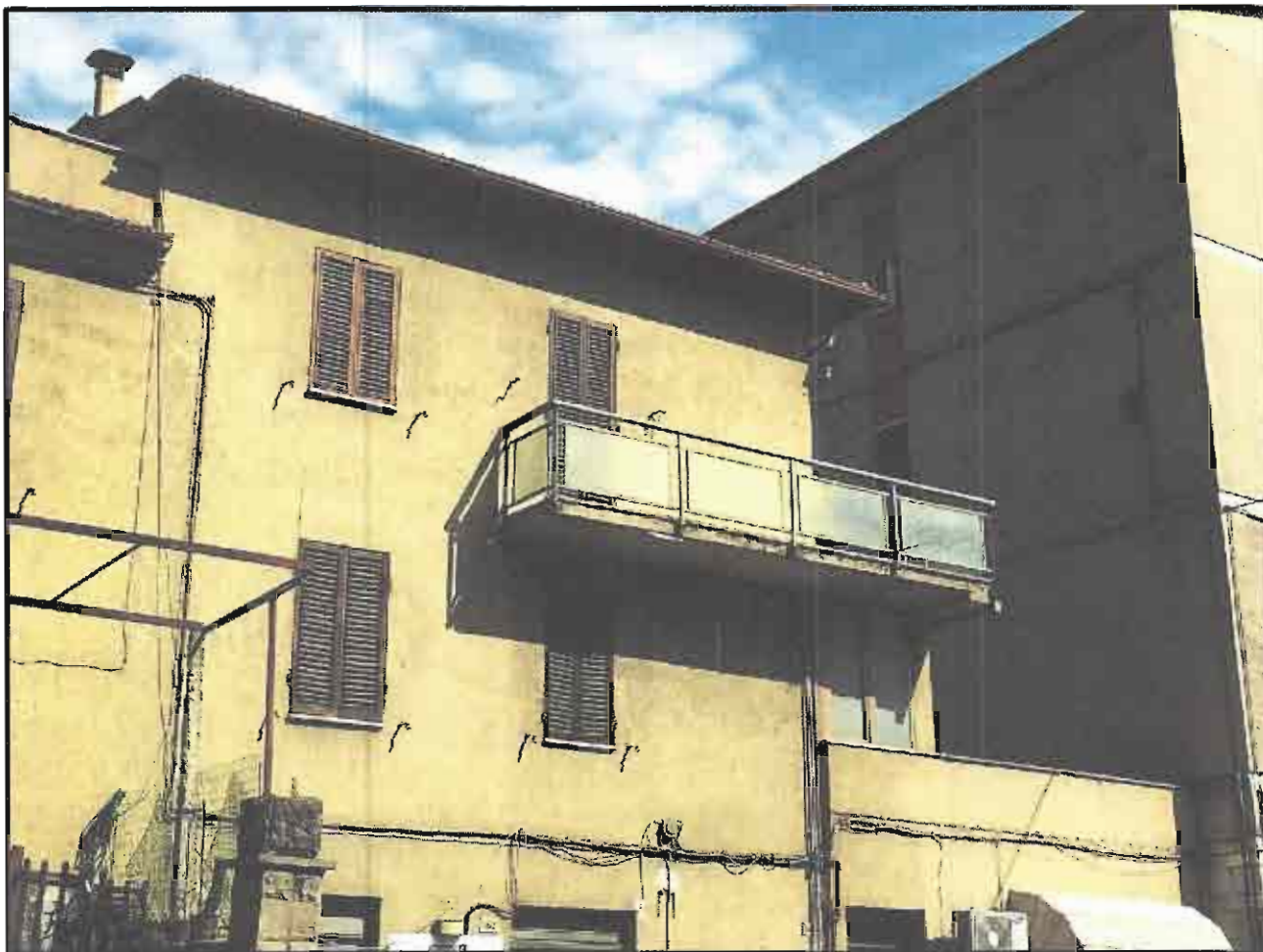
Figura 2 : Particolare dell'ingresso all'appartamento al piano Primo del fabbricato lato Nord.
