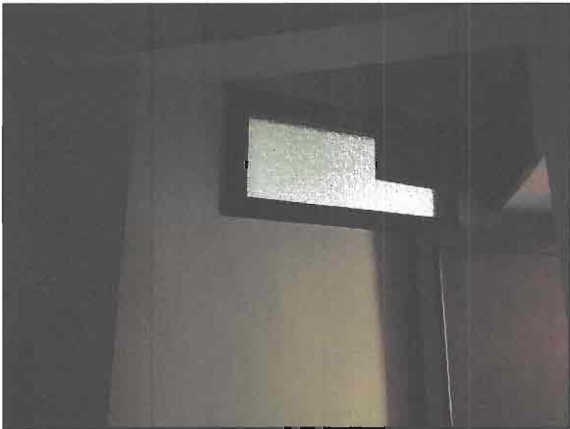
Figura 26: finestra posta sull'antibagno.
