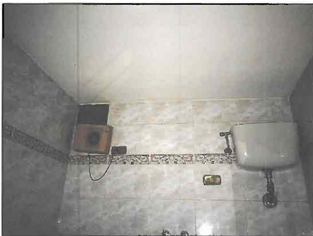
Figura 24: particolare del bagno.
