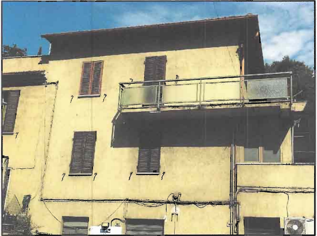
Figura 1 : Particolare dell'ingresso all'appartamento al piano Primo del fabbricato lato Nord.
