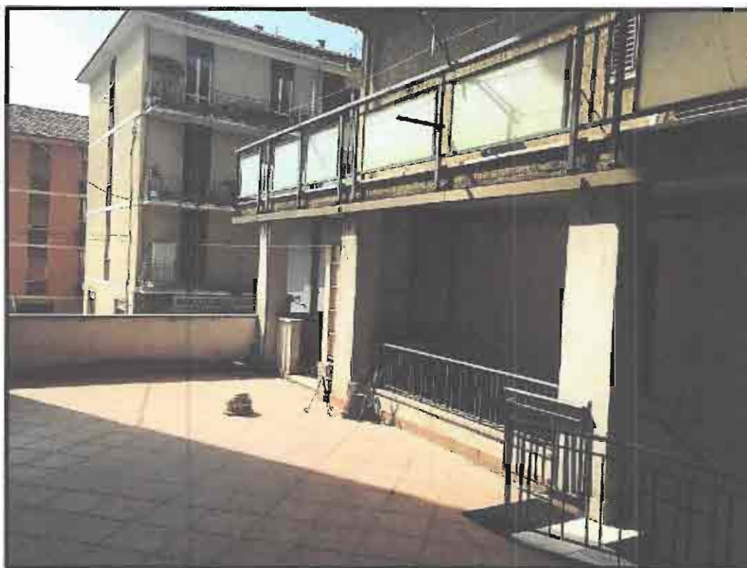
Figura 3 : Particolare Del Terrazzo di proprietà.
