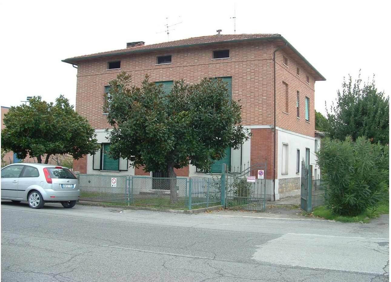
Vista prospetto principale su strada Regionale n. 71 Umbro-Casentinese
