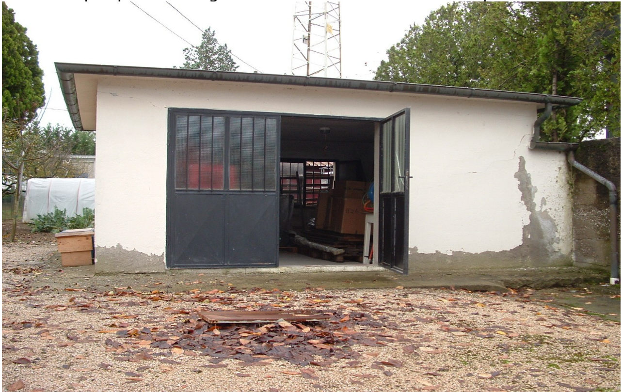
Particolare prospetto lato ingresso autorimessa su area di corte part. n. 812
