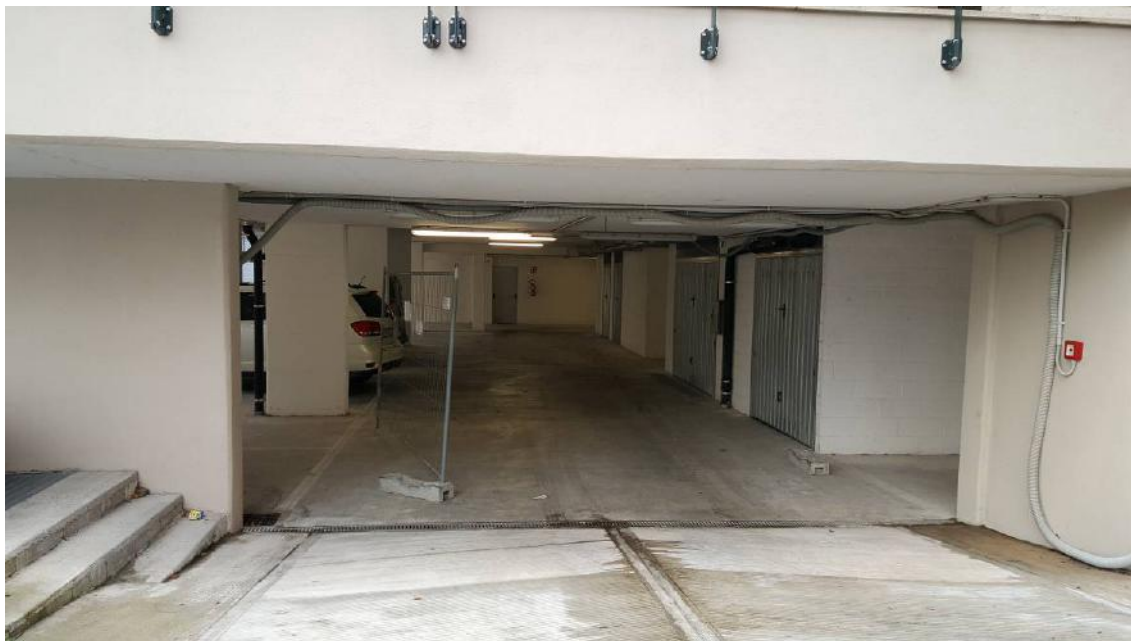
Rampa di ingresso autorimessa da via Cesare Bazzani
