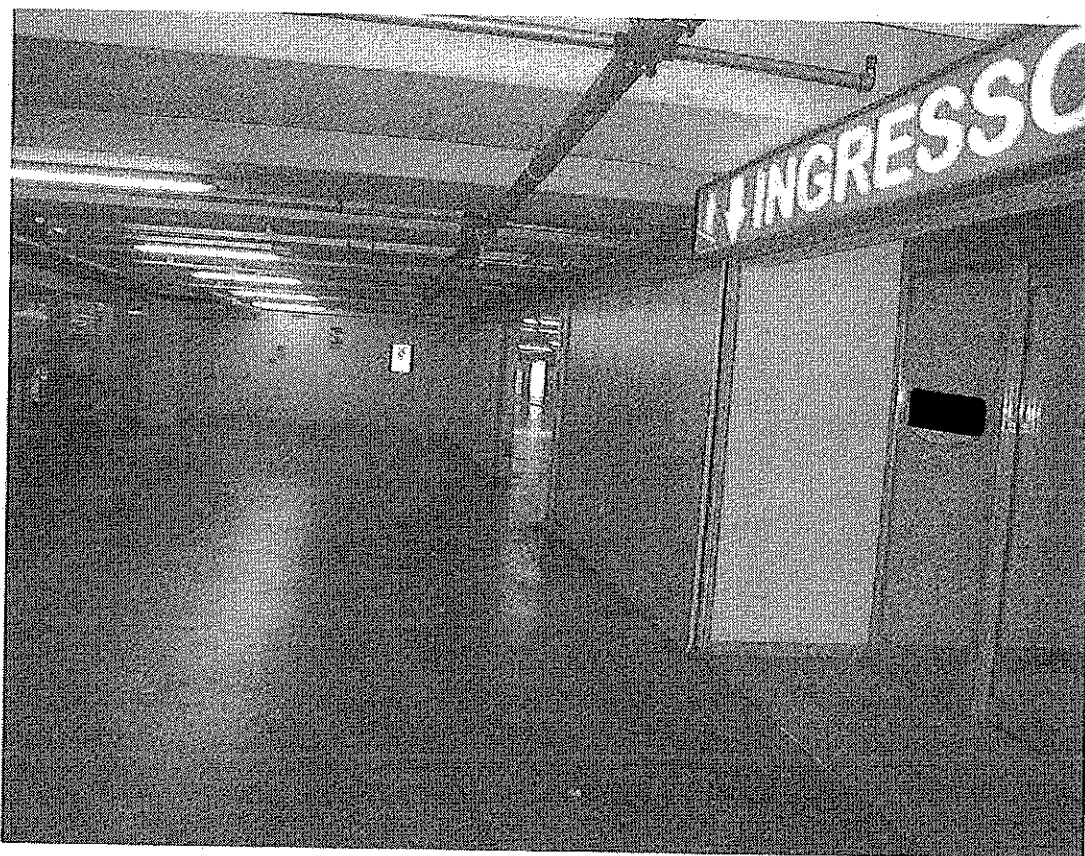
Foto n° 3 : Stato di fatto della porzione di interrato corrispondente al mappale 677 sub 2.
