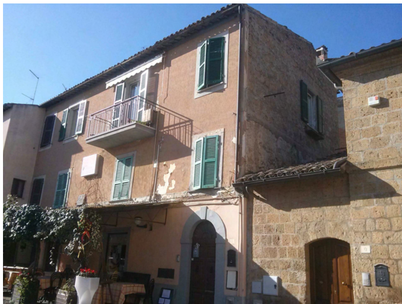
Lato sud ovest
