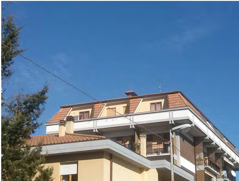
Lato sud ovest
