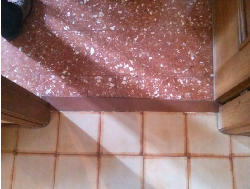
Particolare pavimento disimpegno-soggiorno
