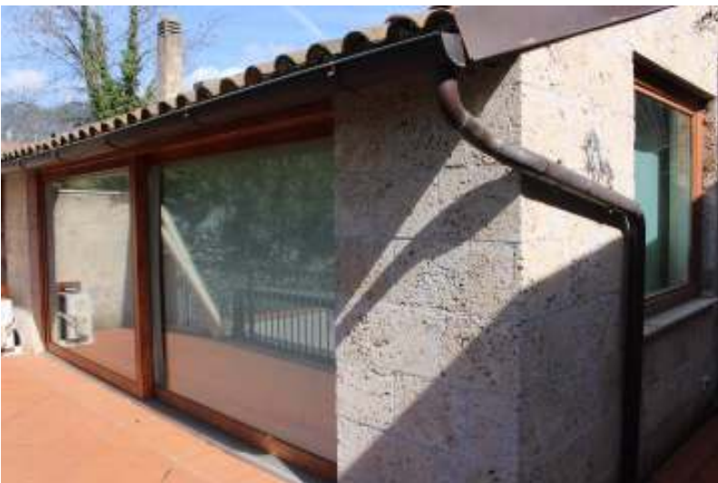
Foto 03_ prospetto lato sud-ovest
