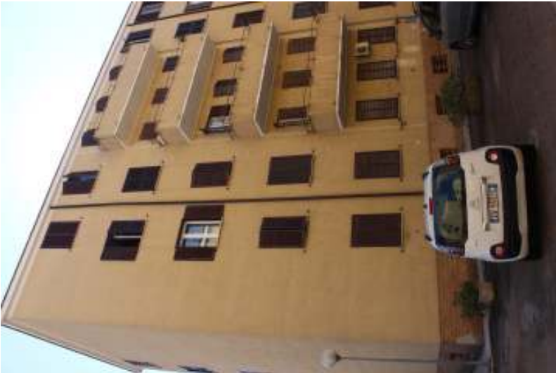
Foto 04_ prospetto lato ovest
