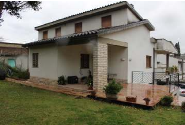
Foto 05_ prospetto lato est
