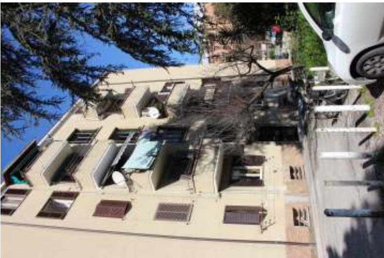
Foto 02_ prospetto lato est
