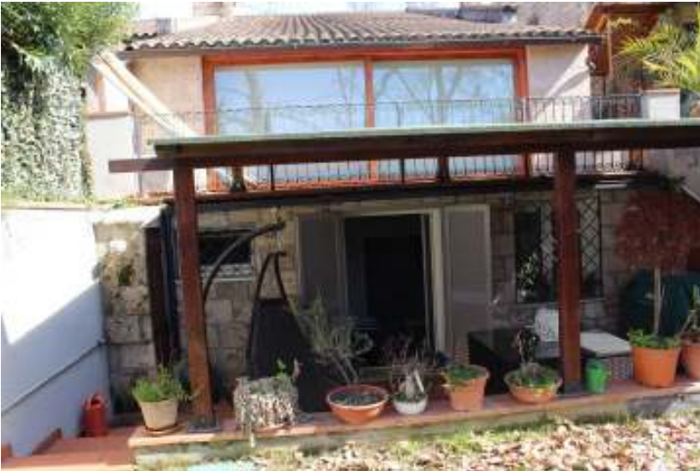
Foto 04_ prospetto lato sud-ovest
