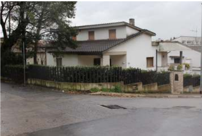
Foto 02_ prospetto lato nord-est
