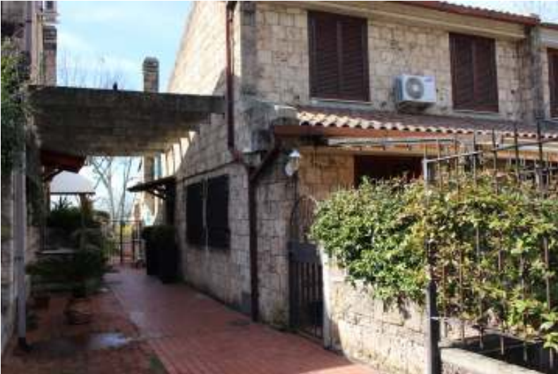
Foto 01_ prospetto lato nord-est
