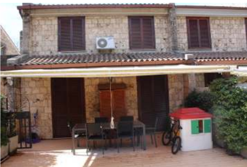
Foto 06_ prospetto lato nord-est
