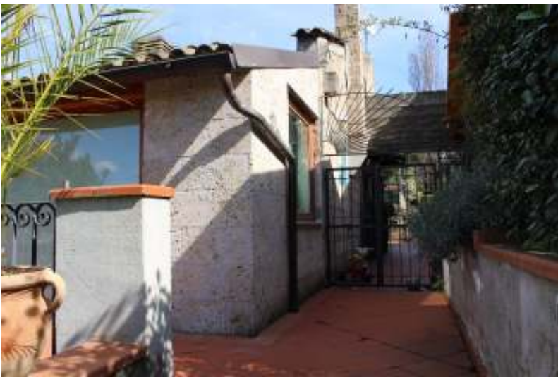
Foto 02_ prospetto lato sud-est
