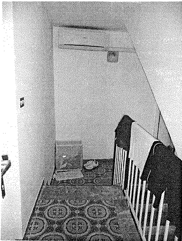
piano primo - pianerottolo
