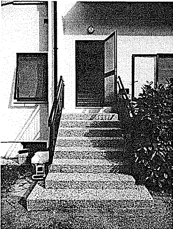
piano terra - scala di accesso al primo piano
