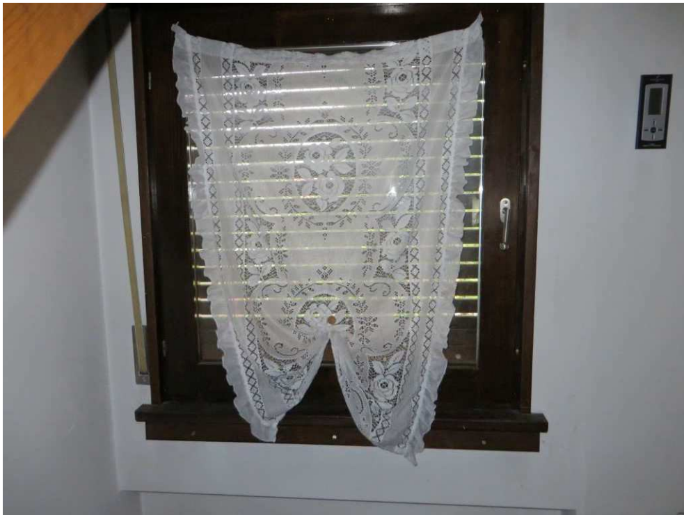
FOTO 18: SERRAMENTO DELLA CAMERA (SUB. 16 AL 2° P.)
