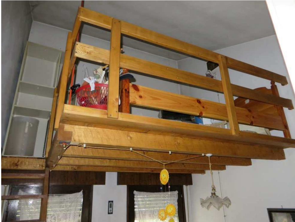
FOTO 15: SOPPALCO SOPRA LA CAMERA (SUB. 16 AL 2° P.)
