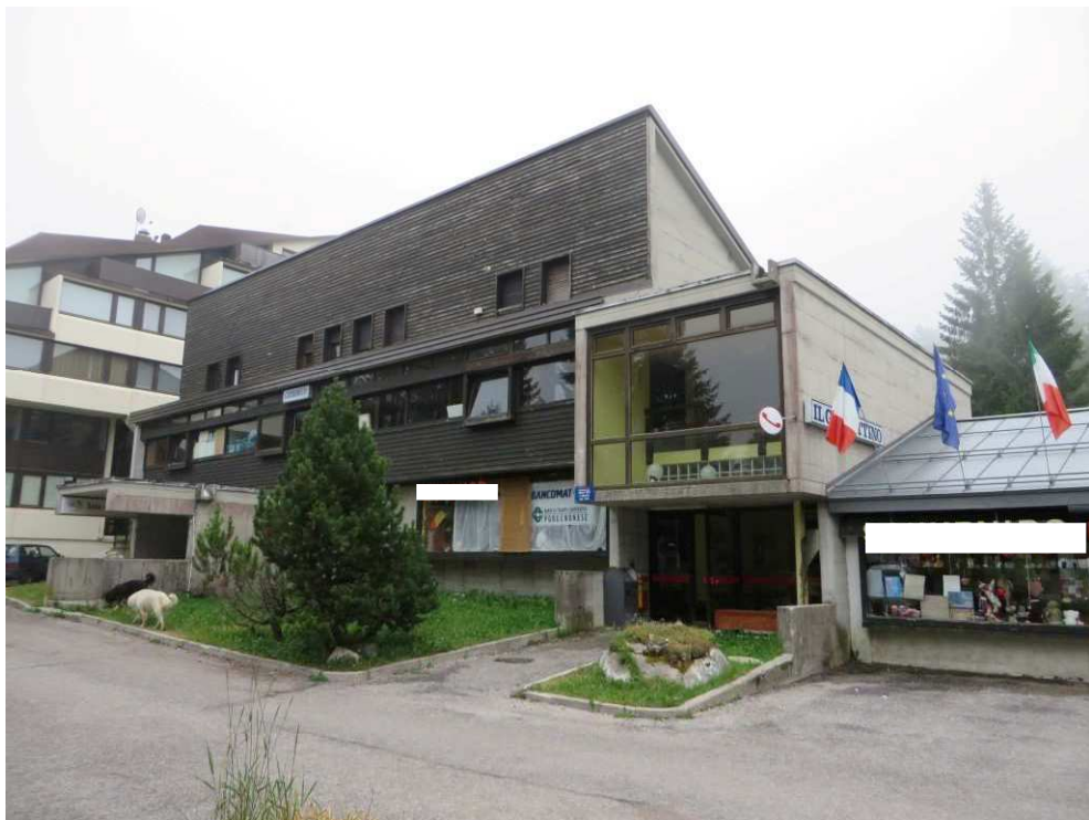
FOTO 2: ULTERIORE PANORAMICA DEL CONDOMINIO
