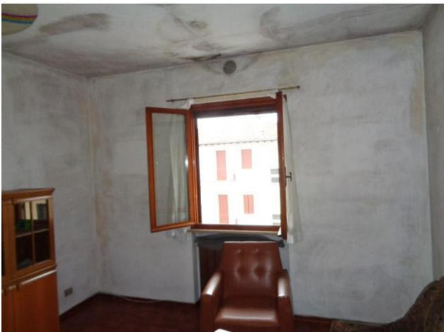
particolare degrado della muratura e soffitto con muffa nel pranzo-soggiorno
