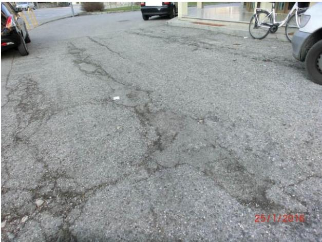
particolare degrado asfaltatura nel piazzale e parcheggio fronte fabbricato
