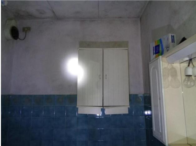
particolare degrado della muratura e soffitto con muffa nel wc
