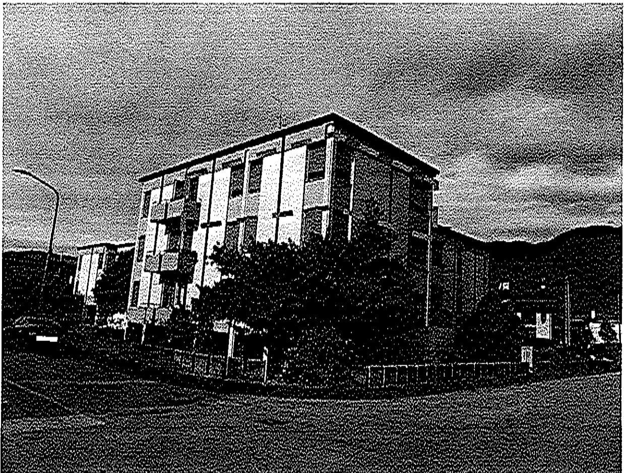
Foto 2 - facciata su fronte strada
