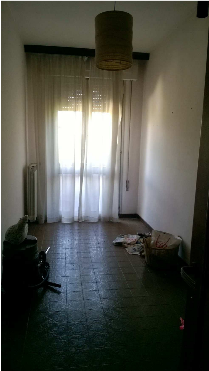
corridoio piano primo
