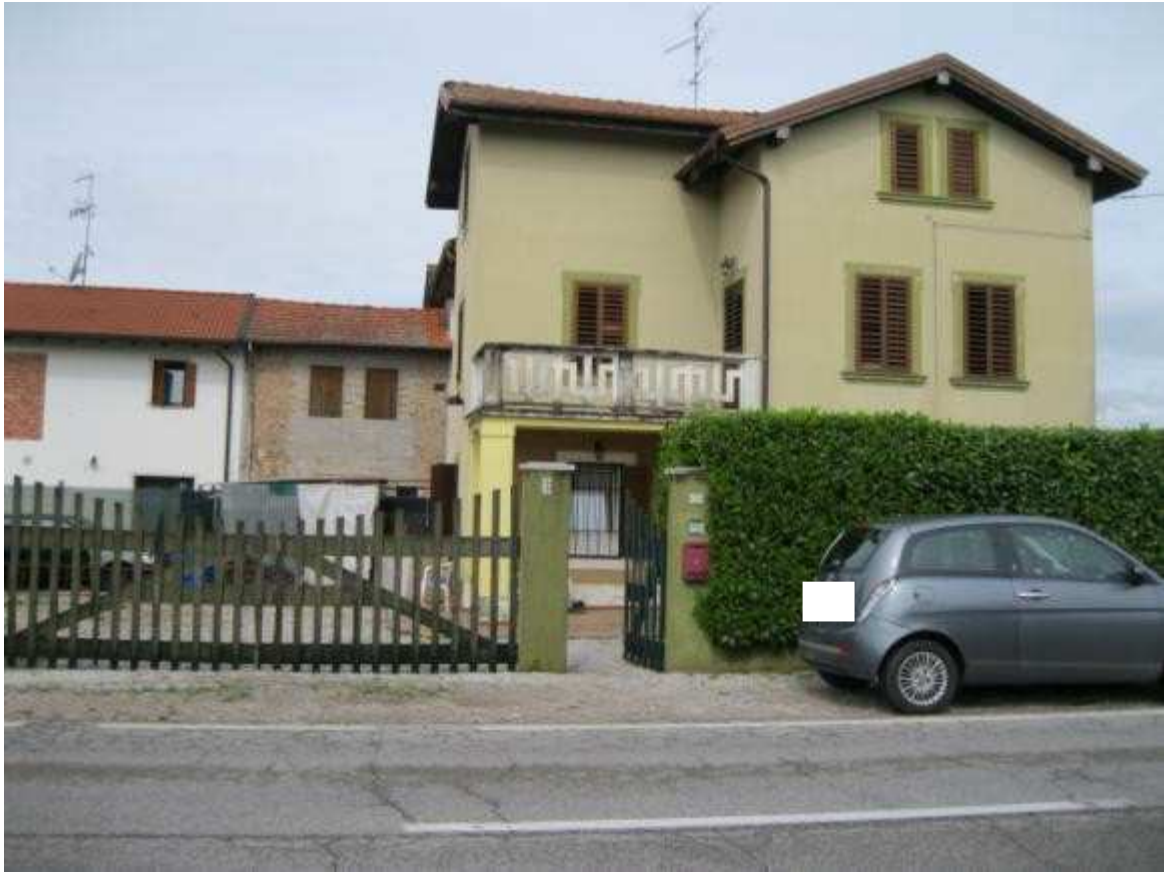
Foto 1 Vista esterna frontale
