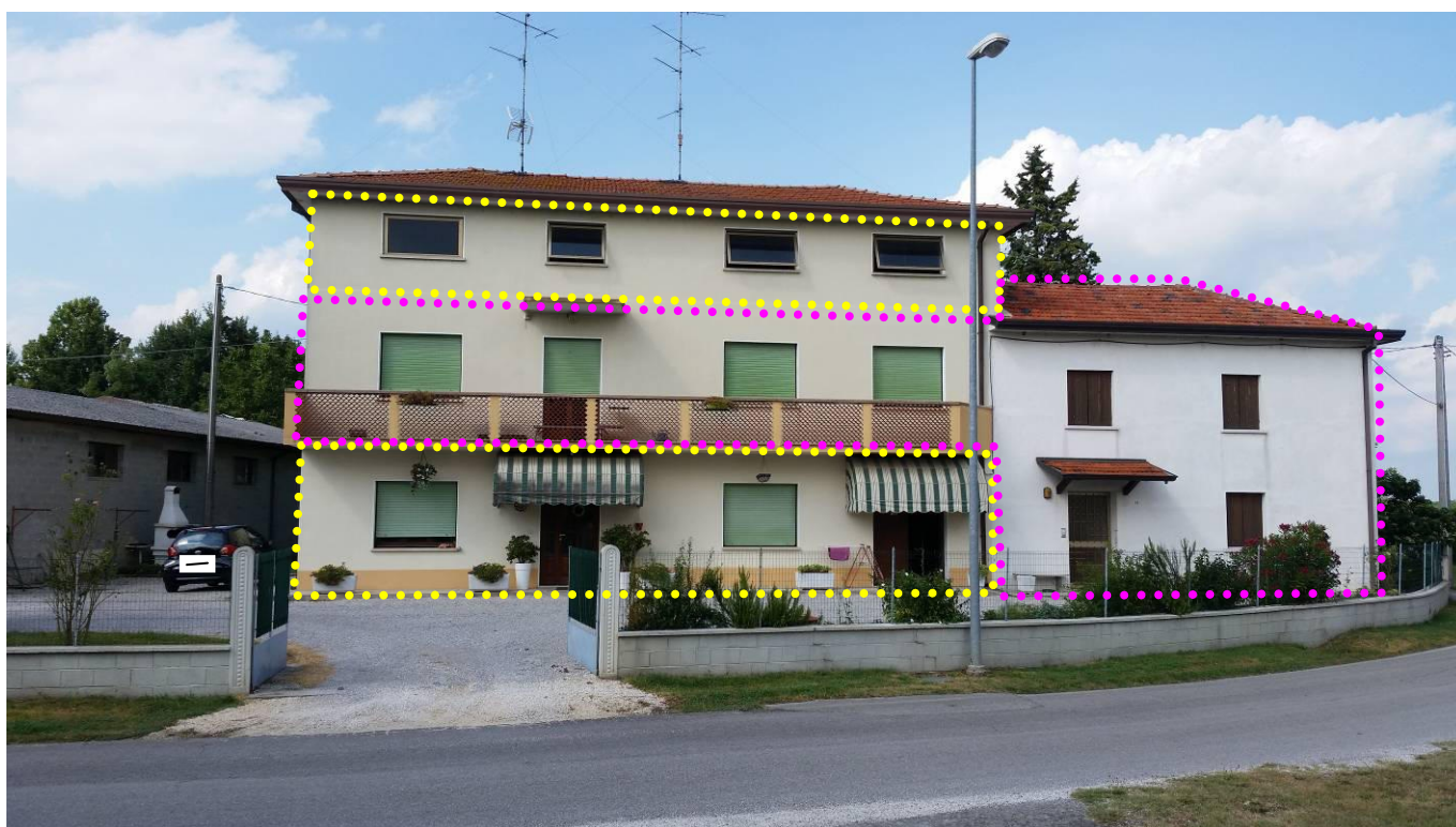
Foto 2 – vista dal fronte strada. In giallo LOTTO A (sub 1) in rosa LOTTO B (sub 2 e 3)
