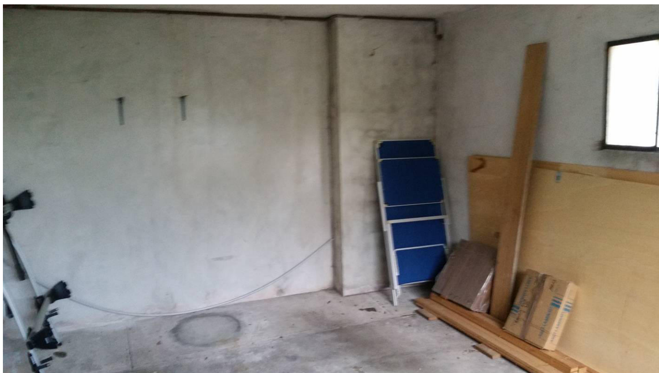
Foto 20 – Soffitta al piano primo
