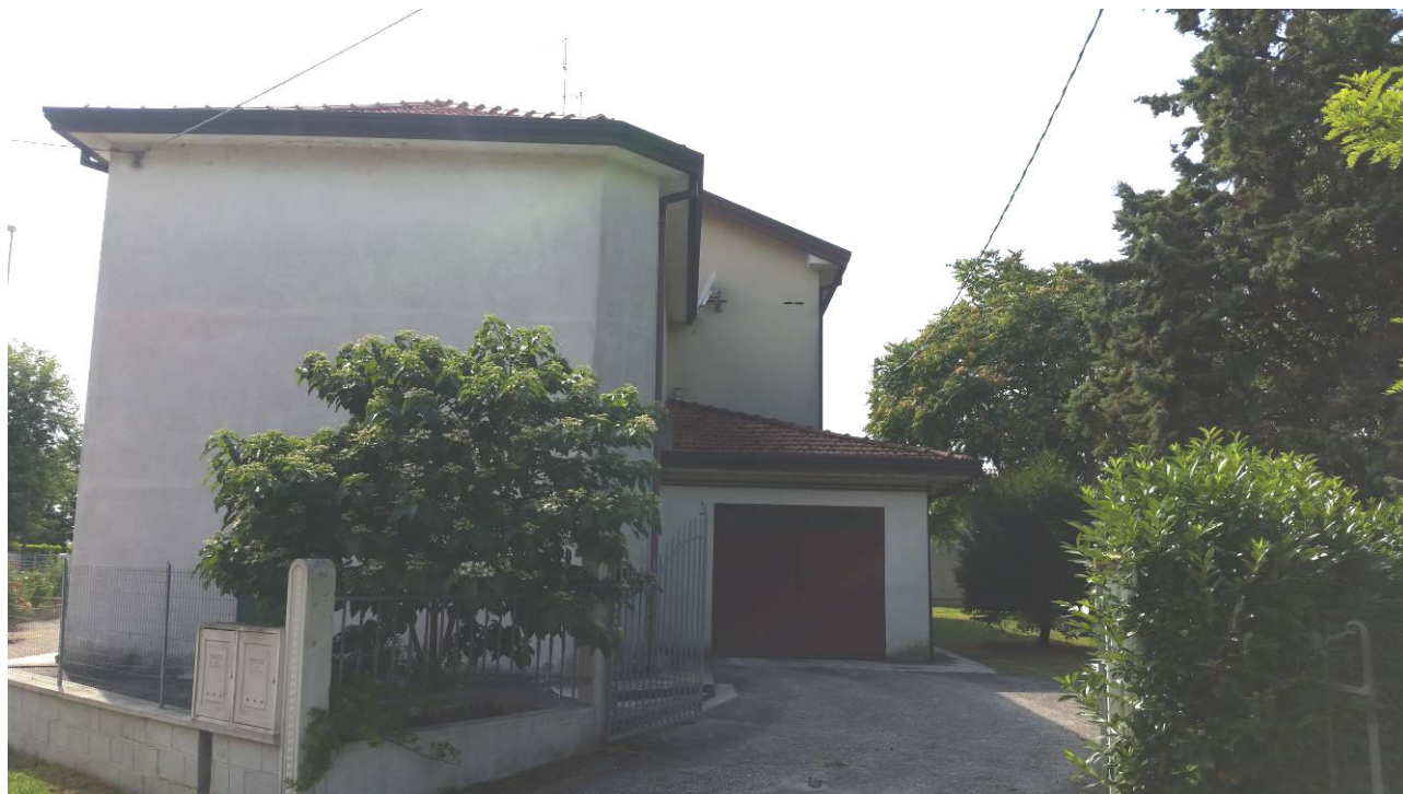
Foto 5 – prospetto laterale (garage, sub 3, del LOTTO B
