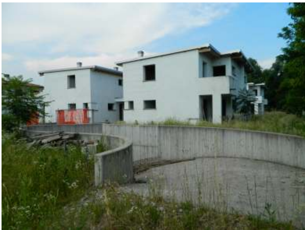
Foto n. 3 – Complesso eseguito con in primo rampa di accesso all'interrato. Vista da Sud-Ovest.
