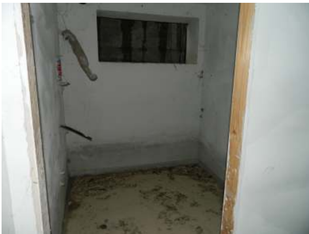
Foto n. 18 – Vano centrale termica-lavatoio.
