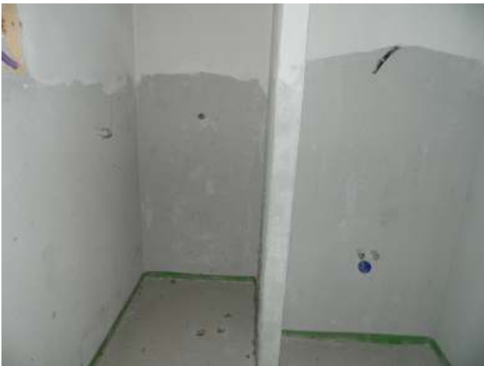
Foto n. 36 – Bagno al piano primo (tipologia sud).
