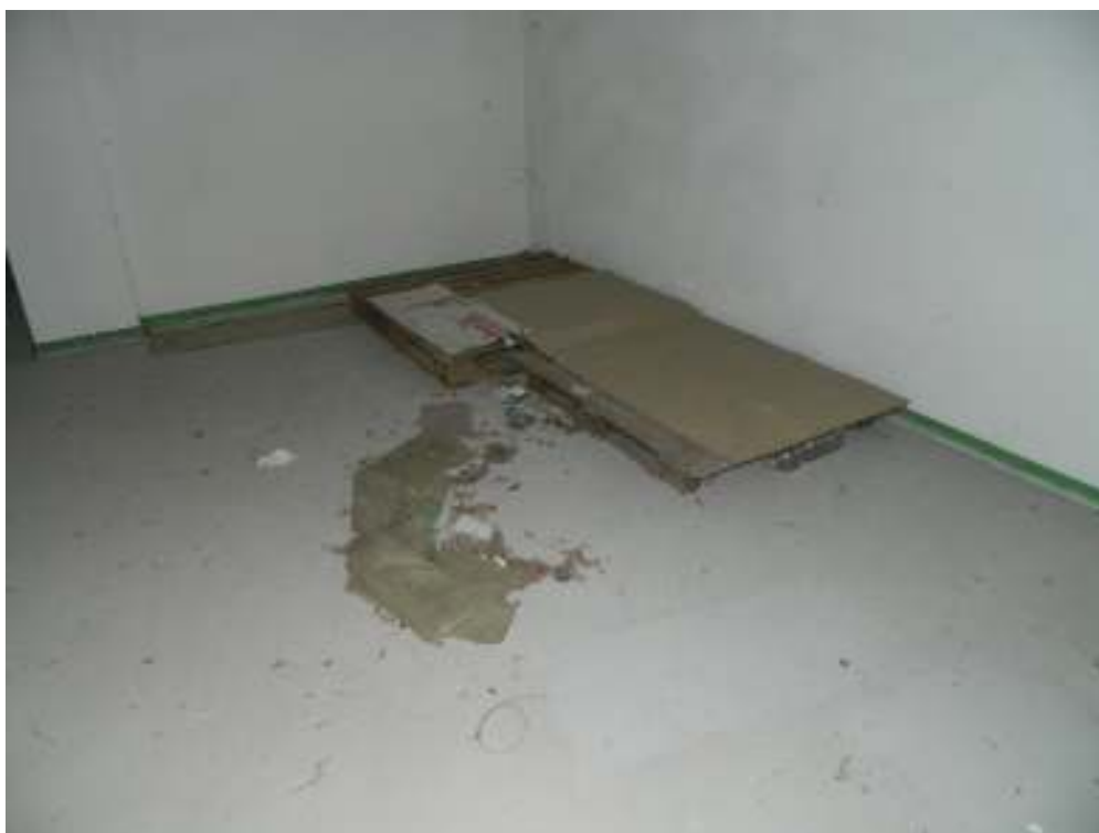
Foto n. 26 – Soggiorno piano terra (tipologia sud).
