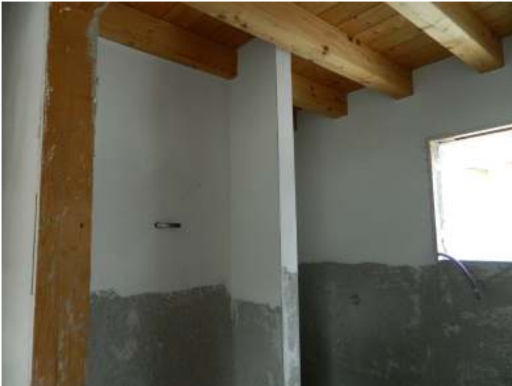
Foto n. 39 – Bagno al piano primo (tipologia nord).
