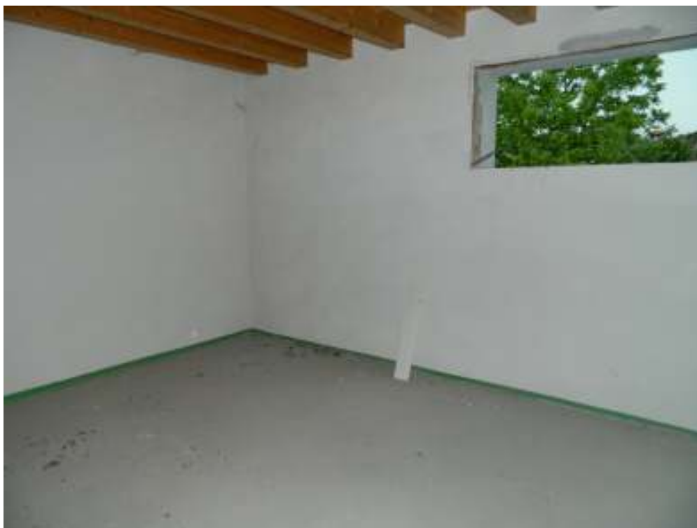
Foto n. 31 – Camera al piano primo (tipologia sud).
