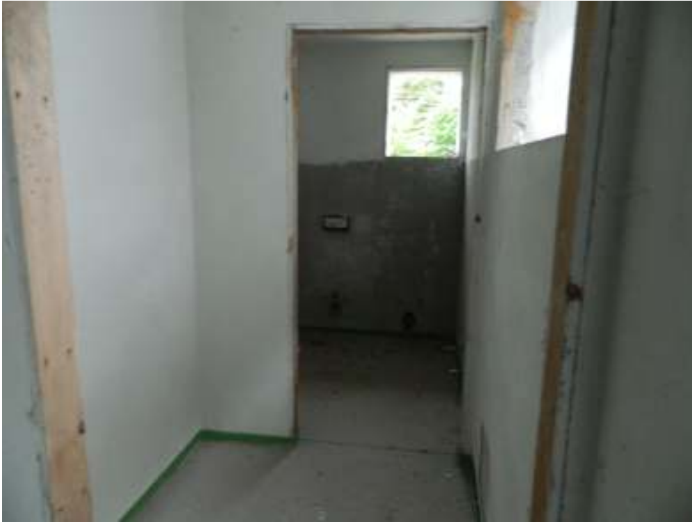
Foto n. 23 – Ingresso piano terra, con vista sul bagno (tipologia sud).
