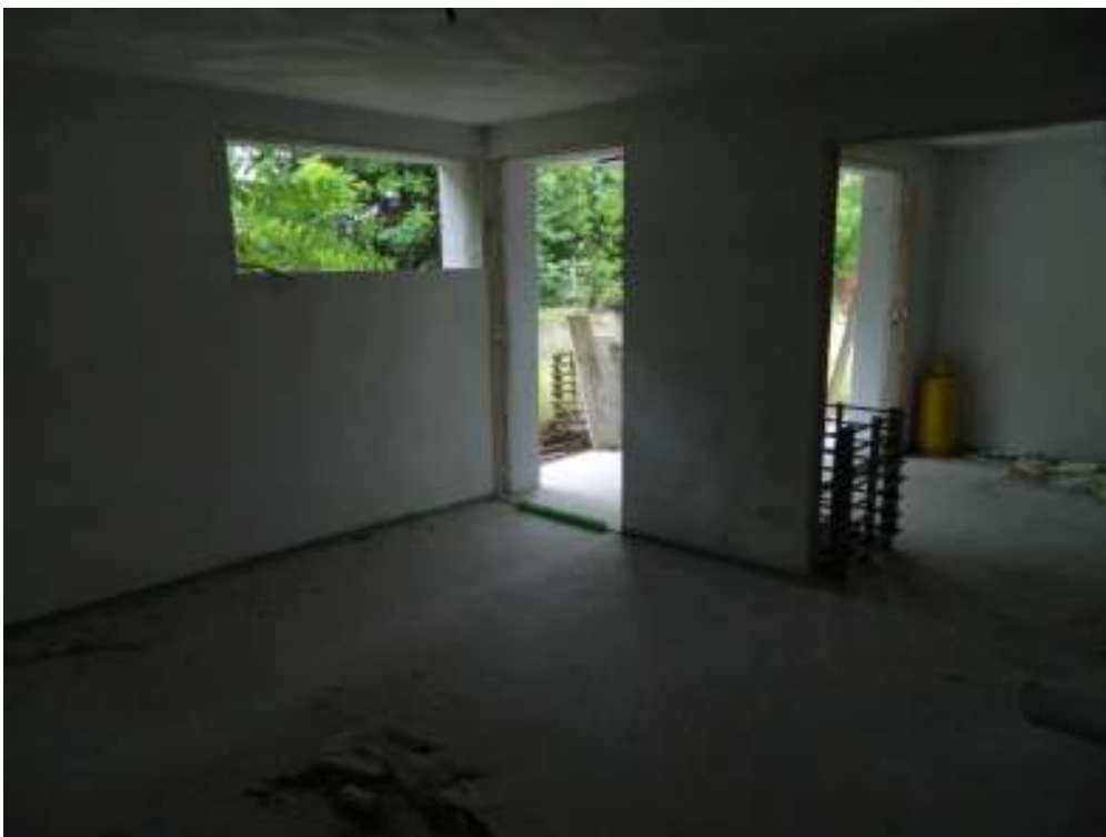
Foto n. 24 – Soggiorno piano terra (tipologia sud).
