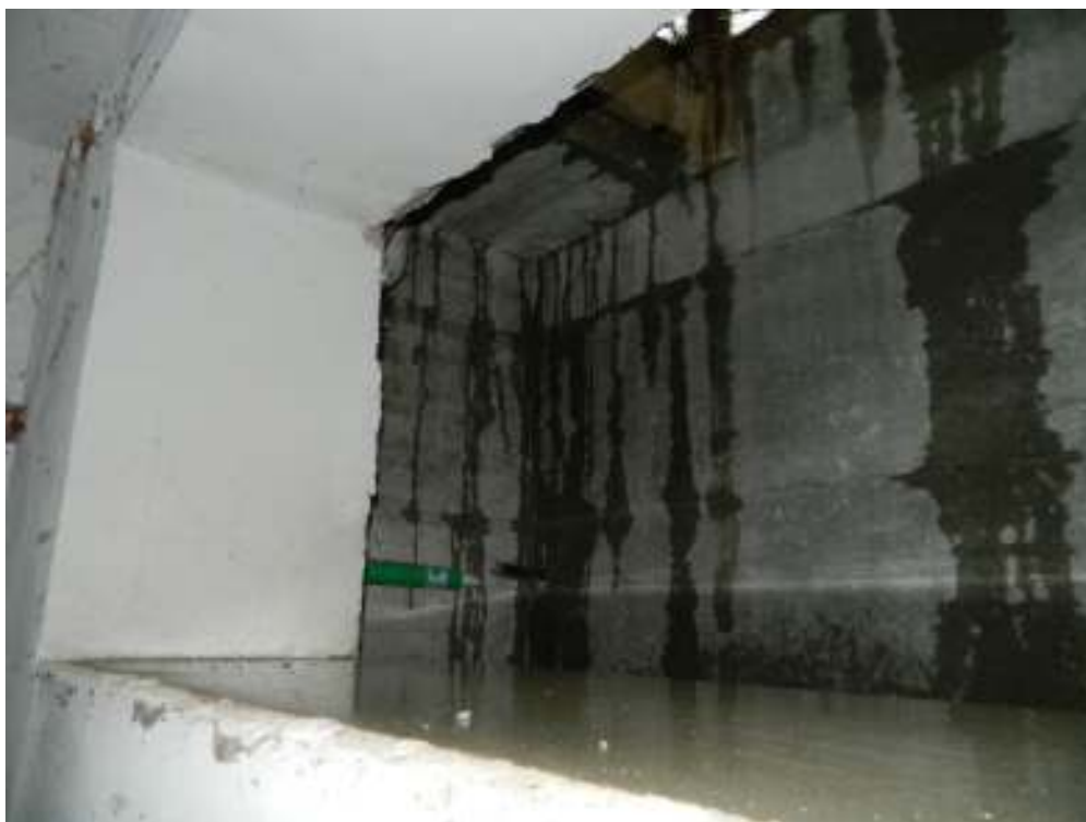
Foto n. 19 – Bocca di lupo per illuminazione centrale termica-lavatoio.
