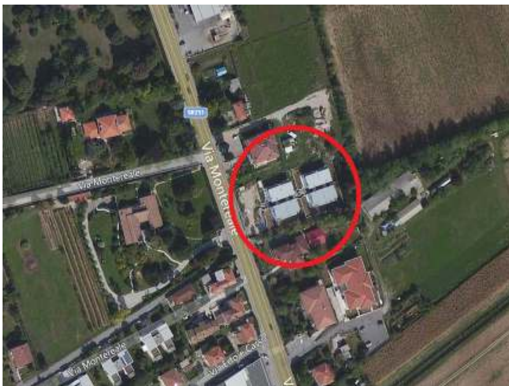
Foto n. II – Foto aerea del condominio contenente il bene oggetto di esecuzione – casa singola con casa scoperta al centro del cerchio rosso (fonte bing map).
