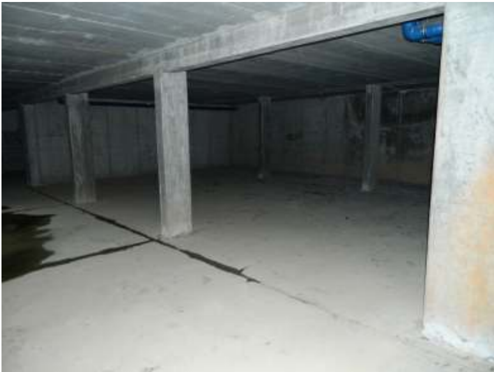
Foto n. 13 – Parcheggi coperti dell'interrato (lato sud).
