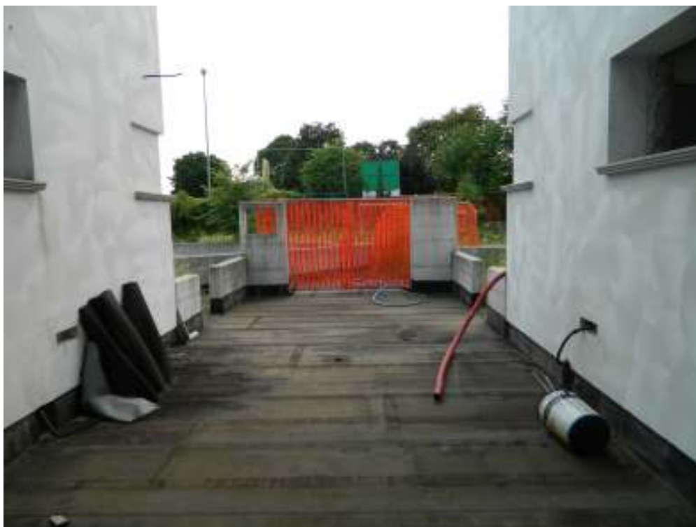
Foto n. 8 – Vialeto di raccordo delle unità abitative al piano terra (vista da Est). In primo piano accesso pedonale. Si evidenzia l'impermeabilizzazione, con pavimentazione non ultimata.
