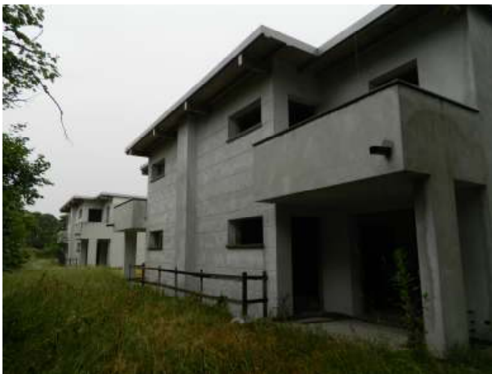
Foto n. 4 – Complesso eseguito viato da Sud-Est.
