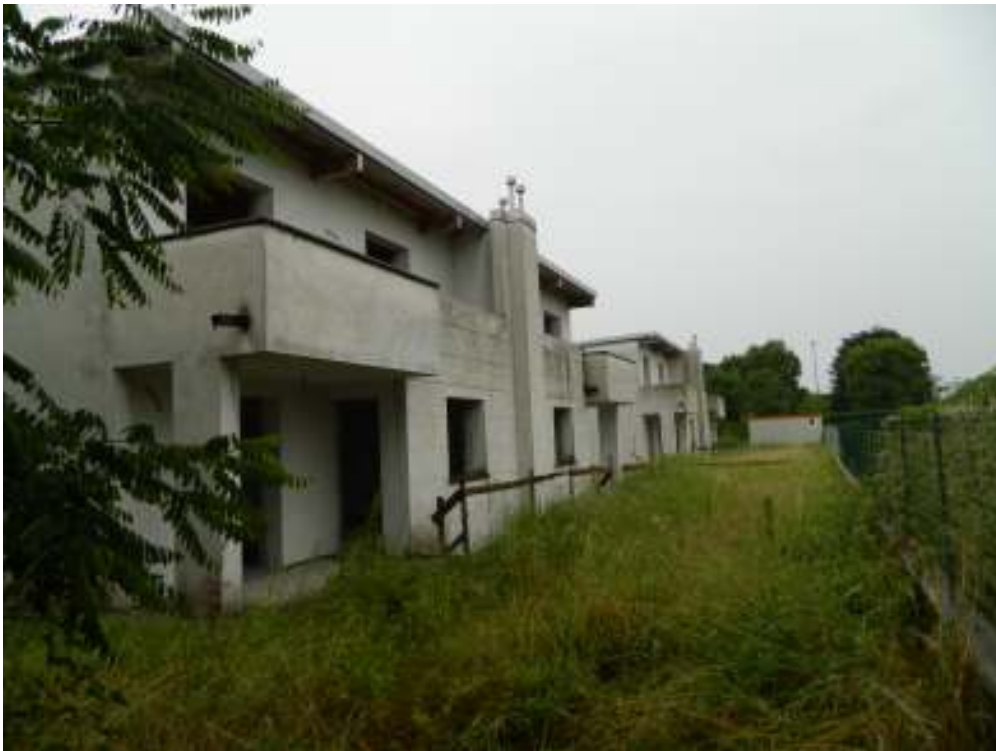
Foto n. 5 – Complesso eseguito viato da Nord-Est.
