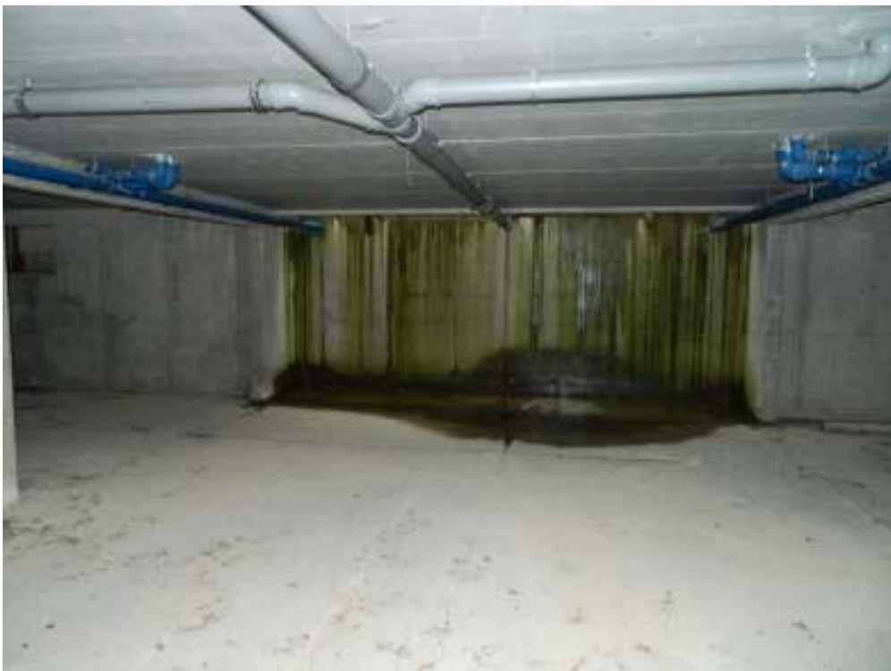
Foto n. 12 – Dettaglio della bocca di lupo dell'interrato ad est.
