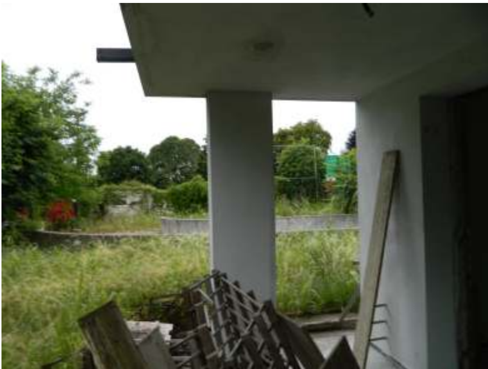
Foto n. 28 – Porticato piano terra (tipologia sud), accessibile dal soggiorno.
