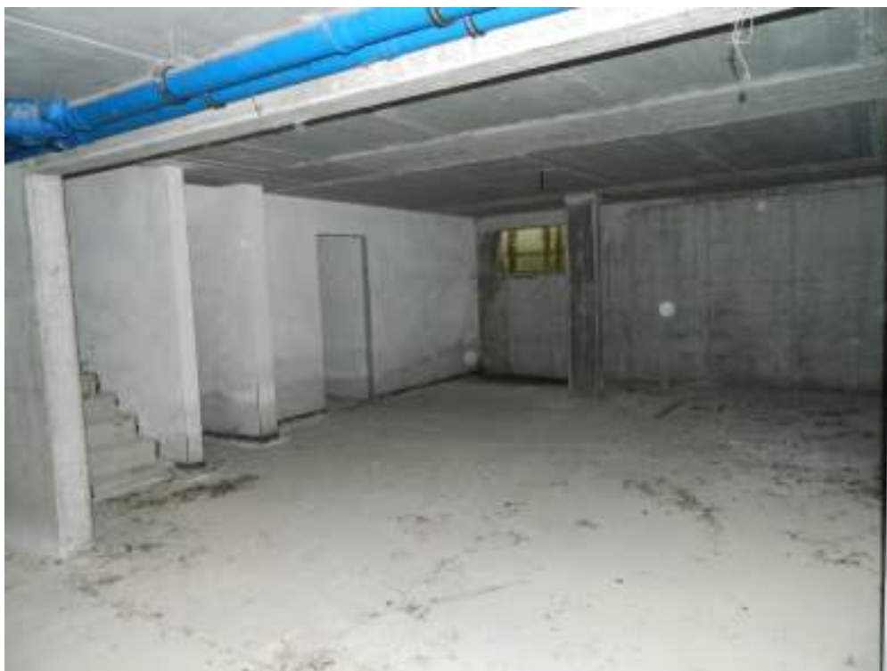
Foto n. 15 – Piano interrato unità abitativa (tipologia nord).
