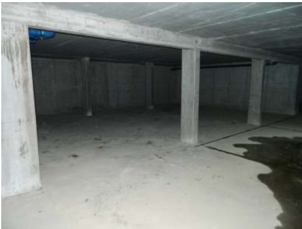
Foto n. 14 – Parcheggi coperti dell'interrato (lato nord).
