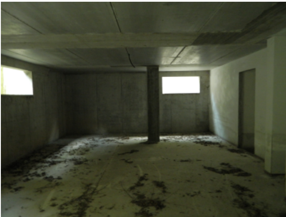
Foto n. 49 – Stato dei luoghi nell'interrato.
