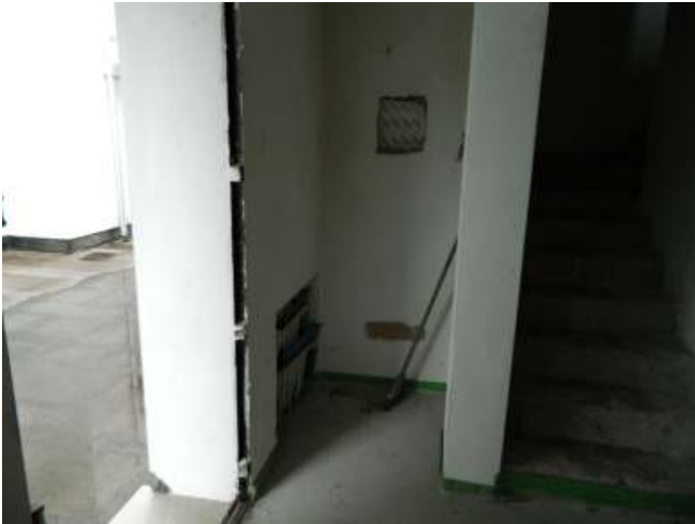
Foto n. 21 – Ingresso piano terra (tipologia sud).
