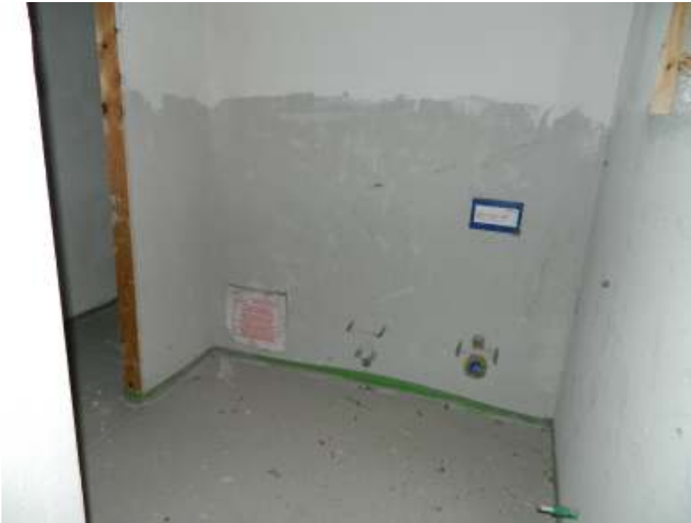
Foto n. 37 – Bagno al piano primo (tipologia sud).
