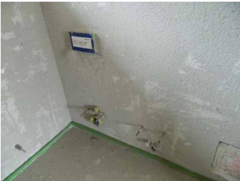
Foto n. 40 – Bagno al piano primo (tipologia nord).
