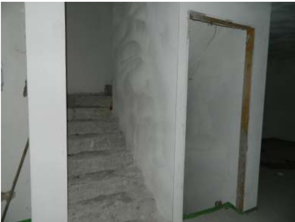
Foto n. 22 – Ingresso piano terra (tipologia sud).
