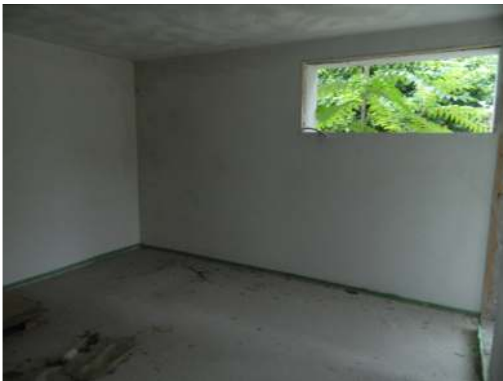
Foto n. 25 – Soggiorno piano terra (tipologia sud).
