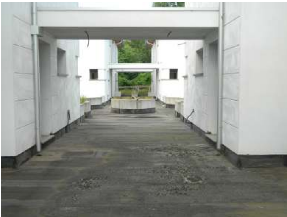
Foto n. 9 – Vialetto di raccordo delle unità abitative al piano terra (vista da Ovest). In primo piano ballatoi ornamentali di collegamento delle unità e foro prendiluce dell'interrato. Si evidenzia l'impermeabilizzazione, con pavimentazione non ultimata.
