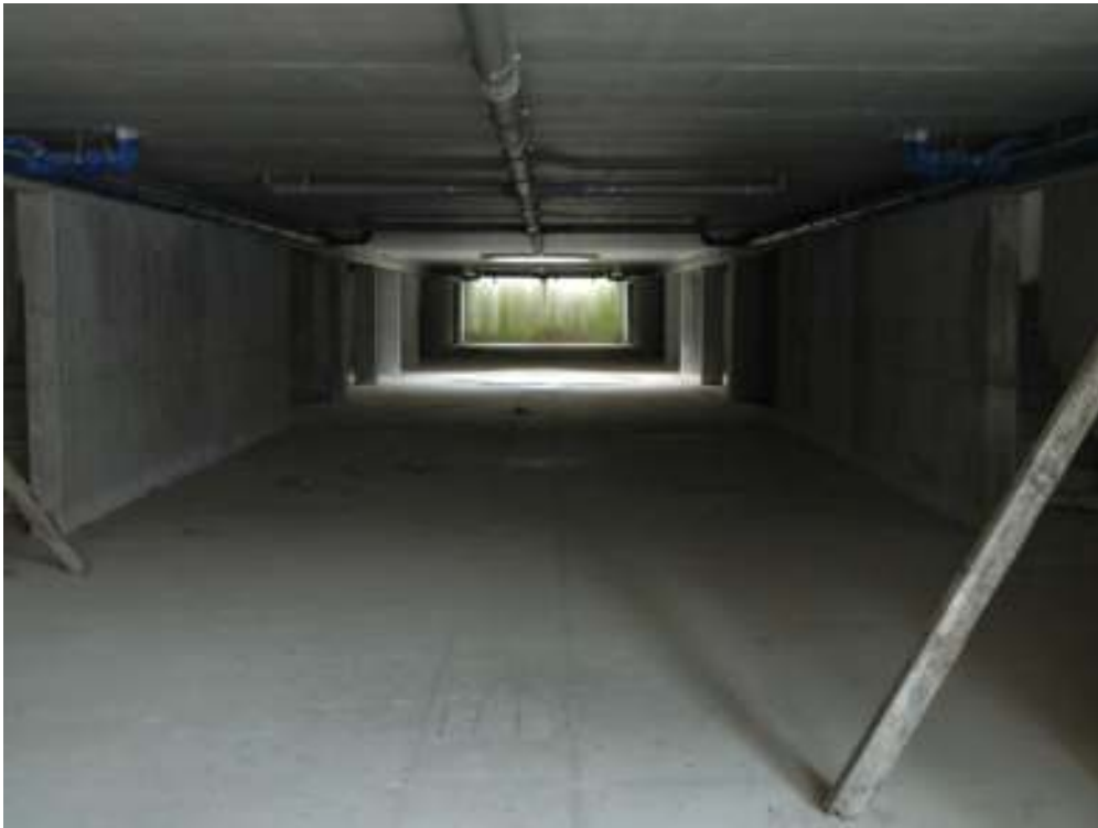
Foto n. 11 – Vano comune dell'interrato di accesso alle autorimesse.
