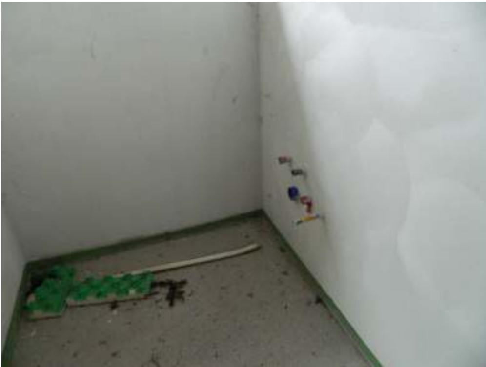
Foto n. 27 – Vano cottura, con predisposizione impianti idrosanitari.
