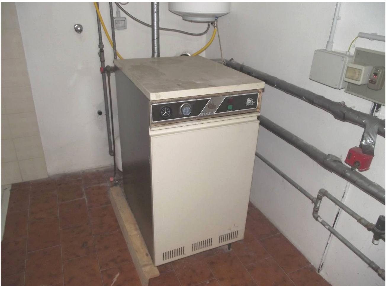
Foto 16 – caldaia a basemento non funzionante
