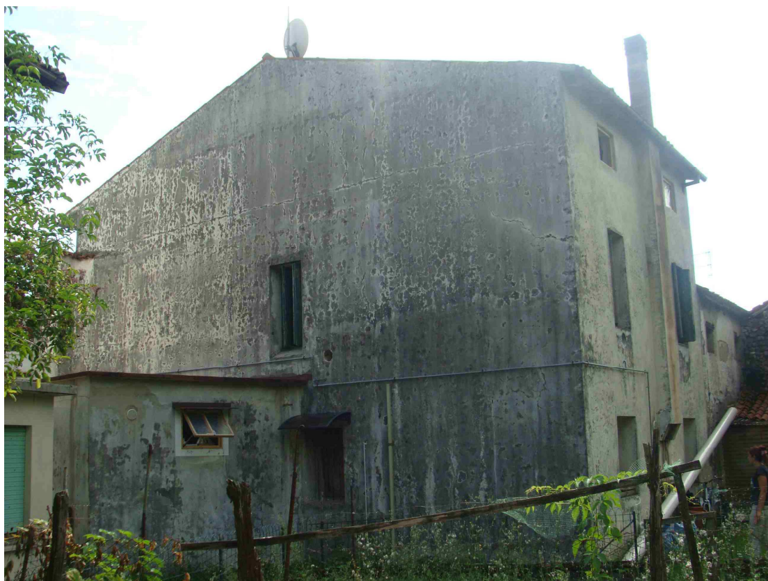
Veduta prospetto laterale
