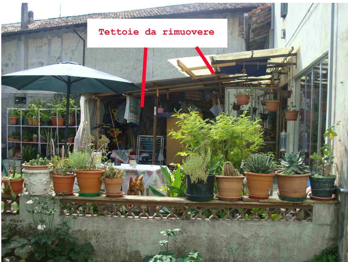
Veduta area esterna
