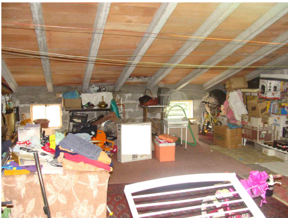
Veduta Soffitta p. 2
