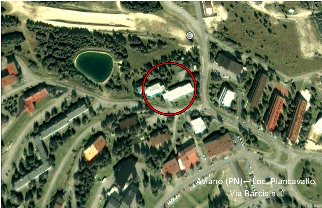
FOTO AEREA – Individuazione Fabbricato
