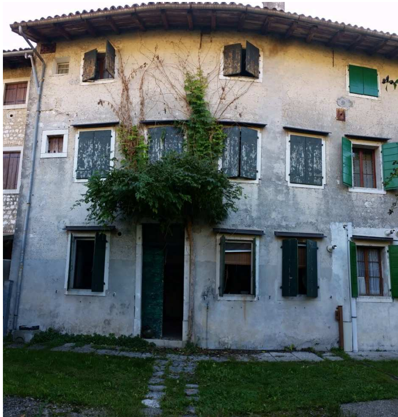
Foto 2 Vista esterna sud lato corte
