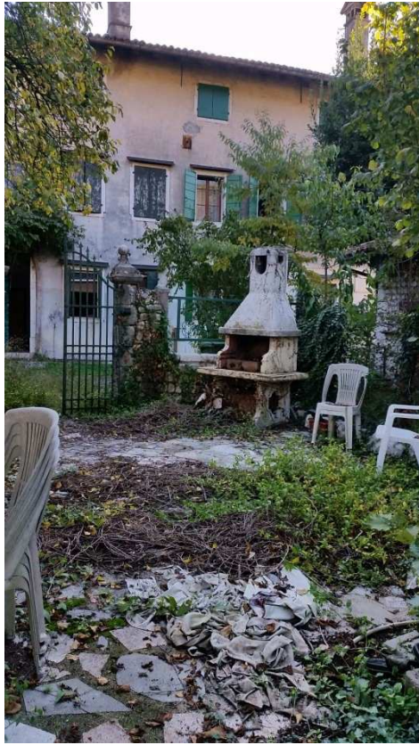
Foto 3 Vista giardino mappale 1310
