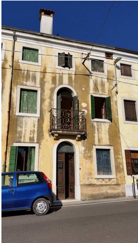
Foto 1 Vista esterna nord da Via Cardazzo
