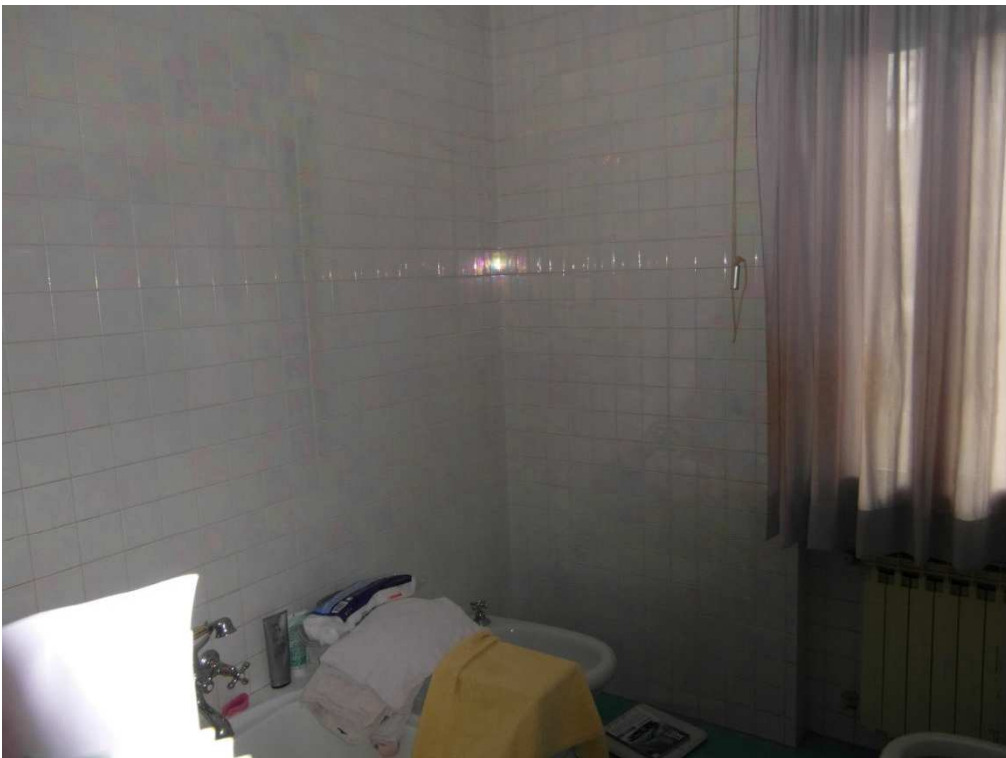
Foto n. 22 – Bagno principale piano terra. Dettaglio sanitari.
