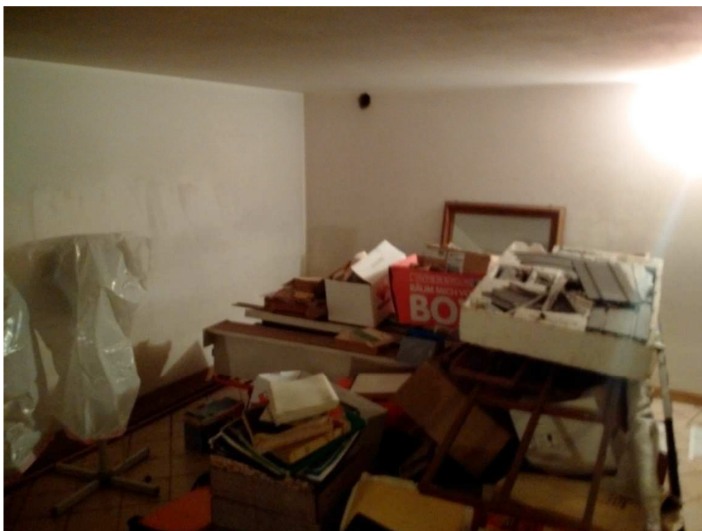
Foto n. 42 – Magazzino (privo di titoli autorizzativi) dell'interrato.
