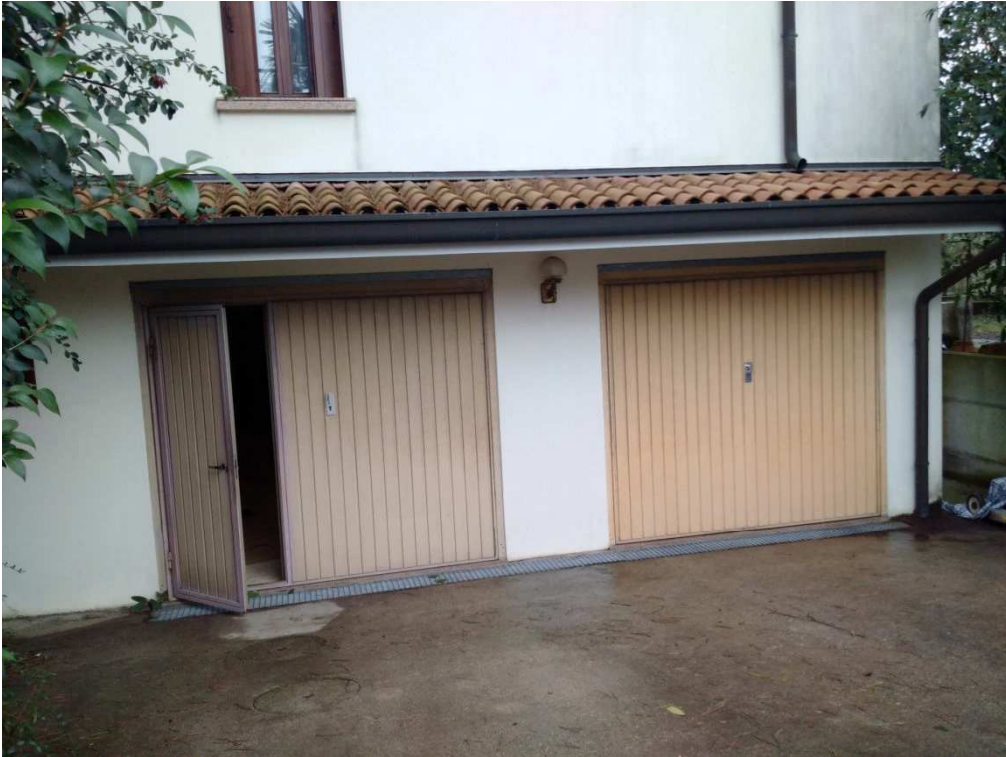
Foto n. 43 – Accesso autorimesse, con porta pedonale ricavata nel basculante.
