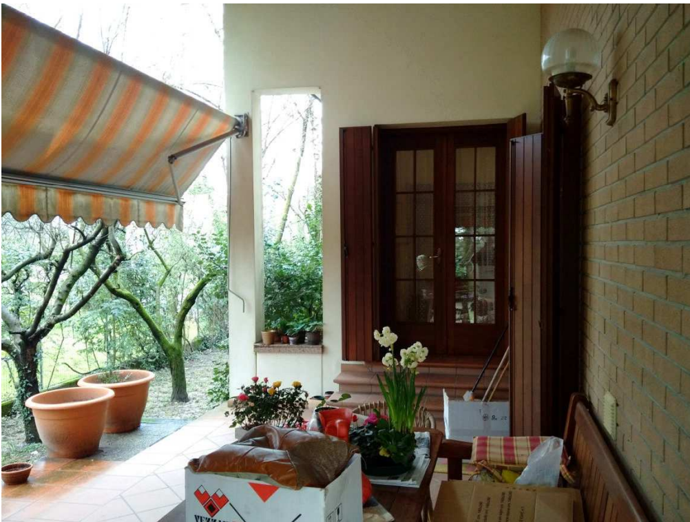
Foto n. 8 – Ingressi da porte finestre dal porticato.
