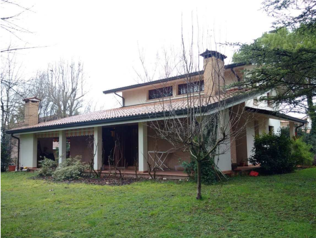
Foto n. 1 – Immobile esecutato dall'interno del giardino (lato Sud-Est).
