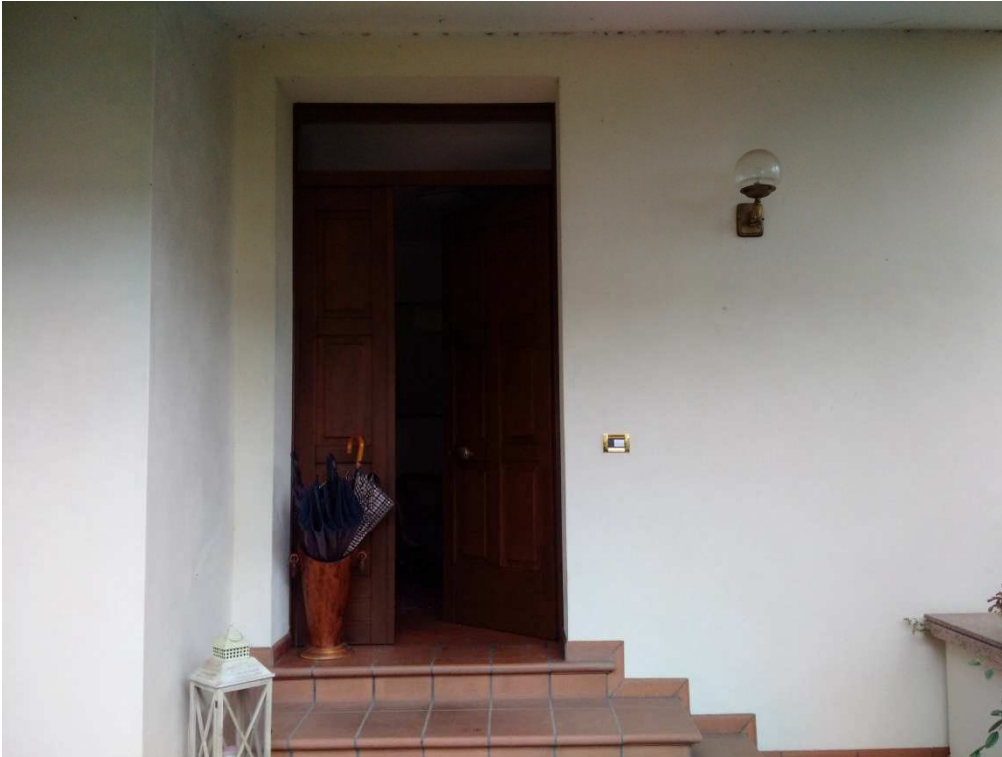
Foto n. 7 – Portoncino d'ingresso principale.
