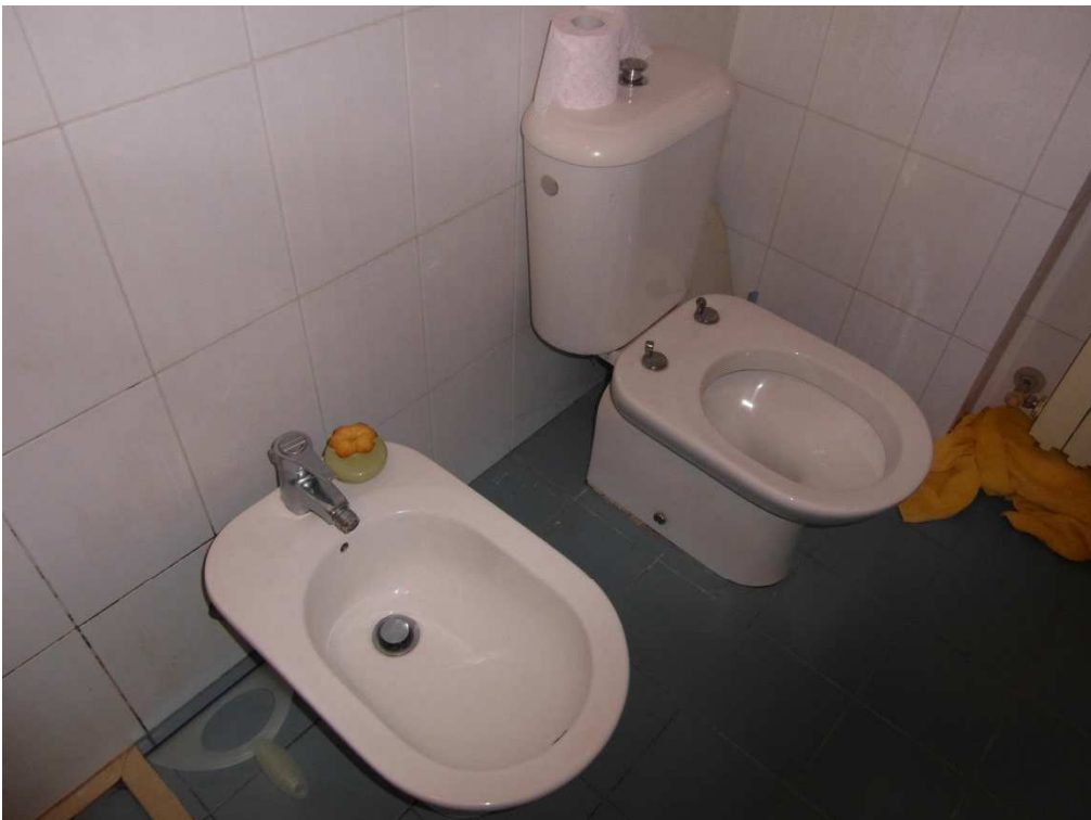
Foto n. 24 – Bagno secondario piano terra. Dettaglio sanitari.
