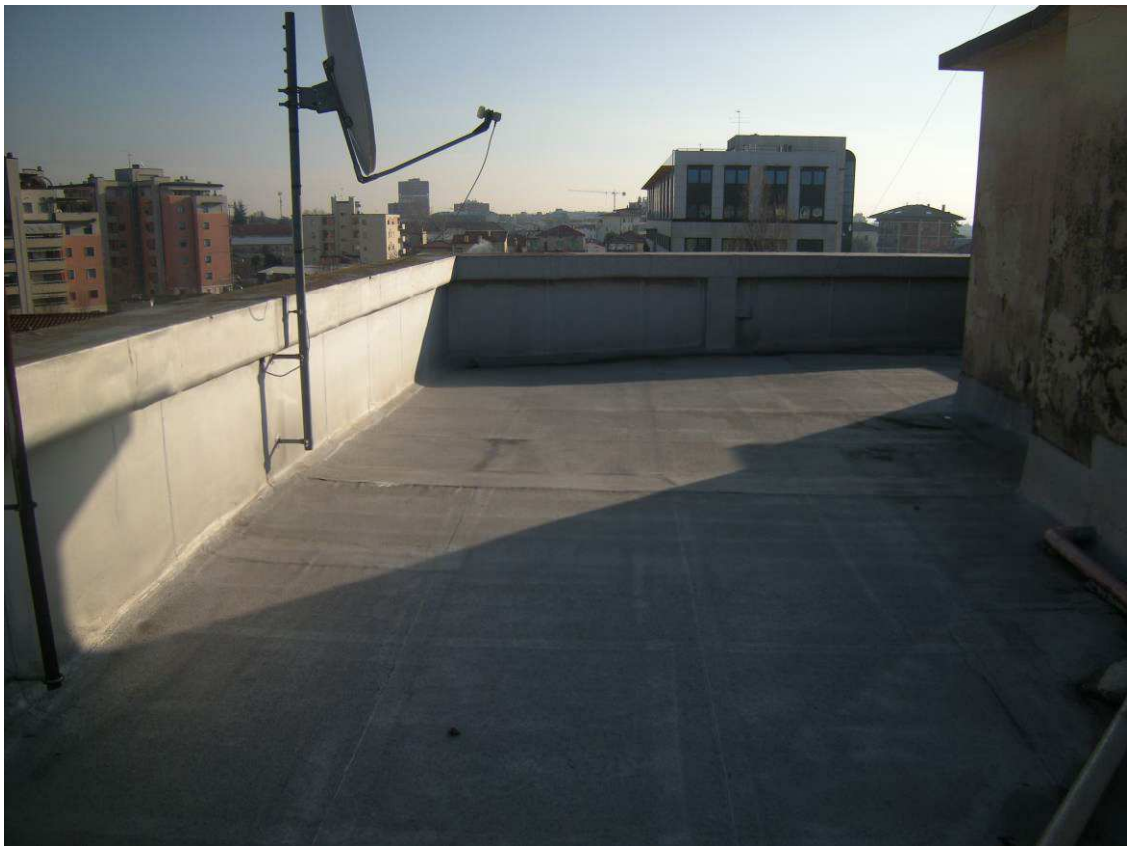
Pordenone, via Nicoletta n. 7 – La terrazza di copertura dell'edificio.
