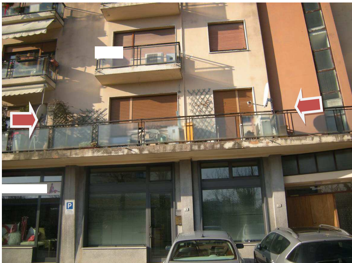
Pordenone, via Nicoletta – Sopra il prospetto est della palazzina, sotto quello dell'immobile.
