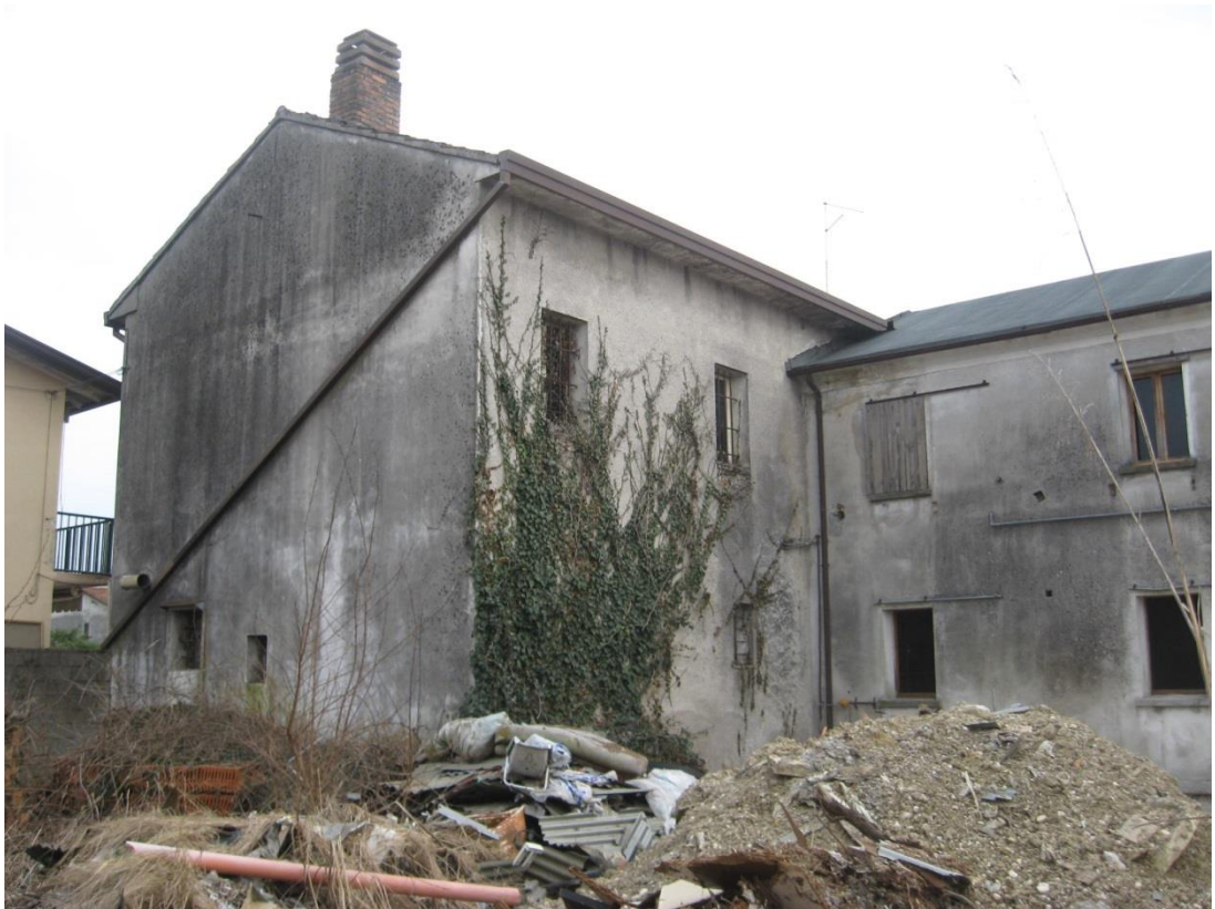
Vista lati nord-est e nord-ovest - corte contermina invasa da masserizie e rifiuti edili
