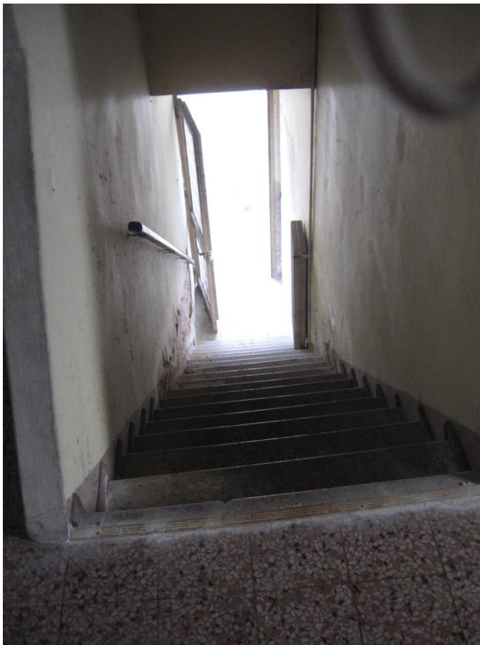
A scala d'accesso all'unità abitativa, vista da quest'ultima
