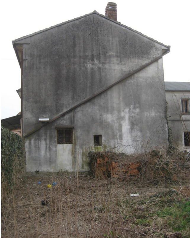
Lato nord-est con pluviale
