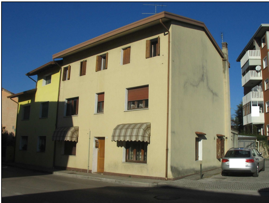
Fig.2: vista sud - est
