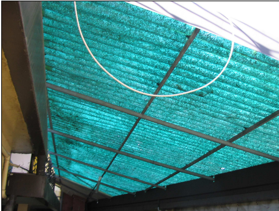
Fig.22: vista tettoia nord piano terra
