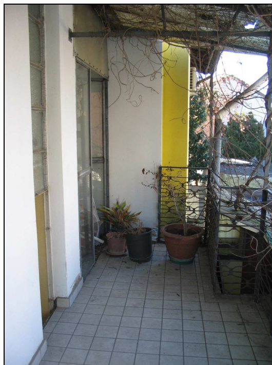
Fig.31: vista terrazzo piano primo
