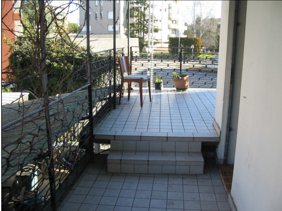
Fig.32: altra vista terrazzo piano primo
