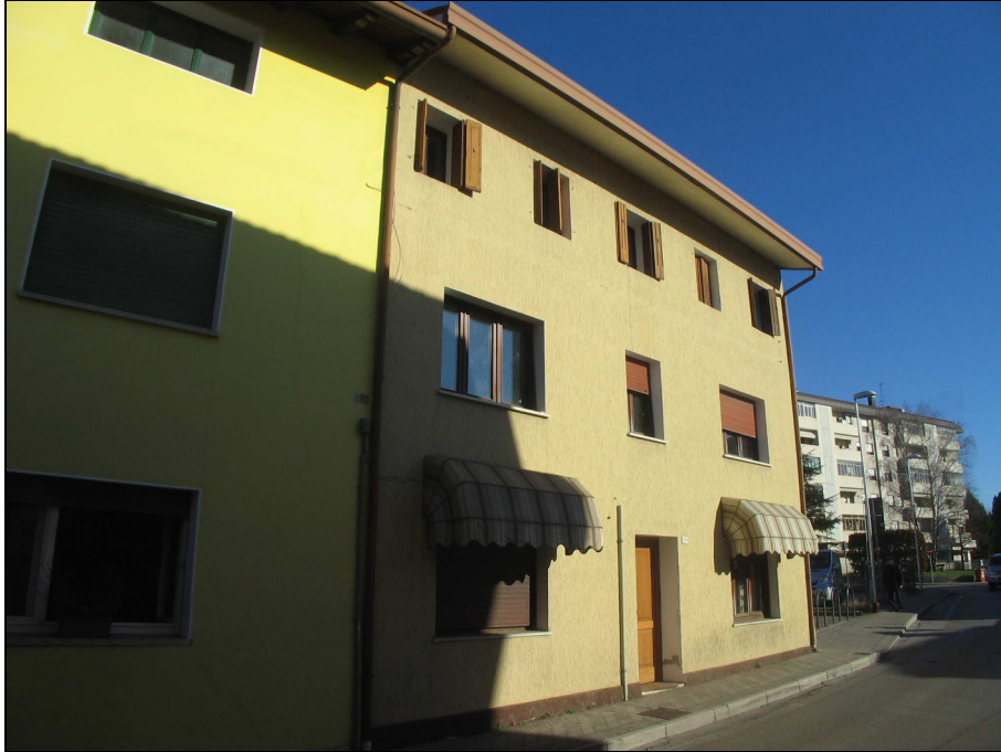
Fig.1: vista da sud – ovest
