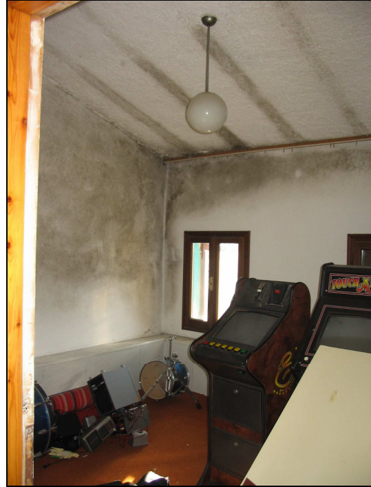
Fig.40: locale soffitta sud est
