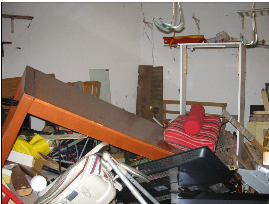
Fig.21: vista interno garage
