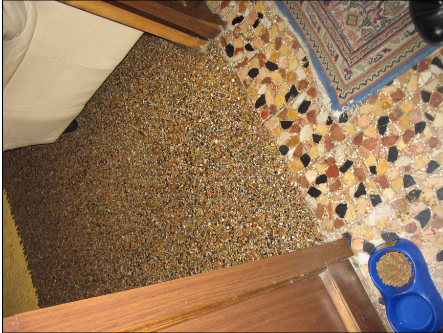
Fig.8: particolare pavimento soggiorno e cucina
