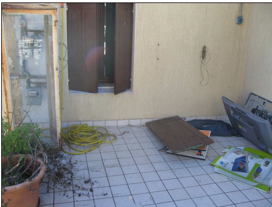
Fig.33: altra vista terrazzo piano primo
