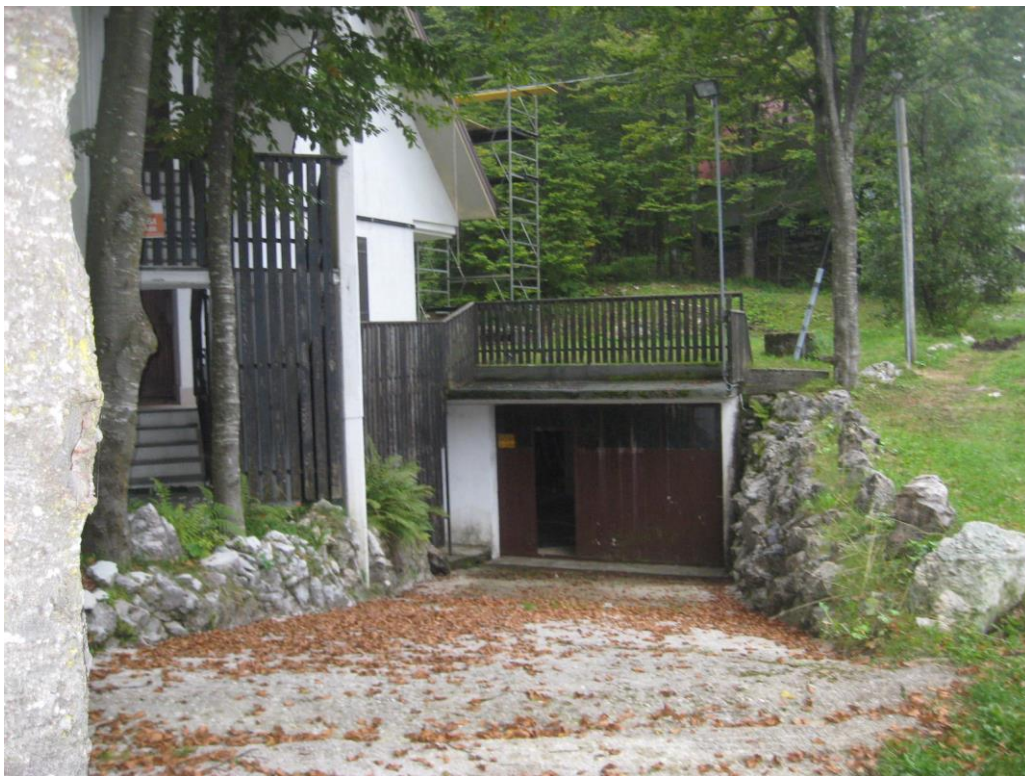
La rampa-scivolo che conduce allo spazio autorimessa
