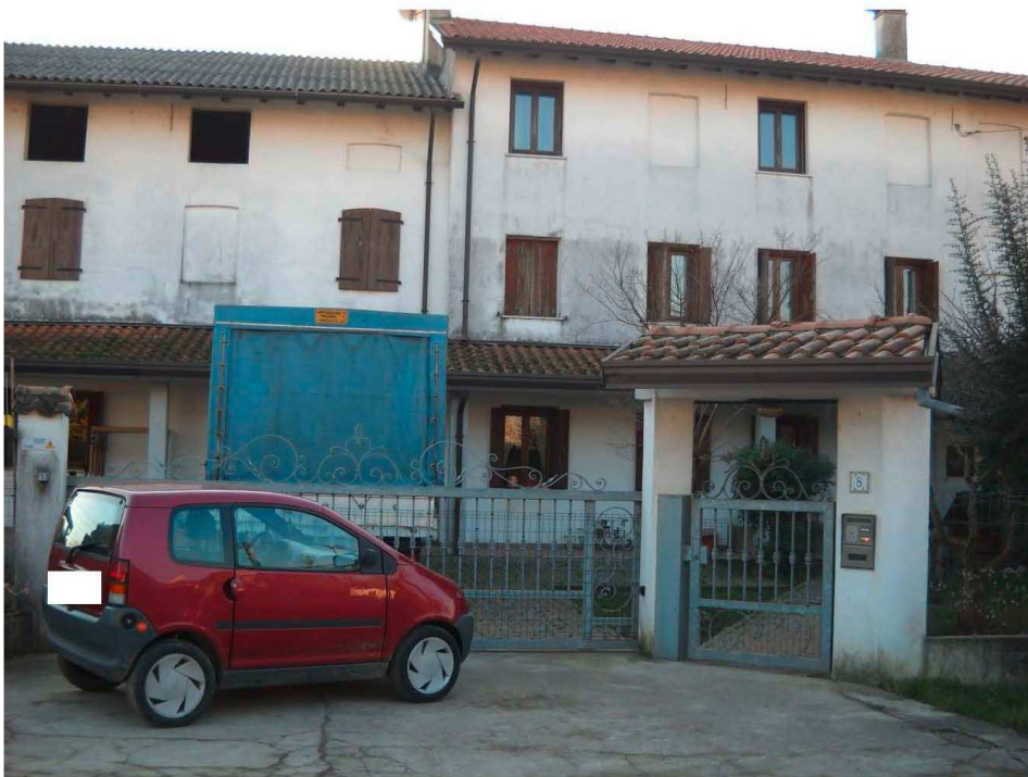
Foto 2 Vista frontale del fabbricato
