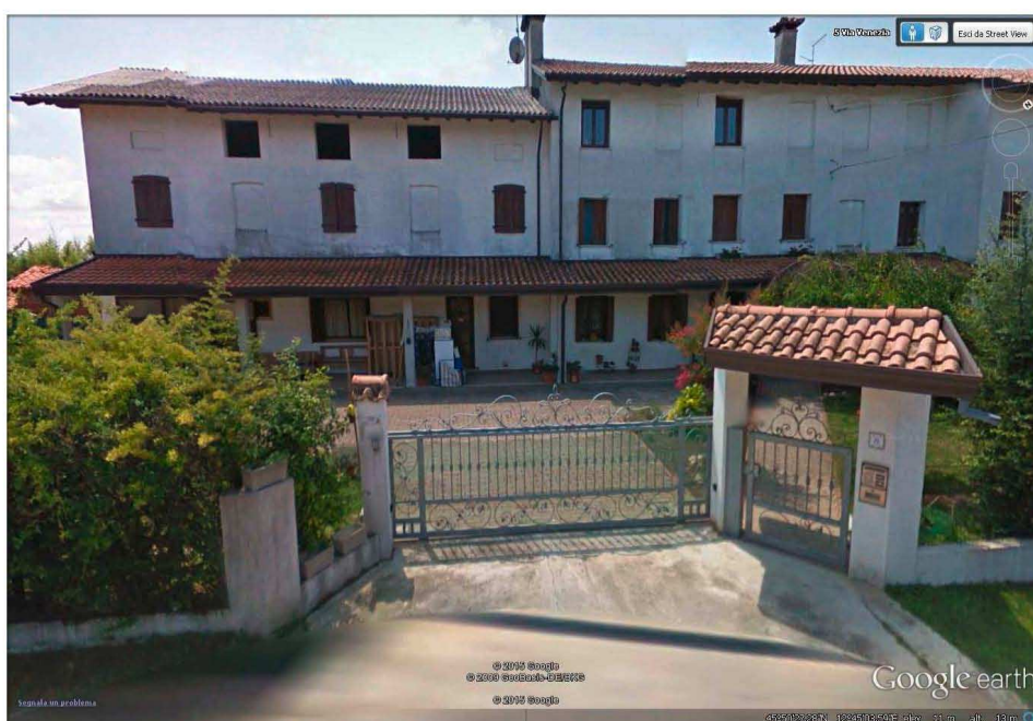
Foto 1 Vista del fabbricato da Via Venezia
