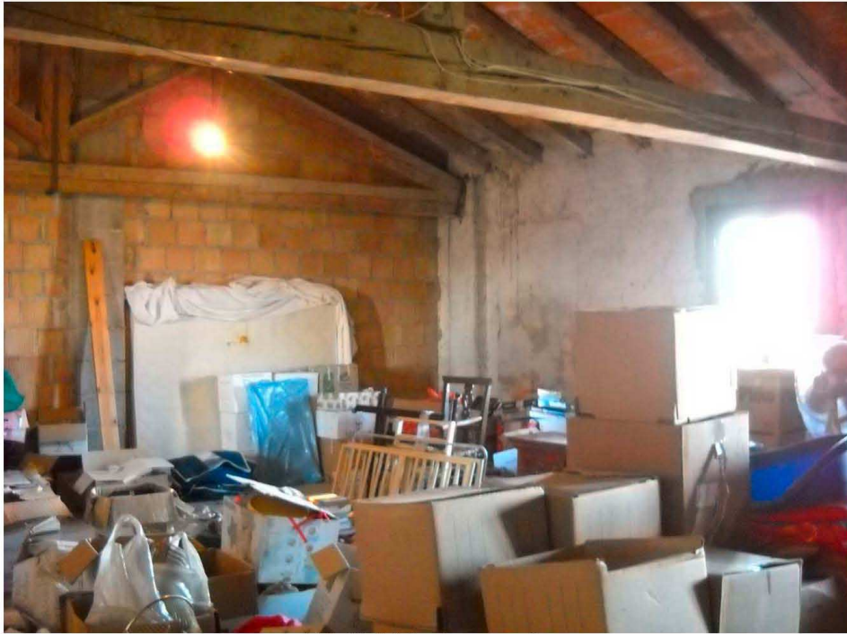
Foto 20 Soffitta piano secondo
