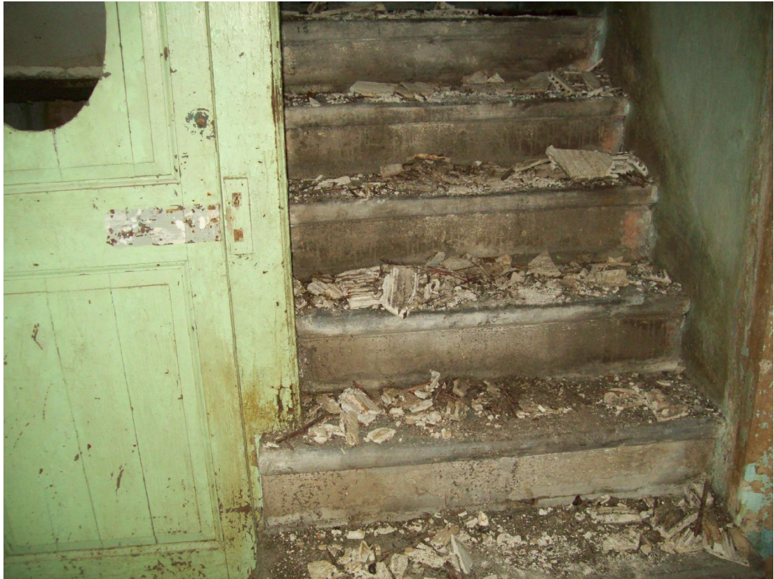
Foto 21: Prima rampa scala
