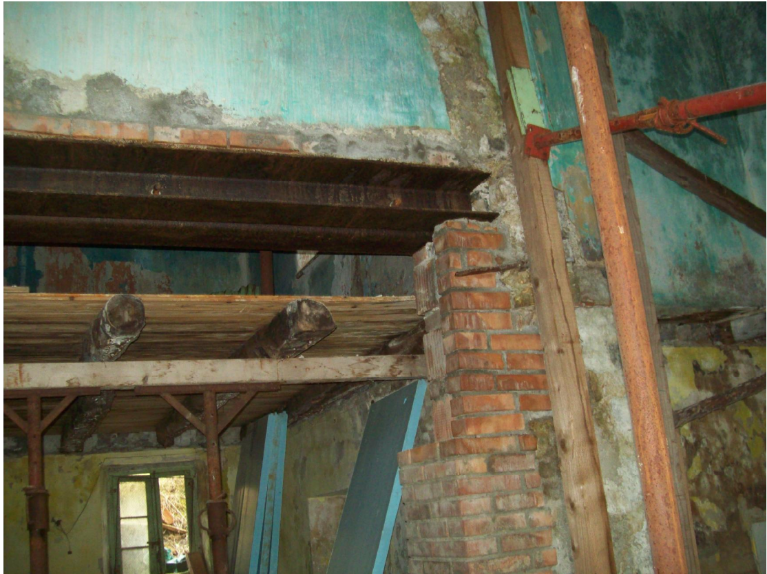
Foto 17: Muro centrale cucina
