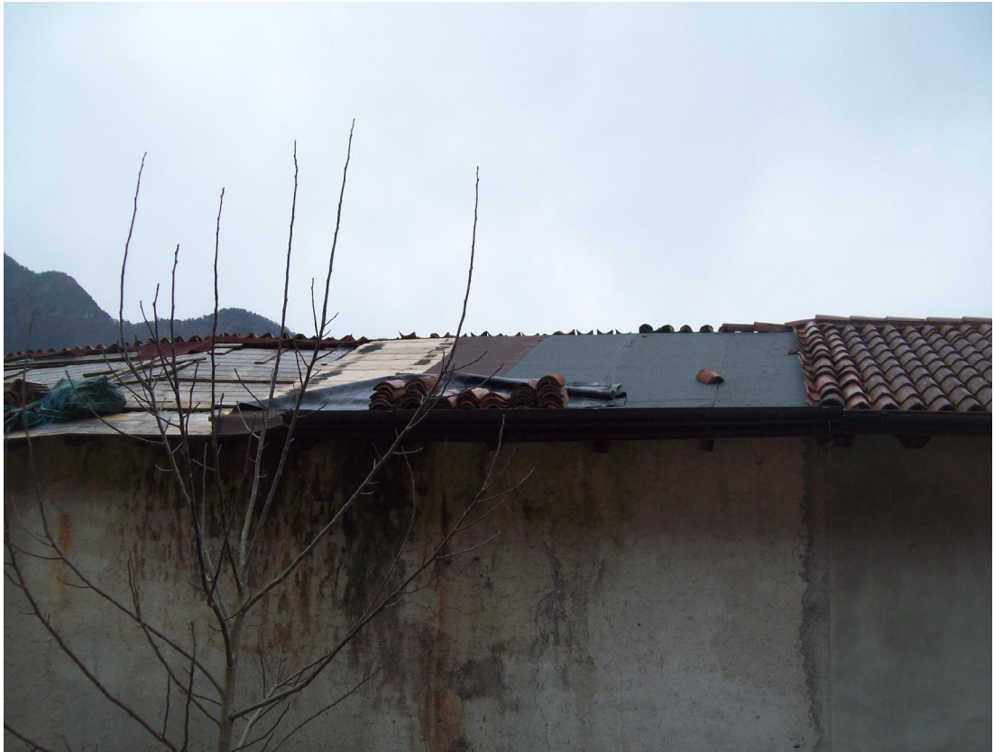
Foto 9: Falda tetto a Nord
