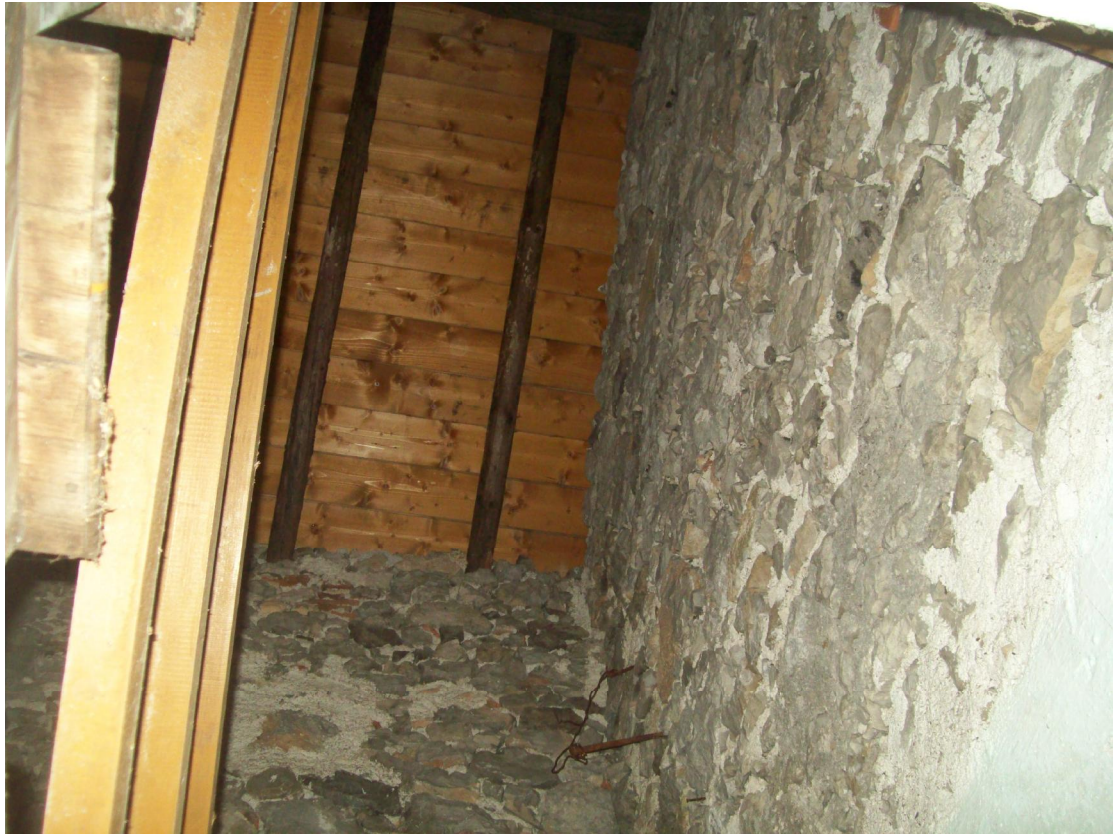
Foto 31: Tetto vano scale
