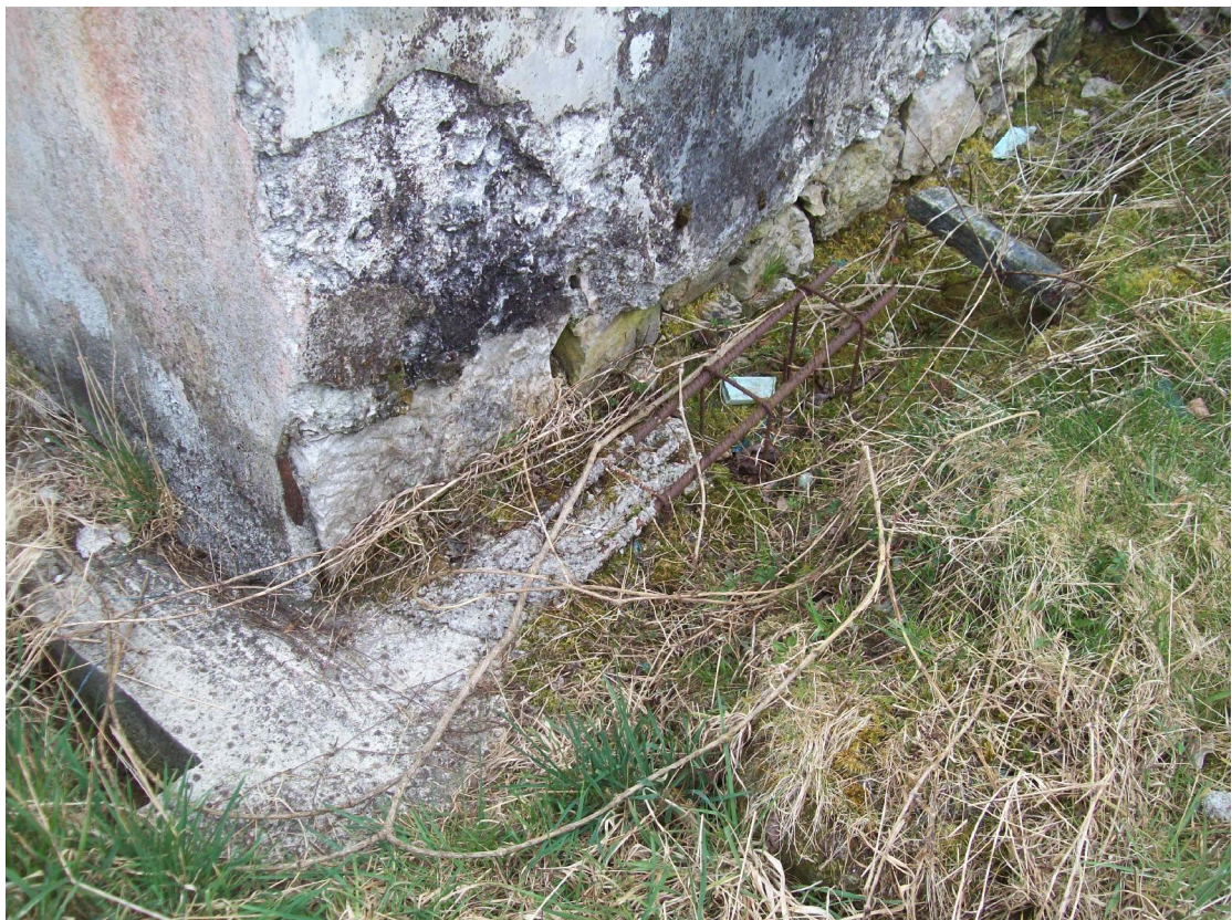
Foto 12: Particolare rinforzo fondazioni angolo Sud-Est
