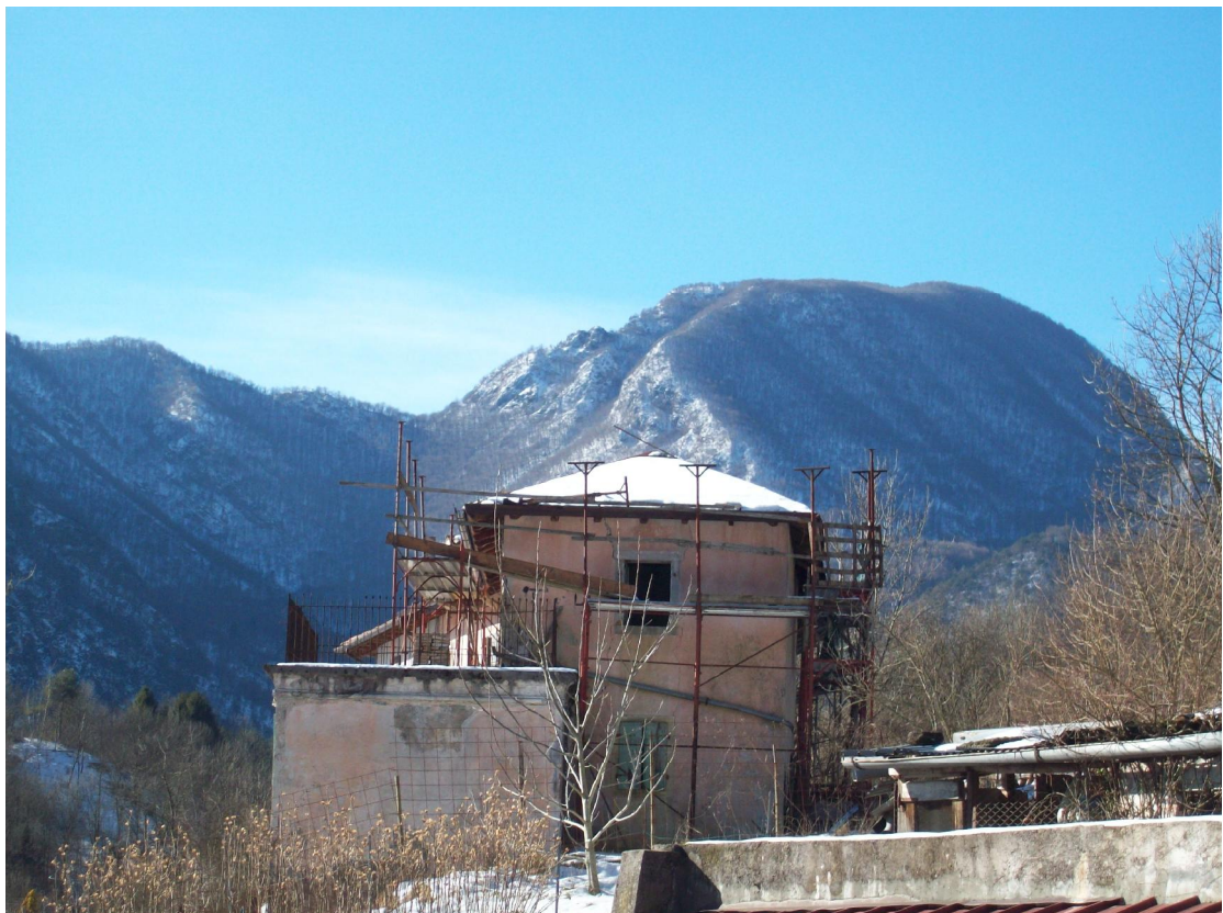
Foto 4: Vista da Est abitazione
