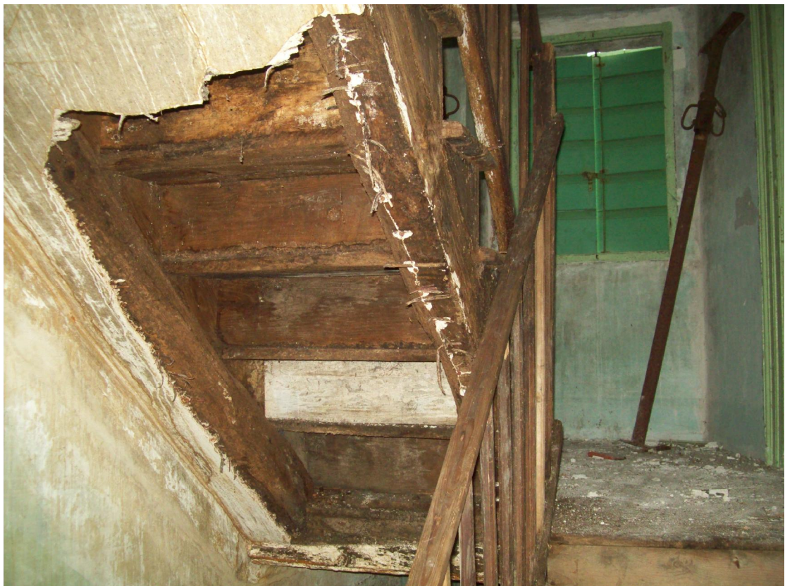
Foto 22: Particolare rampa lignea
