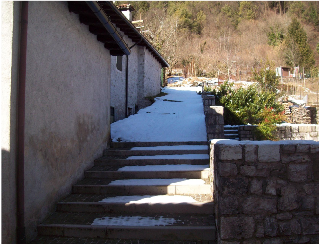
Foto 15: Accesso da Via Venezia
