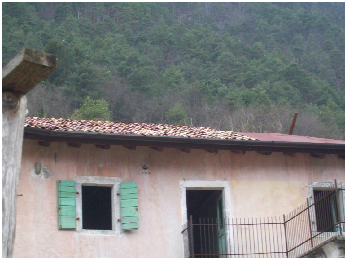
Foto 10: Falda Sud copertura
