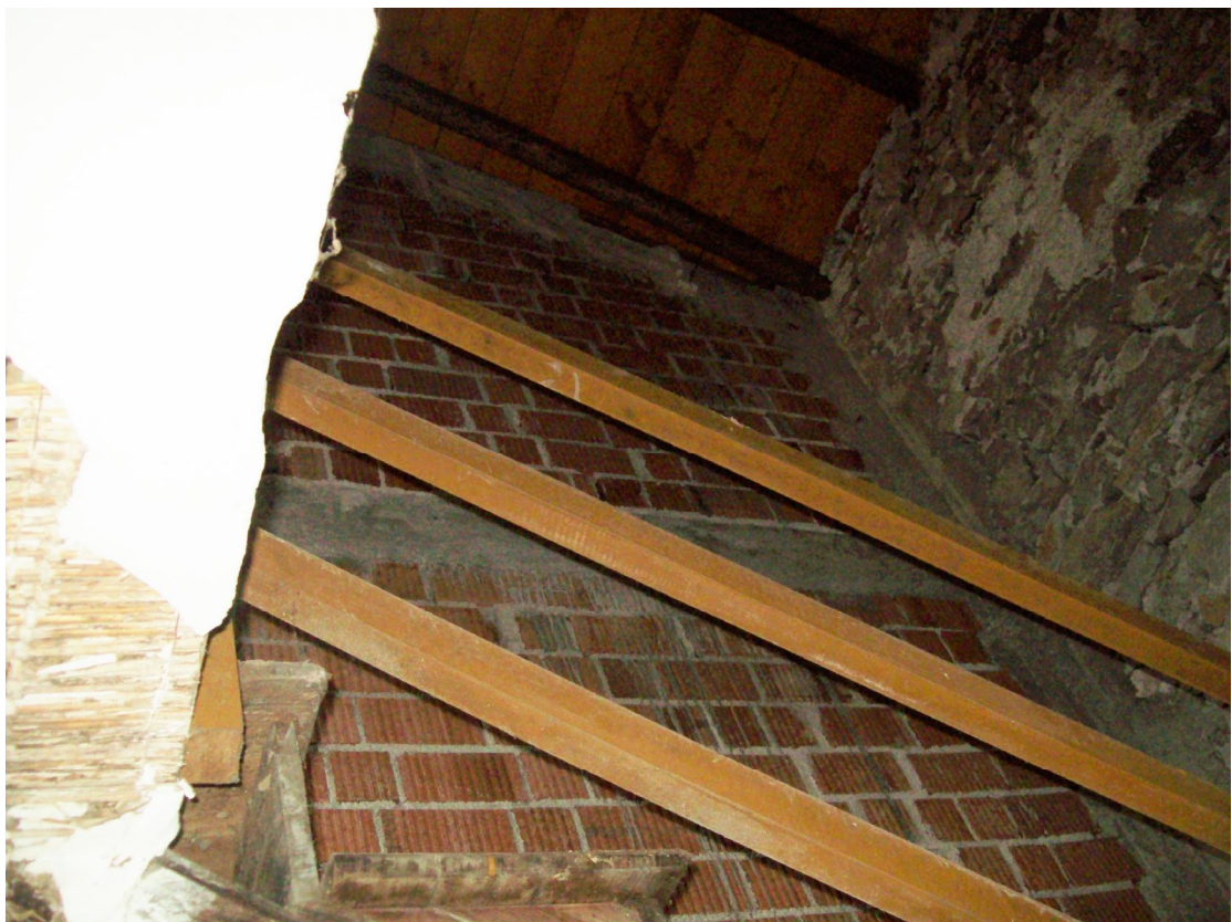
Foto 34: Parete a confine con il mapp. 335
