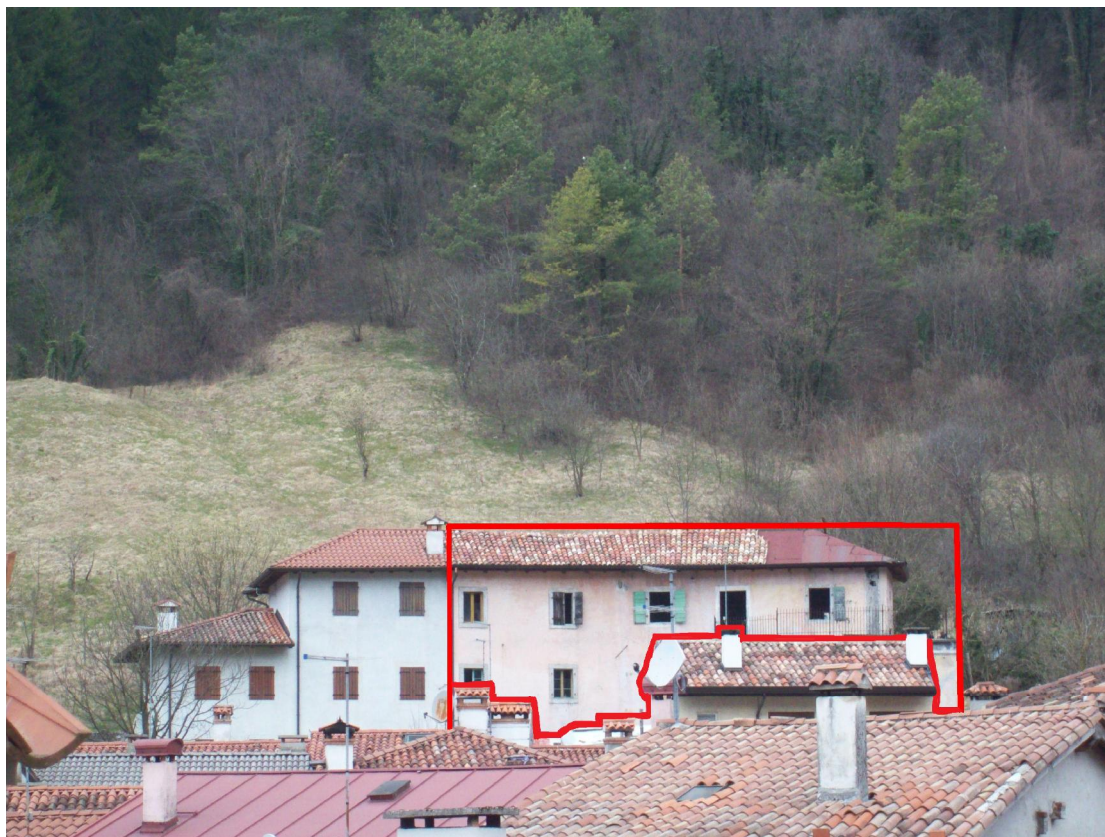
Foto 1: Vista da Sud
