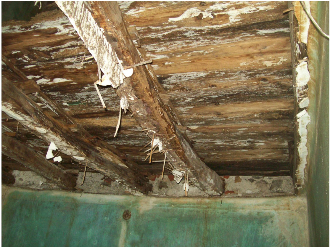
Foto 27: solaio secondo piano
