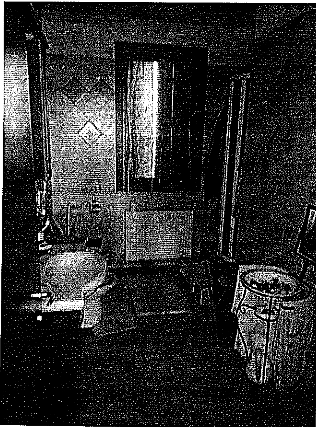
Bagno reparto notte - piano primo
