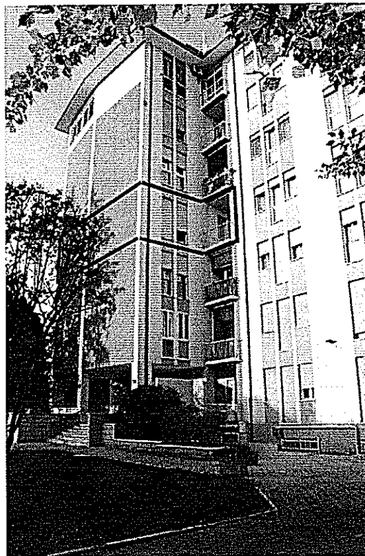
Foto n. 2 - prospetto sud fabbricato condominiale
