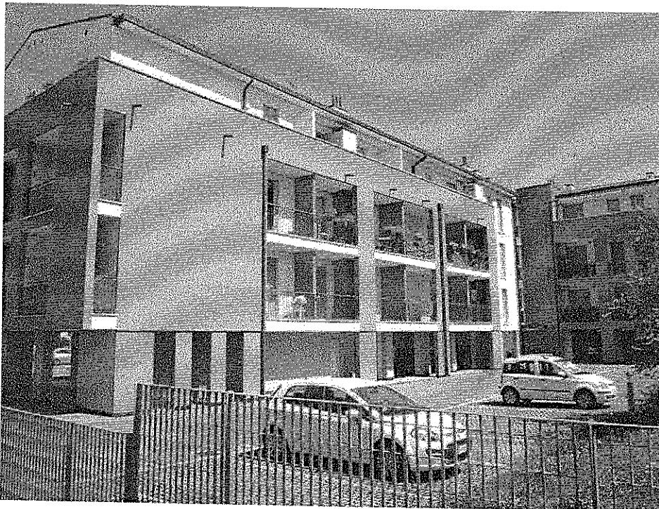
Posizione 4 - Dettaglio del prospetto sud.
