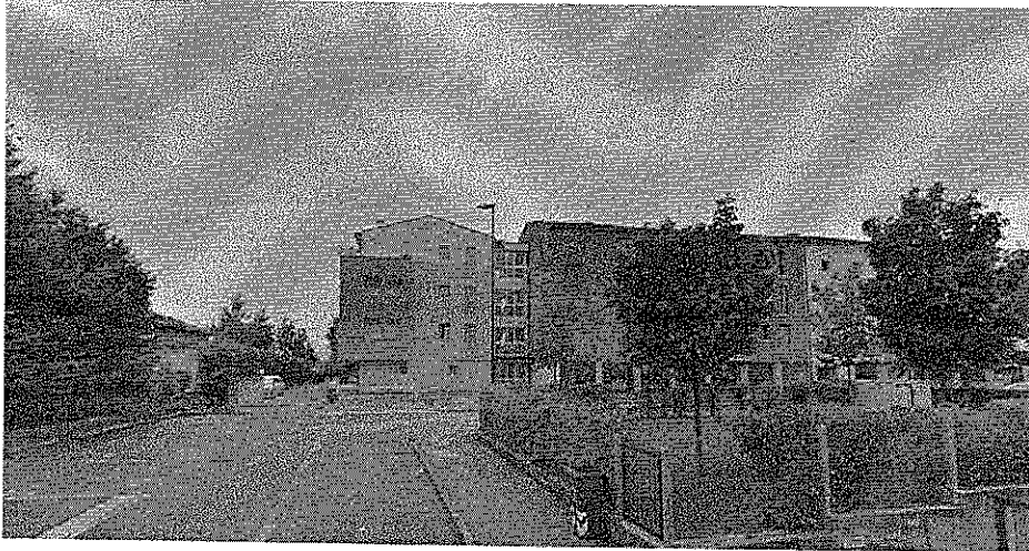
Posizione 3 - Fabbricato visto dalla strada interna di lottizzazione.
