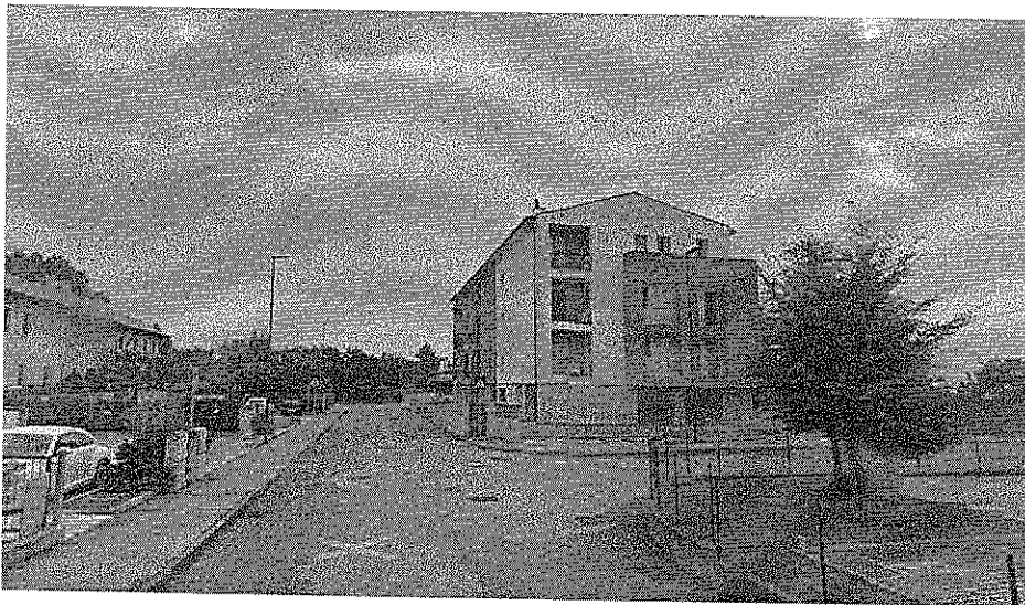
Posizione 2 - Fabbricato visto dalla strada interna di lottizzazione.
