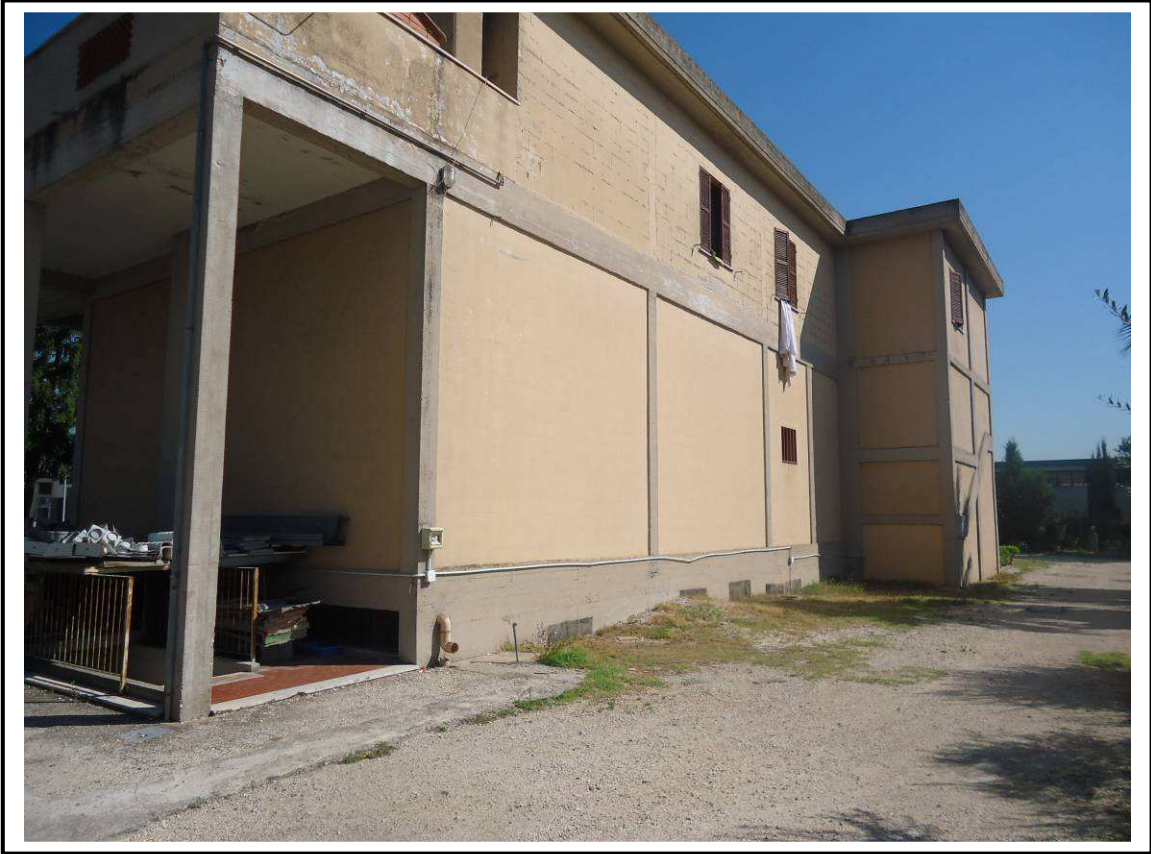
VISTA PROSPETTO SUD-OVEST
