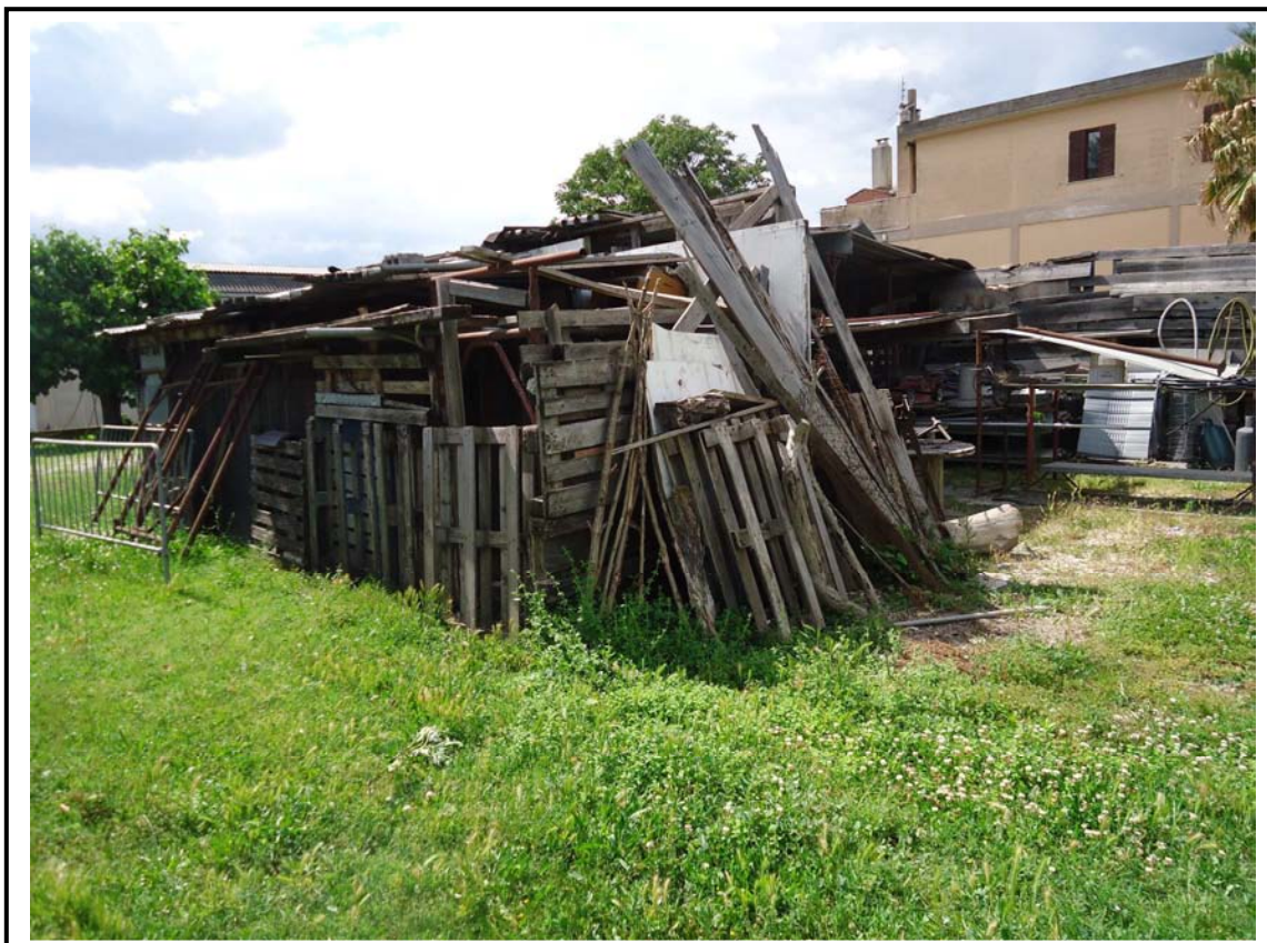
VISTA ANNESSI ESTERNI LATO SUD-EST
