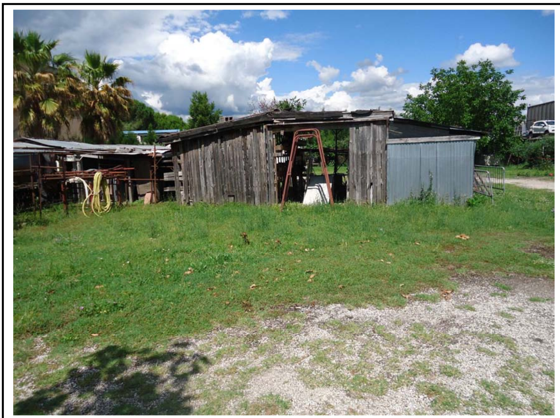
VISTA ANNESSI ESTERNI LATO OVEST CORTE PARTIC. 707
