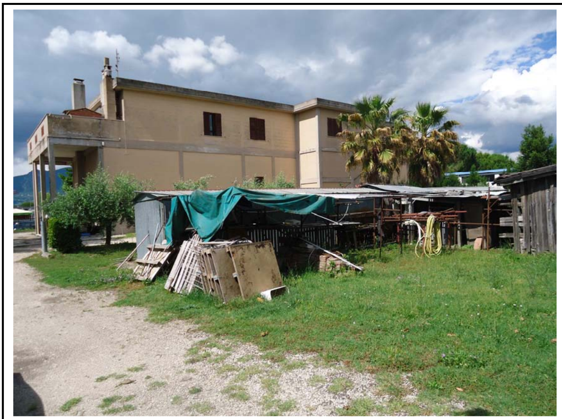
VISTA ANNESSI ESTERNI LATO SUD-OVEST CORTE PART. 707
