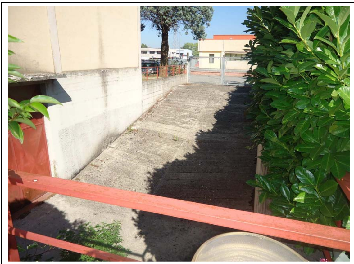
VISTA RAMPA LATO EST
