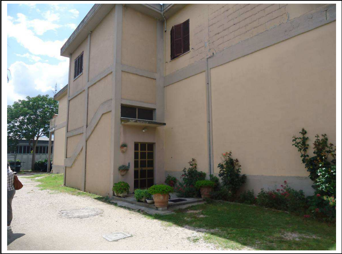
VISTA PROSPETTO SUD
