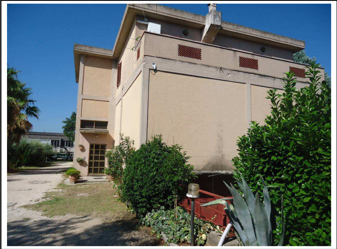
VISTA PROSPETTO EST
