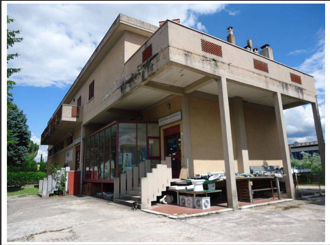
VISTA PROSPETTO NORD-OVEST
