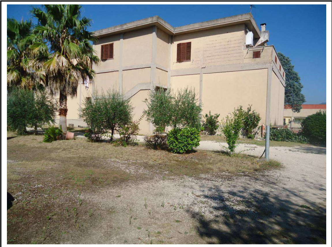
VISTA PROSPETTO SUD-EST
