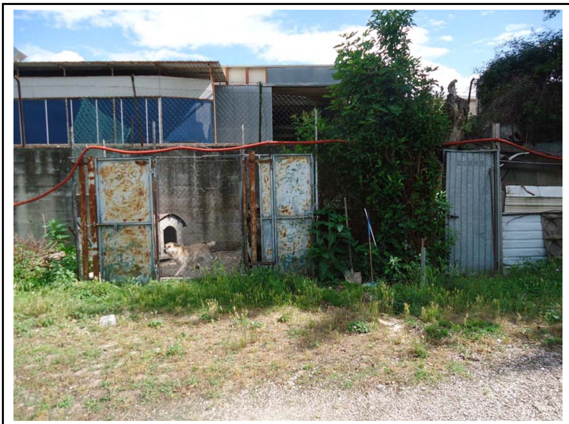
VISTA ANNESSI ESTERNI LATO SUD
