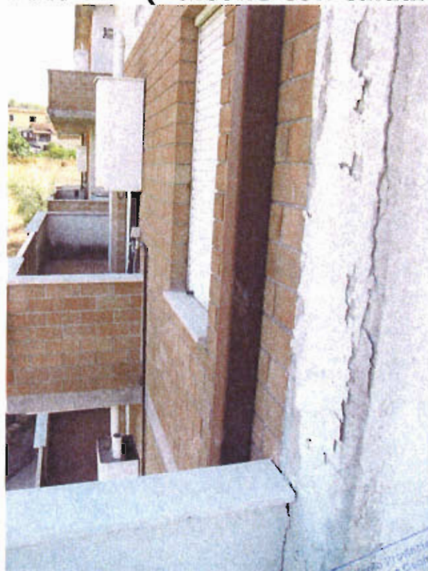
Foto 11 (Balcone con caldaia autonoma)
