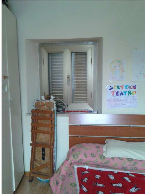
Foto 17: Seconda finestra in alluminio/vetro aperta in camera con pavimento in legno
