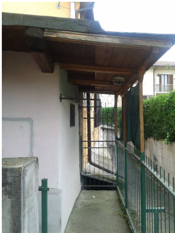
Foto 4: Tettoia sul retro del ripostiglio
