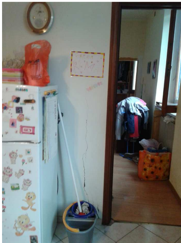
Foto 20: Ingresso alla camera con pavimento in legno
