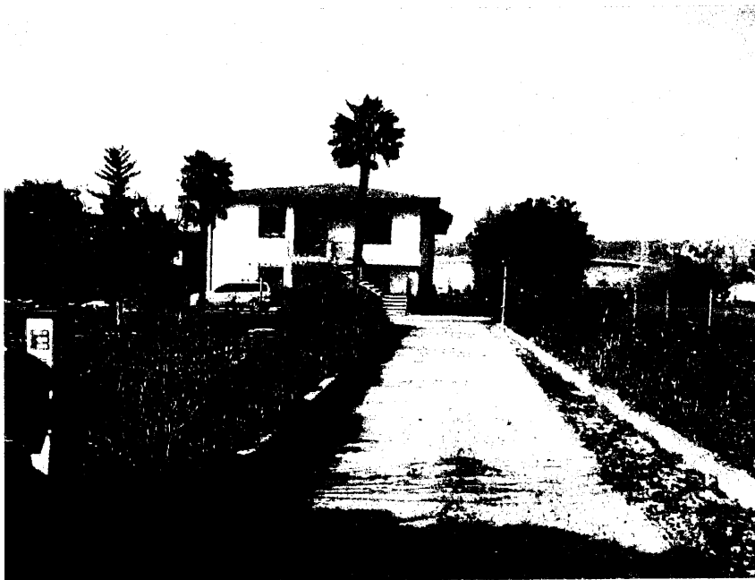
FOTO 1: vista prospetto esterno - strada ingresso del condominio
