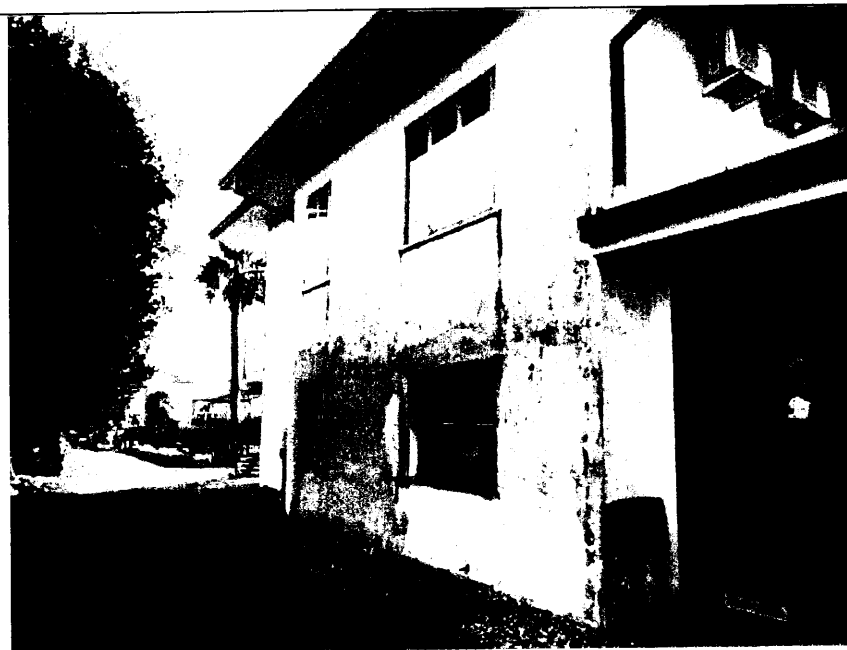
FOTO 8: vista prospetto est fabbricato residenziale
