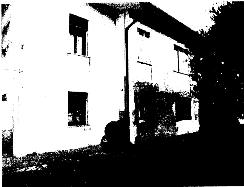
FOTO 7: vista prospetto est fabbricato residenziale
